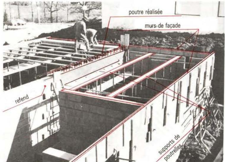
② Même poutre réalisée pour supporter les poutrelles d'un plancher
