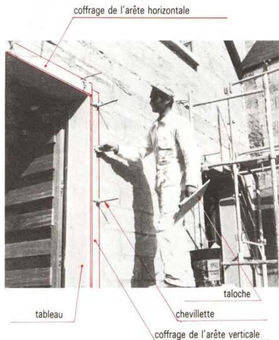
⑮ Enduit des tableaux (finition talochée)
