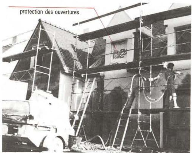
⑰ Enduit monocouche réalisé à l'aide d'un matériel de projection à la lance
