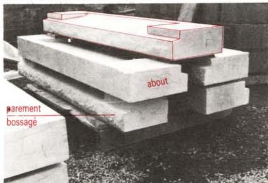
⑯ Appui de fenêtre en calcaire ferme de Chauvigny (Vienne)
