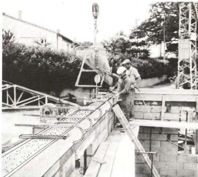
⑪ Coulage du béton du chaînage et vibration
