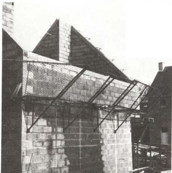
⑰ Rampant coiffé. Protection en rive.
