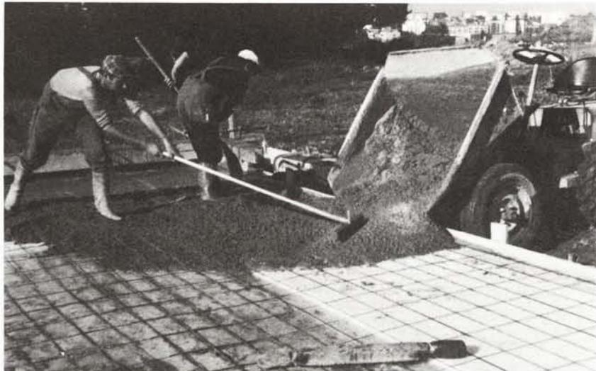
① Transport du béton avec le dumper suivi de l'épandage
