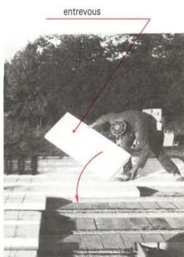
㉒ Montage composite : entrevois béton et entrevois polystyrène
