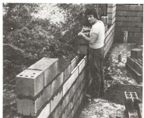
②₈ Blocs béton en U pour chaînage B.A.
