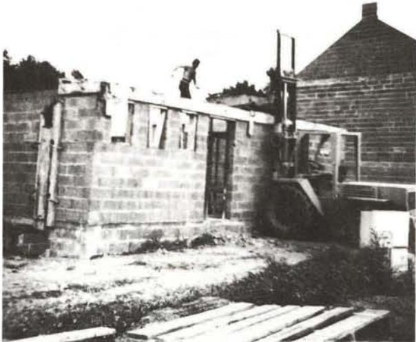
⑩ Chariot élévateur avec caisse à béton placée sur la fourche
