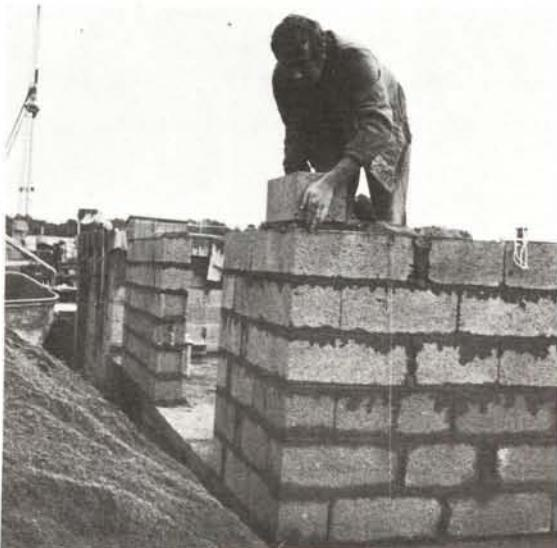
⑯ Pose d'un bloc d'angle au fil à plomb
