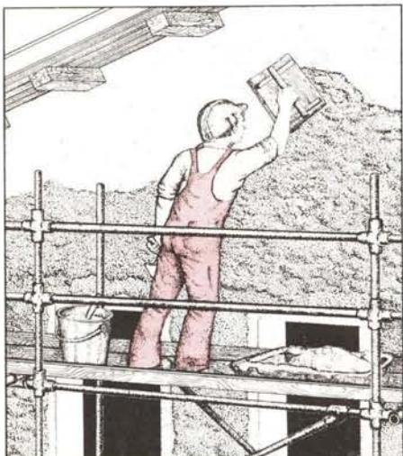
⑯ Couche de finition talochée au fur et à mesure de l'application du mortier
