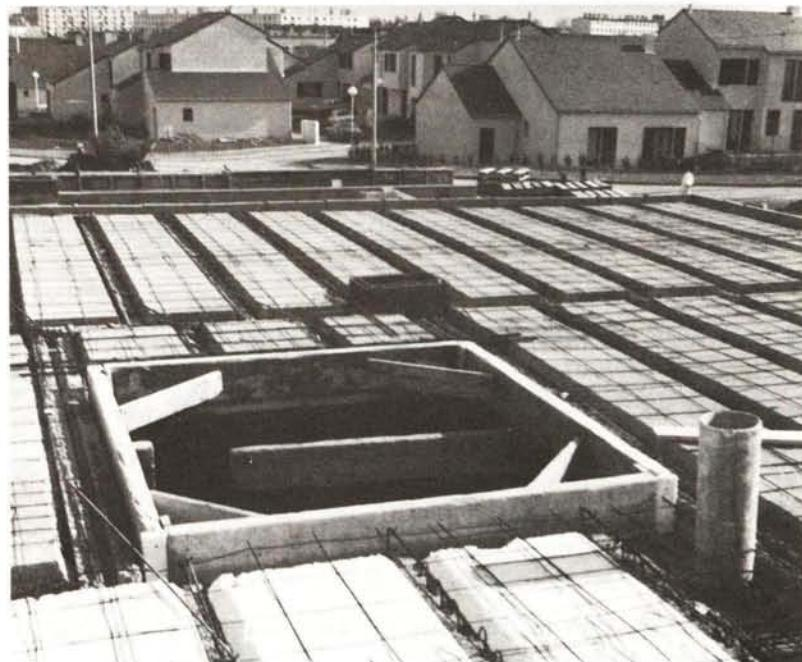
⑧ Trémie coffrée avant coulage d'un plancher
