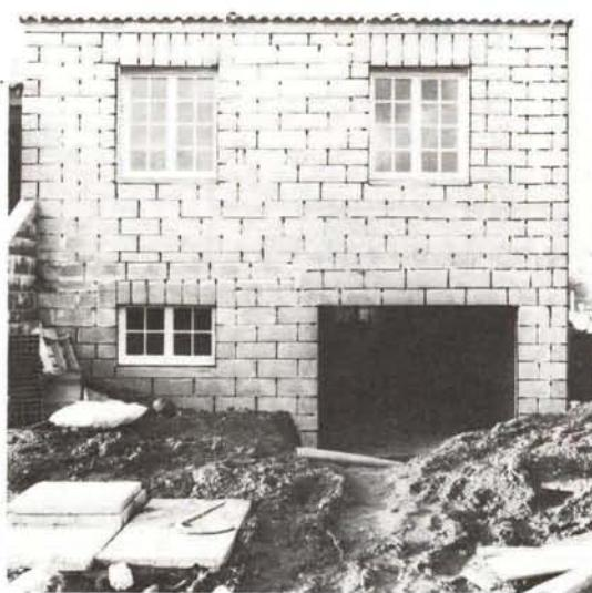
⑭ Mur de façade : linteaux avec planelles disposées verticalement ou horizontalement
