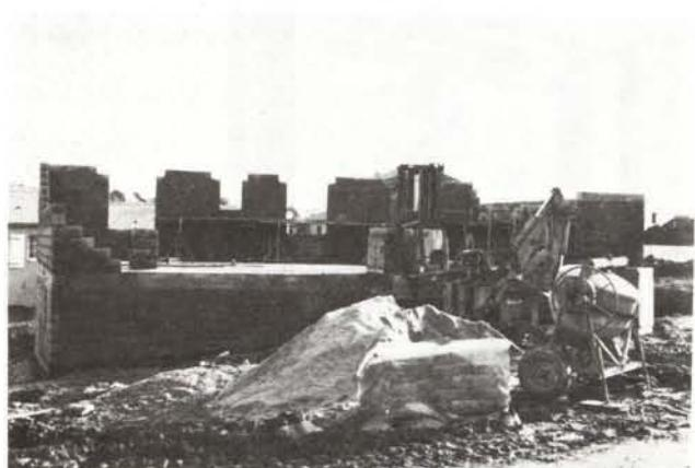
⑳ Même chantier côté ouest : stockage granulats, liant sous bâche, bétonnière, chariot élévateur avec palette de blocs
