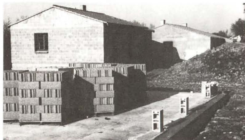
⑤ Blocs béton livrés sur palettes
