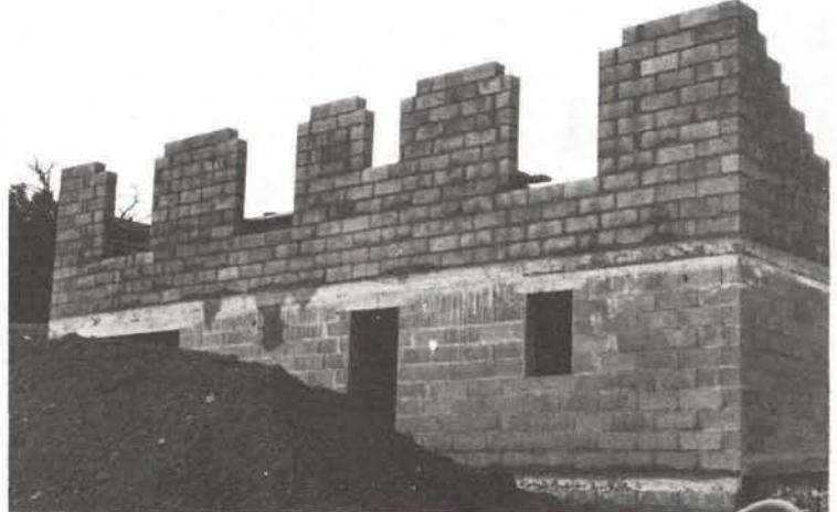
③ Mur de façade réalisé avec des blocs creux de béton de 20 cm  $\times$  20 cm  $\times$  50 cm
