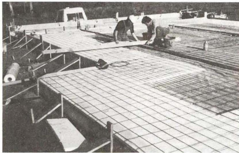
(29) Pose de l'isolant, du film étanche et du treillis soudé
