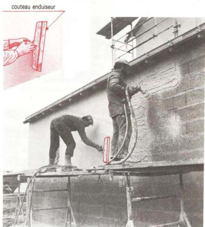
⑯ Serrage de l'enduit au couteau d'enduiseur
