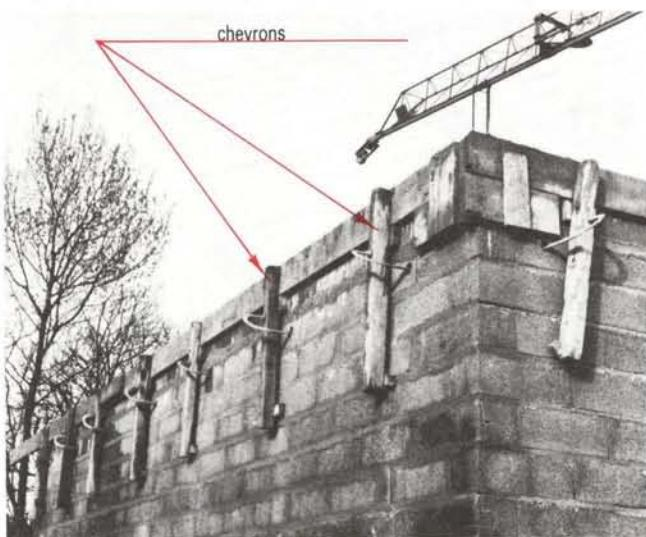
⑪ Coffrage des rives de planchers - Serrage par serre-joints
