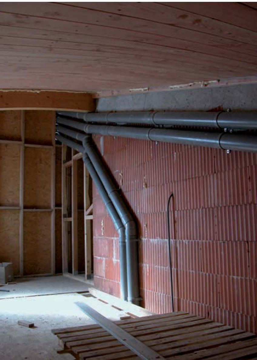
La simple poussée d'Archimède dans des tubes correctement positionnés permet de générer des flux de ventilation passive suffisants pour assurer la qualité sanitaire de l'air intérieur, sans électricité. (Architecte Raphaël Bobeda.)
