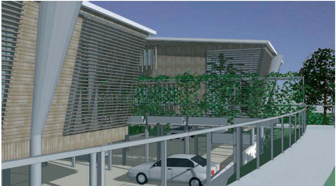
Projet de bâtiment tertiaire bioclimatique pour la SCI Espace Bio alternatif à la Duranne, près d'Aix-en-Provence (13). 1 464 m 2 de SHON, ossature bois, isolation ouate de cellulose et VMC double flux. Performance prévue : 20 % de la RT 2005 (Cep 5 postes : 30 kWhep/m 2 .an). Si on ne tient pas compte du climat qui l'environne, un bâtiment devient une source majeure de consommation d'énergie pour compenser le confort oublié dans sa conception. Une protection solaire adaptée supprime le besoin de climatisation. (Architecte Jérôme Solari.)
