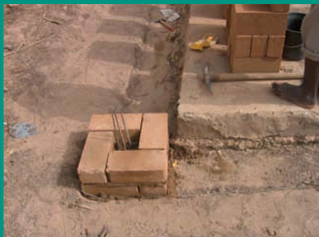
Base de pilier de 30 x 30 cm pour une école en Afrique. Au centre, les ferrailages assurent la liaison avec les autres éléments et stabilisent la structure.
