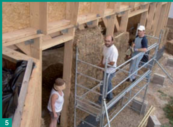
Sur cette construction, l'isolant paille est monté entre solives.
