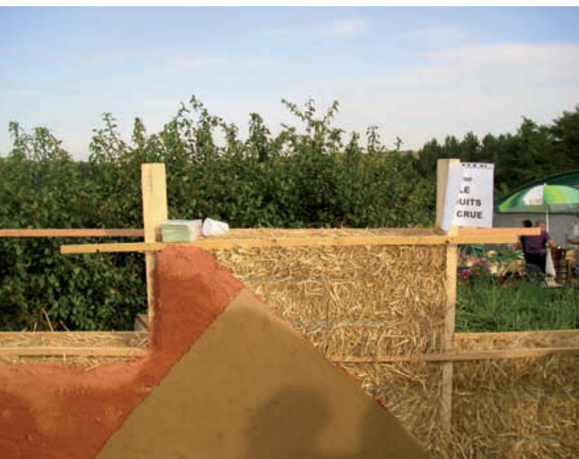
Principe constructif d'un mur en bois et paille avec enduit chaux ; échantillon démonstratif de la structure interne d'un mur bois-paille sur un chantier bioclimatique. (Architecte Stéphane Peignier.)
