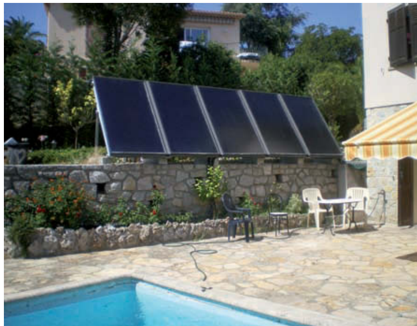
Ces capteurs solaires, orientés plein sud à 60°, alimentent une chaudière solaire et peuvent être déchargés en été dans la piscine, évitant une surchauffe nuisible à l'installation.
