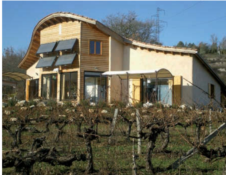
Maison en Provence (voir aussi page 207). Pièces techniques, matériaux lourds et inertie au nord, cette maison s'ouvre au soleil vers le sud par une serre bioclimatique en bois et paille. La ventilation naturelle balaie transversalement l'ensemble des volumes habitables, depuis la serre vers la partie arrière nord, avant de remonter vers le sud à l'étage. (Architecte Raphaël Bobeda – Cabinet Architecture Naturelle.)
