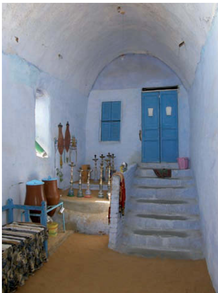
Maison en Égypte, dans la région d'Assouan. Les deux moucharabieh sont positionnés sous la fenêtre, au niveau du flux d'air. On remarquera le sol enterré par rapport à l'extérieur, pour valoriser la fraîcheur de l'inertie terrestre. (Photo Claire Cornu.)
