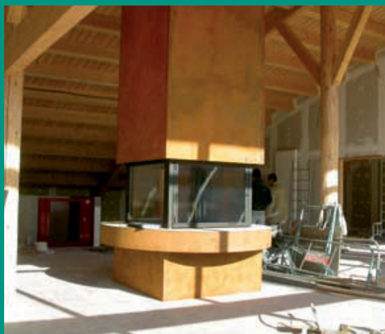
Chauffage par un insert central à bois ouvert sur ses 4 faces.
