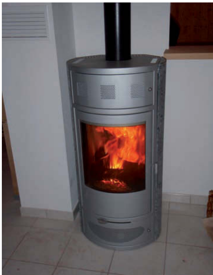
Poêle à bois avec échangeur hydraulique. (Photo Vincent Pierré, énergéticien BET Terranergie dans les Vosges.)
