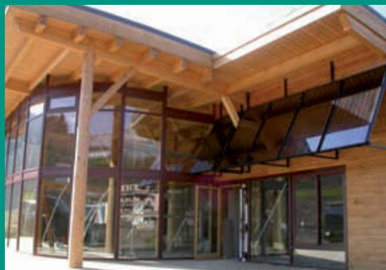
Retour vitré vers l'est favorisant l'éclairage matinal, avec capteurs solaires en brise-soleil.
