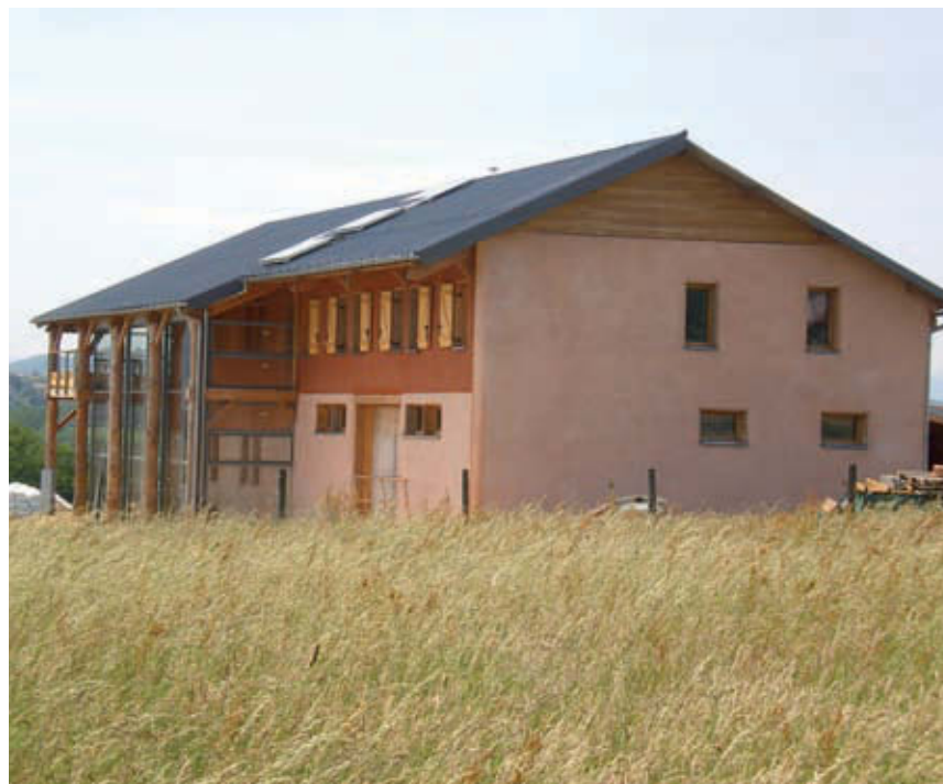
Chantier bioclimatique pour le Jardin de Cocagne à La Tour-de-Salvagny (Rhône). Projet réalisé d'avril à octobre 2008. Bâtiment bioclimatique de 500 m 2 (SHON) à ossature bois porteuse et isolation paille, terre et chaux, avec mur Trombe à accumulation, puits canadien, photovoltaïque. Un bâtiment passif, à énergie positive, n'est pas une vue de l'esprit, mais d'abord une volonté du maître d'ouvrage.
