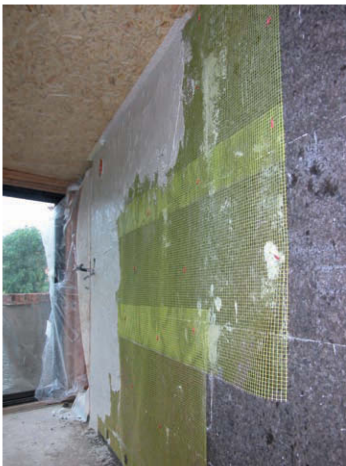
Pose d'une isolation en liège. Le parement doit rester respirant, laissant la vapeur d'eau circuler librement.
