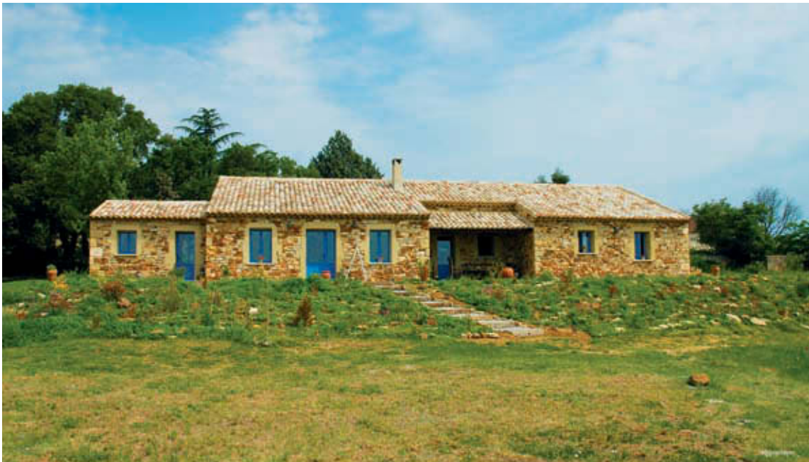
La première qualité d'une construction bioclimatique doit être l'adaptation à son environnement, par les matériaux employés et par ses formes. Ici, maison bois-paille et brique doublée de pierre à Vallabrix (30). (Photo et réalisation Les Charpentiers d'Uzès.)
