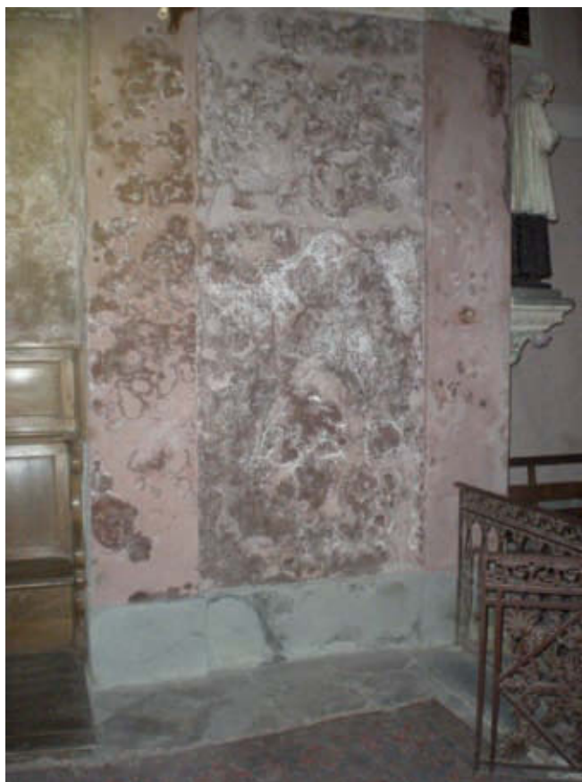
Les remontées capillaires dans les matériaux, comme ici à travers le dallage de sol d'une cathédrale, engendrent l'apparition de salpêtre, des taches peu esthétiques.
