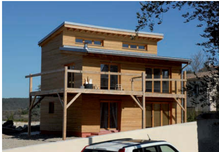
Une forme compacte permet de limiter au maximum les déperditions par les parois et n'interdit pas une valorisation optimale des apports solaires. (Photo et réalisation Les Charpentiers d'Uzès.)
