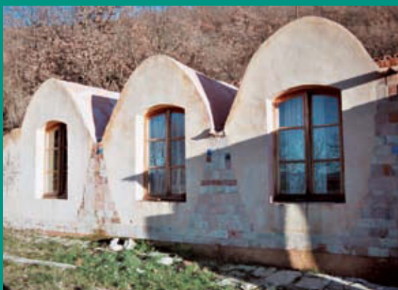
Les voûtes nubiennes : exposées au nord-ouest, elles recouvrent 3 chambres de plan rectangulaire.
