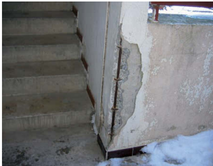
Le béton se détériore au fil du temps, d'autant plus vite s'il a été mal mis en œuvre. À titre d'exemple, les différences de dilatation entre le fer et le béton font parfois éclater ce dernier.
