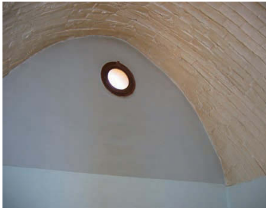
Voûte en BTC réalisée sur le modèle de la voûte nubienne. Recouverte d'une toiture en tuiles, fortement ventilée, elle assure à ses occupants un grand confort d'été. (HLM Vaucluse Logement.)
