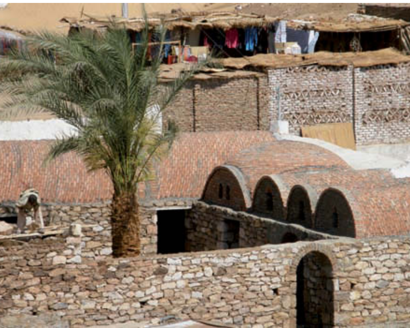
Dans la région d'Assouan, en Égypte, ces constructions – des logements –, qui mettent en œuvre des voûtes nubiennes, utilisent quasi exclusivement des matériaux de proximité : brique, terre, chaux, bois de palmier. La densité urbaine permet de limiter les parois exposées aux intempéries comme à la fournaise solaire. La terre crue a toujours été un matériau idéal pour assurer le confort des habitations. (Photo Claire Cornu.)
