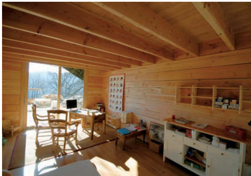
Ce chantier concerne la construction d'une extension de maison d'habitation, pour une surface de 130 m 2 , dans la haute vallée du Gardon d'Alès. L'habillage extérieur est en bardeaux de red cedar, les fenêtres en châtaignier. Structure bois haute isolation et plancher bois phonique. (Photo et réalisation Les Charpentiers d'Uzès.)
