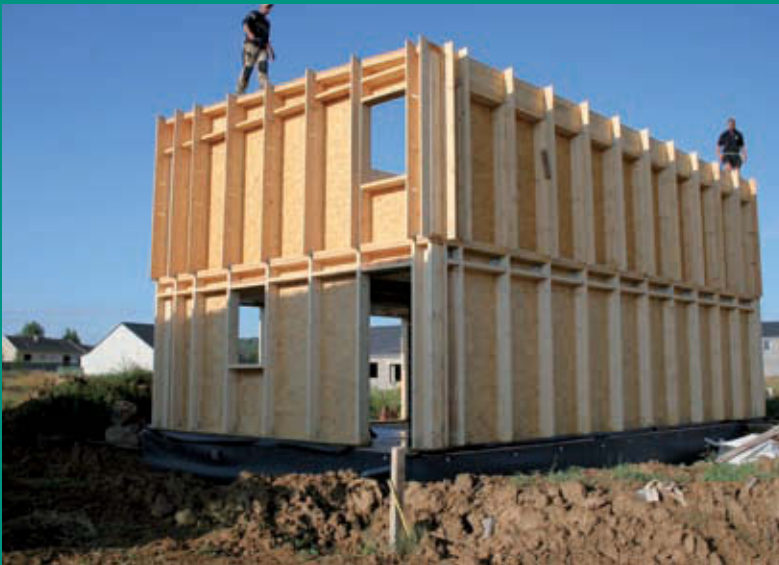
Les constructions bois-paille peuvent être réalisées très rapidement, grâce à la préfabrication en atelier de la plupart des constituants.
