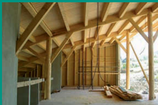
Charpente du hall central en cours de construction.
