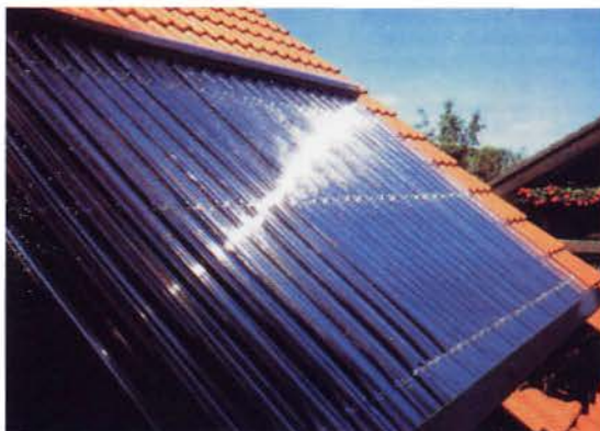
fig. 3-12 Collecteurs plats installés sur une toiture inclinée
