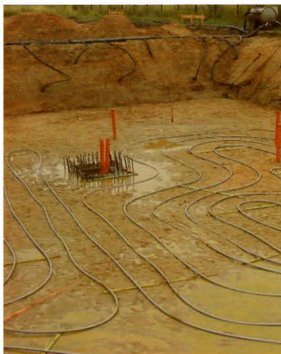
fig. 3-18 Un collecteur de chaleur souterraine enfoui horizontalement
