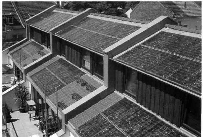
fig. 3-10 Module solaire au silicium du fabricant Solarworld
