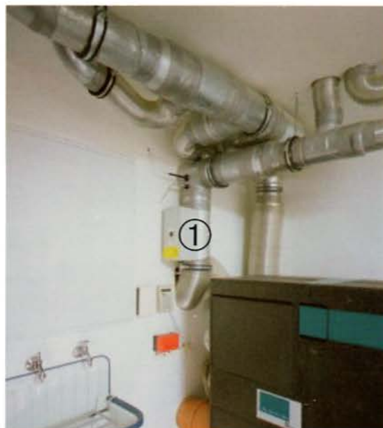
fig. 5-10 Installation de ventilation et chauffage additionnel électrique (1)
