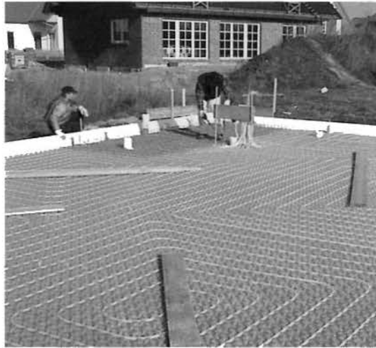
fig. 2-15 Plancher chauffant par-dessus la couche de béton isolant
