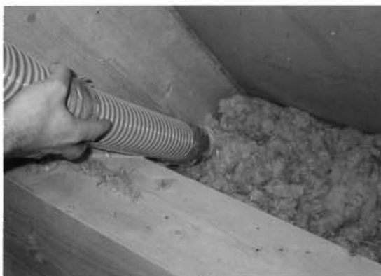
fig. 2-31 Photo de l'isolation du chevron
