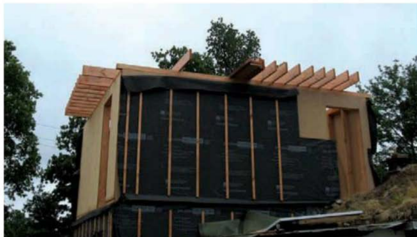
Façade ouest. Un escalier métallique y sera installé pour accéder à la toiture-terrasse. Un débord de 60 cm permettra d'en faire le tour sans piétiner la terre. Ce débord protégera aussi les façades de la pluie et du soleil d'été.
