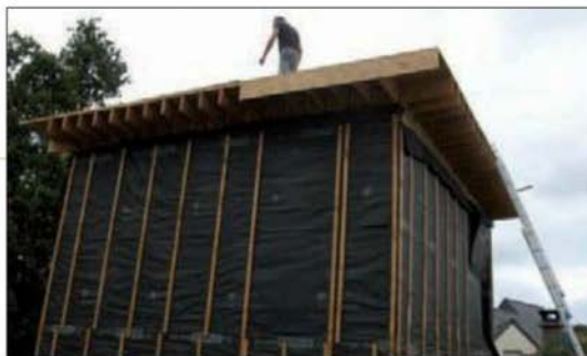
Mise en place des bandes de rive, ici des morceaux d'OSB découpés sur le toit et vissés depuis la plateforme.
