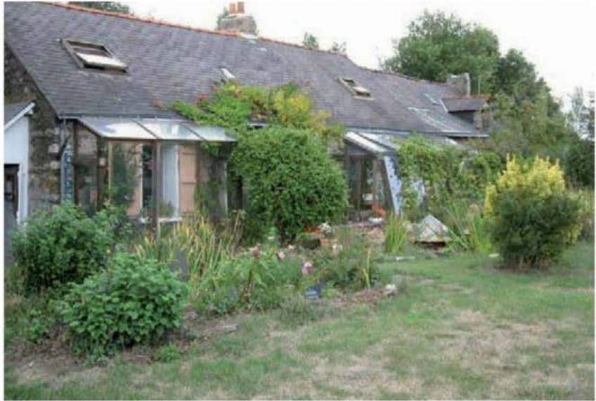
Maison des Baronnet en Loire-Atlantique : au sud, une simple serre faite avec des verres de récupération isole la maison et concentre les rayons du soleil sur la masse des murs.
