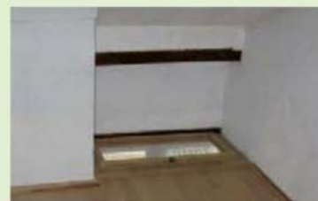
Dans la chambre 3, une fenêtre de sol laisse monter l'air chaud du premier niveau.
