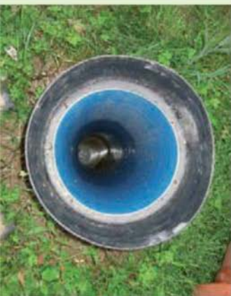
L'entrée du puits est constituée par un tuyau vertical de 300 mm de diamètre. On voit ici le départ du tuyau horizontal (tuyau de 160 mm), la bouche d'aération étant fermée par un grillage pour empêcher les rongeurs d'y élire domicile (très important !). Au fond, un reflet d'eau indique la présence du condensat, qui résulte de la précipitation de la vapeur d'eau au passage de l'air contre les parois plus fraîches.
