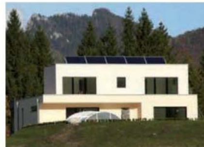
Ces panneaux solaires chauffent l'eau utilisée dans la maison, tant dans la cuisine que dans la salle de bains... (Photo Ampere).
