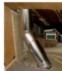
Installation d'un puits de lumière. (Photo Lumitube-solaire.)
