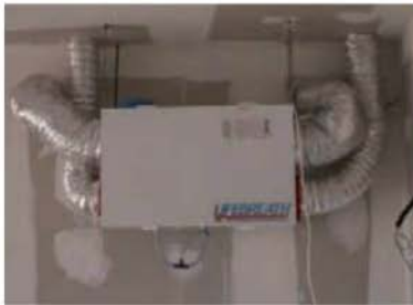
La centrale de ventilation mécanique à récupération de chaleur du constructeur Lifebreath. (Photo société Lifebreath.)
