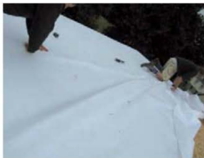
Le feutre est étendu sur le toit. Il doit permettre de créer une micro-ventilation entre la bâche imperméable et la partie supérieure des dalles OSB, de manière à évacuer les condensats.
