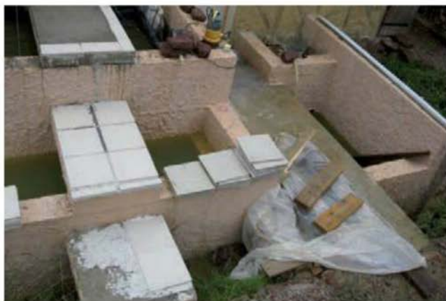
Le système Arca Minore de cuves de stockage aérien de l'eau de pluie en cours de réalisation. Dans ces 4 réservoirs, nous pouvons stocker plus de 5 000 l. L'expérience de l'autonomie totale montre, qu'avec des toilettes sèches, nous dépensons 50 l d'eau par jour à deux : nous avons donc 100 jours de réserve.
