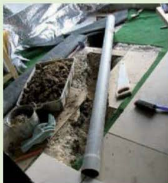
L'arrivée d'air frais du poêle en cours de travaux, puis terminée. Elle est aussi le débouché du puits canadien. Sans elle, on perdrait 30 % de l'effet de chaleur.
