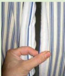
Sur chaque côté et en bas des rideaux isolants, des bandes Scratch permettent de les fermer hermétiquement. En revanche, la stratification de l'air permet de laisser le haut ouvert : la présence de l'air le plus chaud fait obstacle à la pénétration de l'air froid.
