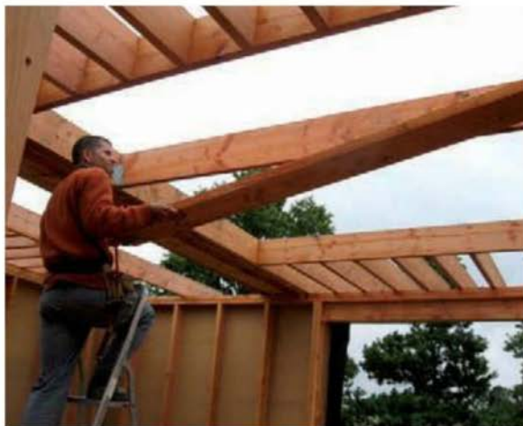
Mise en place de la charpente : devant soutenir une toiture végétale de plusieurs tonnes, les solives sont hautes de 22,5 cm, longues de 7 m environ.
