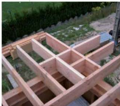
L'assemblage est fondamental. Le charpentier a réalisé ici des coupes à mi-bois pour les 4 angles.
