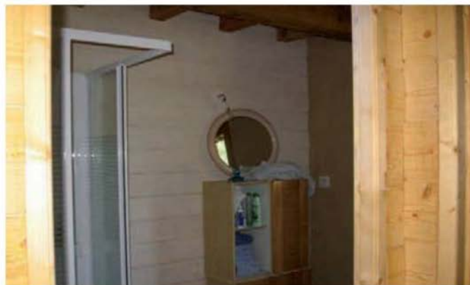
Dans cette maison écologique en bois, ce matériau est également présent sur 90 % des murs de la salle de bains. Mais il y a peu de problèmes de condensation. En effet, le mur qui sépare cette pièce du dehors est en bottes de paille, avec enduit terre à l'intérieur et à l'extérieur. La vapeur d'eau sort donc tout naturellement.
