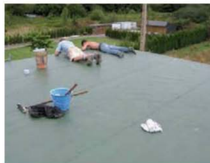
La toiture est à présent étanche, prête à recevoir le toit végétal.
