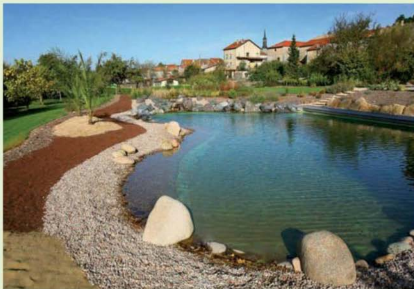
Une piscine biologique fraîchement achevée. L'implantation en village a ici imposé un bassin régénérateur court, donc un système de pompage puissant. (Conception et photo Aquatiss.)
