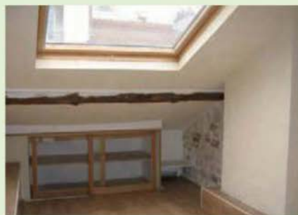
Le grand Velux plein sud d'une des chambres créées dans les combles. Notez que le conduit de cheminée n'a pas été retiré ; il représente une imposante masse thermique. Sous le plafond en plaques de plâtre se cache un isolant mince multicouche. Le R global de cette pièce dépasse les 4.
