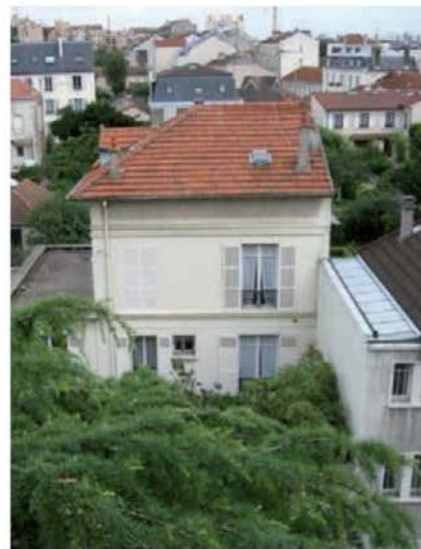
Cette maison est orientée au sud-ouest, mais son toit reçoit, l'hiver, le vent du nord de plein fouet. Le faîtage monte à 2,5 m à partir du deuxième niveau, l'angle est à 45°, la maison mesure 15 m de long et 10 m de large, c'est donc un toit d'environ 200 m 2 qu'il convient d'isoler : un gros travail en perspective.
