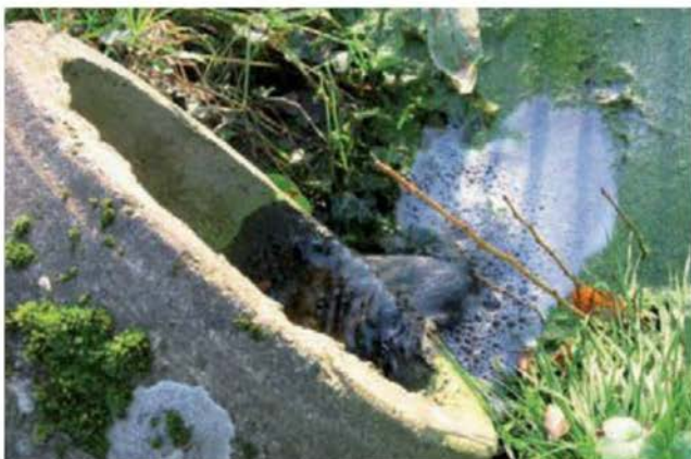
Déversoir de la lagune du village de Saint-Gonlay (Ille-et-Vilaine). Tout arrive mêlé, eaux grises et blanches. Néanmoins, le traitement totalement naturel par le soleil, les bactéries et les algues transforme cette eau noirâtre en une eau transparente.
