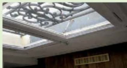
Bouche d'entrée de l'air froid, placée juste sous la fenêtre.
