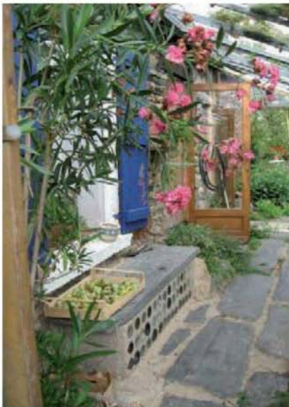
Dans cet exemple, qui nous vient encore des Baronnet, notez le banc formé de bouteilles remplies d'eau prises dans le béton. C'est un grand stockeur de chaleur, qui permet de ne pas investir dans une véranda à double vitrage (quand il fait 10 °C à l'extérieur, l'intérieur de la serre est à 20 °C s'il a fait beau).
