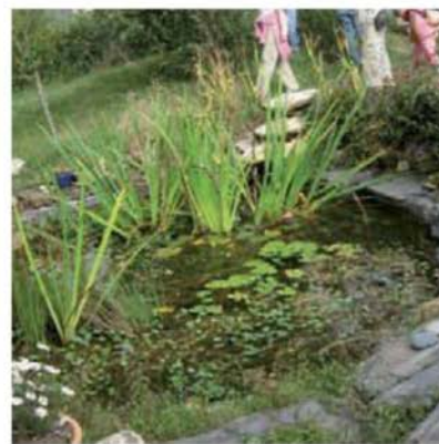
Filtre planté pour les seules eaux grises de la maison autonome des Baronnet, en Loire-Atlantique. Au premier plan, à droite, les vasques remuent l'eau, l'oxygénant et la dynamisant.
