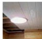
Éclairage d'une pièce sombre. Le puits de lumière, réfléchissant, conduit la lumière sur plusieurs mètres à partir du toit. (Photo Lumitube-solaire.)
