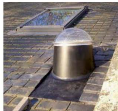
Puits de lumière. La prise de lumière se fait sur le toit. (Photo Lumitube-solaire.)
