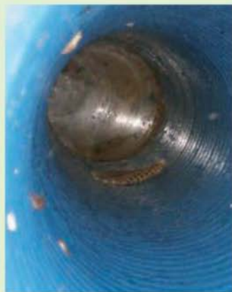
L'entrée du puits est constituée par un tuyau vertical de 300 mm de diamètre. On voit ici le départ du tuyau horizontal (tuyau de 160 mm), la bouche d'aération étant fermée par un grillage pour empêcher les rongeurs d'y élire domicile (très important !). Au fond, un reflet d'eau indique la présence du condensat, qui résulte de la précipitation de la vapeur d'eau au passage de l'air contre les parois plus fraîches.
