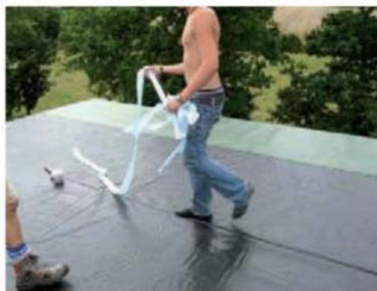
Pose de l'anti-racinaire en toiture : les bandes sont collées avec des rouleaux de Scotch spécial double face.
