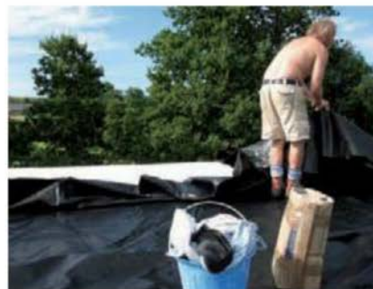
Mise en place de la bâche, d'un seul tenant.
