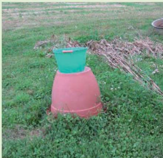
Pour empêcher l'eau de pluie d'y pénétrer, l'entrée du puits canadien est recouverte d'un pot en plastique lesté d'un seau rempli de sable (pour éviter que le vent l'emporte).
