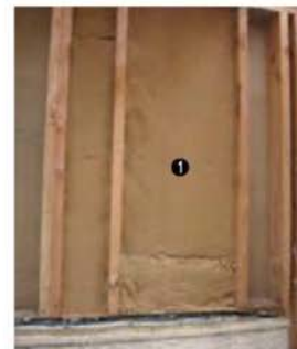
Mur en ossature bois côté intérieur. Pour protéger l'ossature bois des remontées capillaires du sol, les éléments sont appuyés sur une bande étanche (en plastique noir) qui s'interpose entre la maçonnerie et le bois. On voit à droite le remplissage de la structure avec des panneaux de laine de bois (1), qui seront recouverts d'un freine-vapeur, un papier semi-perméable soigneusement collé sur les montants de l'ossature. Si on l'agrafe en plus, on devra recouvrir toutes les agrafes d'une pastille... C'est dire le soin qu'il faut accorder à la mise en place de ce freine-vapeur (prototype Arca Minore).
