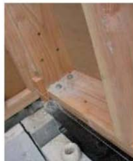
Mur en ossature bois côté intérieur. Pour protéger l'ossature bois des remontées capillaires du sol, les éléments sont appuyés sur une bande étanche (en plastique noir) qui s'interpose entre la maçonnerie et le bois. On voit à droite le remplissage de la structure avec des panneaux de laine de bois (1), qui seront recouverts d'un freine-vapeur, un papier semi-perméable soigneusement collé sur les montants de l'ossature. Si on l'agrafe en plus, on devra recouvrir toutes les agrafes d'une pastille... C'est dire le soin qu'il faut accorder à la mise en place de ce freine-vapeur (prototype Arca Minore).
