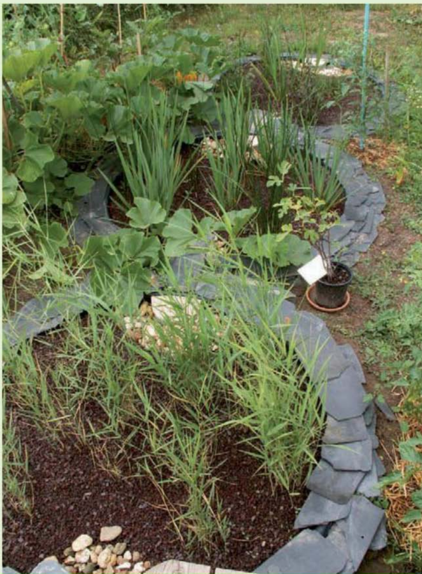
Les galets disposés en colonne à l'entrée et à la sortie du bassin facilitent la répartition homogène de l'effluent. (Photo LABEL VERTE.)
