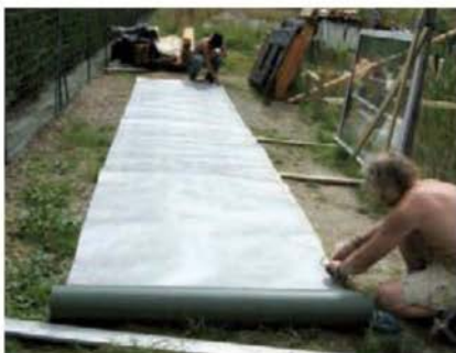
Cette bâche ne résiste pas, à terme, aux rayons ultra-violets qui la décolorent ; les piétinements, les griffes des oiseaux, voire certaines racines risquent en outre de finir par la déchirer. C'est pourquoi nous avons posé une troisième couche, un anti-racinaire de couleur verte, dont les bandes ont été découpées à même le sol.
