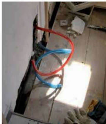
La plomberie en tuyaux souples armés : rouges pour l'eau chaude, bleus pour l'eau froide.
