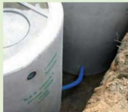
La jonction entre les cuves (ici entre la première et la deuxième) se fait au moyen d'un tuyau semi-rigide en polyéthylène, recouvert d'une gaine de protection. Par conséquent, le niveau de l'eau est le même dans les 3 citernes. (Photos Bruno Onfray.)
