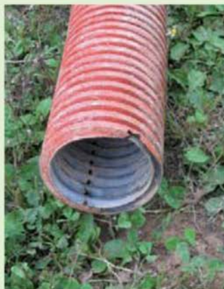
Vues du type de tuyau enterré à l'horizontale, sur 25 m et qui débouche devant le poêle dans la maison.
