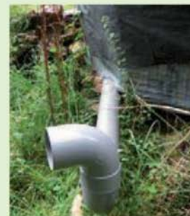
Entrée de l'air en été du puits canadien : au frais sous les arbres derrière cet édicule en construction.
