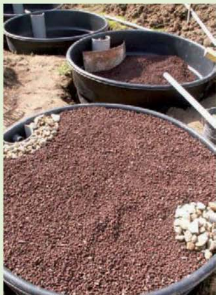
Les galets disposés en colonne à l'entrée et à la sortie du bassin facilitent la répartition homogène de l'effluent. (Photo LABEL VERTE.)
