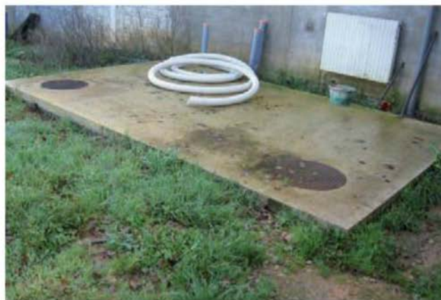
Trappe d'accès de la cuve de récupération d'eau de pluie d'un gîte rural. La cuve a un volume de 25 m 3 , ce qui représente 20 à 25 % de la consommation de ce gîte (qui peut accueillir 17 personnes) et des 3 personnes vivant à demeure. Cette eau sert exclusivement aux toilettes.
