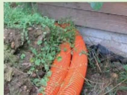
Le récupérateur à air chaud du groupe électrogène. Ce tuyau rouge à droite (l'autre est destiné au passage des câbles électriques) récupère dans le local l'air chaud émis par le groupe électrogène pour l'envoyer dans le logement. Le tuyau d'échappement est parfaitement colmaté. Au cas où, néanmoins, il fuirait, nous avons équipé la sortie de l'air dans le logement d'un détecteur de monoxyde de carbone.
