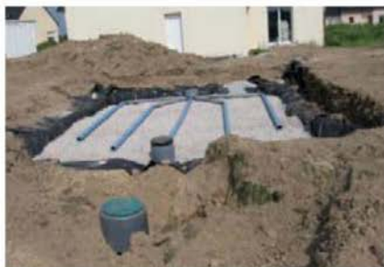
Fosse septique en attente d'être recouverte. Si l'on en juge par le niveau du terrain initial, les drains de cette fosse seront enterrés à plus de 40 cm de profondeur : les coliformes fécaux ne seront pas dégradés et resteront sous la pelouse.
