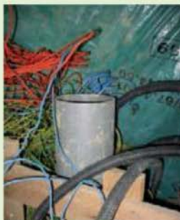
Entrée de l'air en hiver du puits canadien : à l'intérieur de l'édicule, au point le plus haut, c'est-à-dire là où se trouve l'air le plus chaud.
