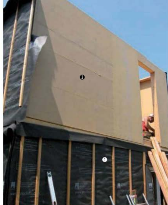
Du côté extérieur, le pare-pluie (1) a été agrafé sur des panneaux d'Agepan (2). Sa perméabilité est forte : si on s'en rapprochait, on noterait à sa surface des trous semblables aux pores de la peau. Le pare pluie est disposé en longues feuilles qui se recouvriront ultérieurement de bas en haut, comme des écailles, et seront collées les unes aux autres par de longues bandes d'adhésif ou du mastic-colle de couleur noir (prototype Arca Minore).
