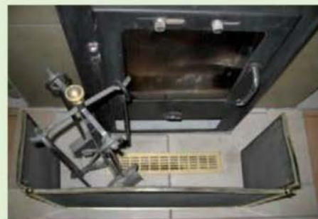
L'arrivée d'air frais du poêle en cours de travaux, puis terminée. Elle est aussi le débouché du puits canadien. Sans elle, on perdrait 30 % de l'effet de chaleur.
