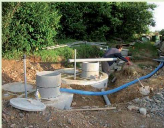
Finalisation des cuves : installation des trop-pleins permettant l'évacuation de l'eau en excédent, raccord avec la pompe immergée dans la dernière cuve (gaine bleue se dirigeant vers la maison).
