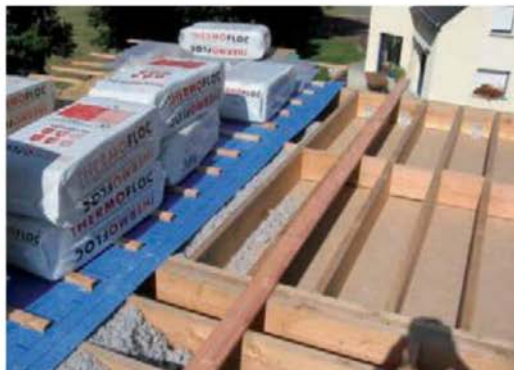
On voit bien ici les éléments d'isolation et de protection d'un toit plat : la ouate de cellulose est protégée par un film pare-pluie (bleu), sur lequel sont vissés des tasseaux, tous dans le même sens ; sur ces tasseaux sont peu à peu vissées des dalles OSB (oriented strand board).
