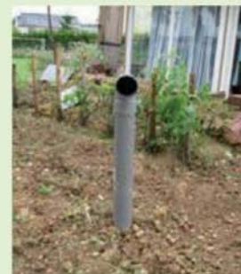
Au milieu du parcours, un tuyau vertical permet de plonger la tête d'une pompe pour retirer l'eau de condensation qui tend à s'accumuler en bas du puits canadien.
