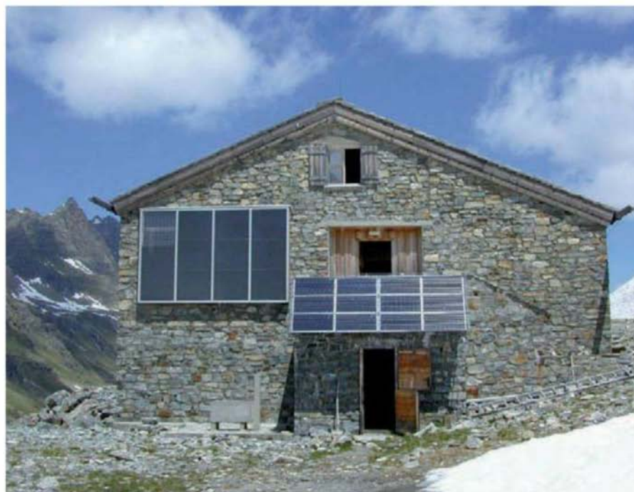
Capteurs d'air chaud placés sur la façade sud d'un refuge en haute montagne.
