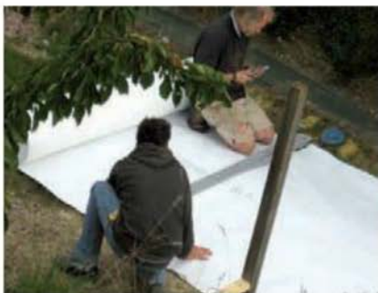
L'étanchéité est ici réalisée à l'aide de produits type bâches en matière plastique. Ces bâches, habituellement utilisées en fond de bassin, sont parfaitement étanches et non respirantes, ce qui peut à terme permettre un confinement de l'humidité contre la dalle OSB. C'est pourquoi on intercale un feutre géotextile, d'abord découpé à terre.
