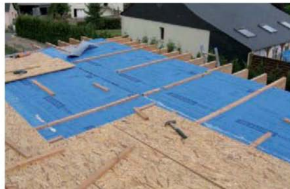
Les dalles OSB sont à présent presque toutes posées. L'air va circuler entre le film pare-pluie bleu et la face interne des dalles OSB, grâce au vide d'air ménagé au moyen des tasseaux sur lesquels reposent les dalles. Cette ventilation est fondamentale, pour éviter toute humidité, notamment celle qui pourrait venir du toit végétal si des infiltrations, ou des condensations, se produisaient.
