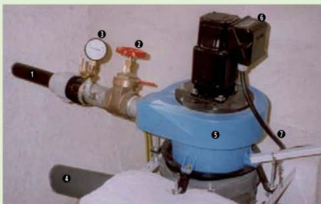
Le système est monté : on découvre l'arrivée d'eau (1) avec sa vanne de fermeture (2) et son indicateur de pression (3), son départ (4), la turbine (5) que l'on a vue ouverte précédemment. Au-dessus de la turbine se trouve un générateur (6), muni d'un régulateur. Comme il se doit, c'est du régulateur que part le fil qui transporte le courant (7). (Photo Jean-Luc Girard/Passerelle éco.)
