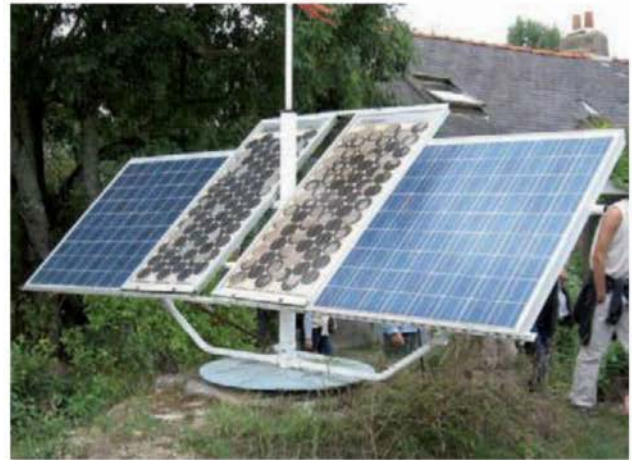
Panneaux photovoltaïques associant des capteurs polycristallins, au centre, et monocristallins, en périphérie (maison autonome de Patrick Baronnet). Notez qu'ils sont fixés sur un bras mobile, chargé de les orienter face au soleil.
