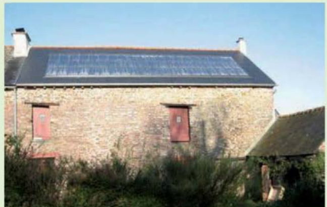
Les 10 panneaux solaires thermiques du toit.
