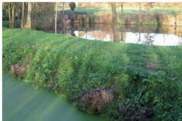
Deux lagunes, la première à microphytes, la deuxième à macrophytes, dans le même village. Sept maisons sont raccordées à ces deux étangs.
