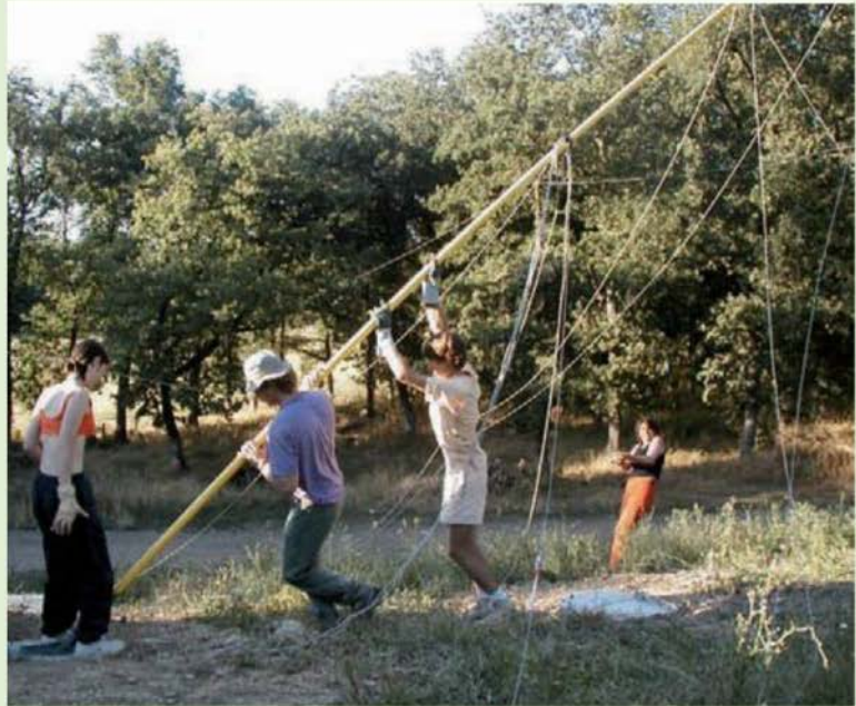
L'éolienne s'installe à 12 m de hauteur sur un mât articulé, donc rabattable en cas de fort coup de vent. (Photo Christine et Laurent Choplin.)
