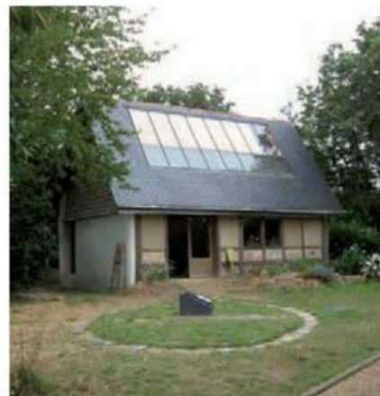
Les Baronnet font certainement partie, en France, des pionniers de l'habitation autonome et passive. Leur prototype, aux murs en paille et en terre, ne demande à être chauffé qu'à partir du mois de janvier ! Et très peu : l'inertie thermique est telle qu'il suffit seulement de chauffer de quelques degrés. Cet exemple se visite en Loire-Atlantique.
