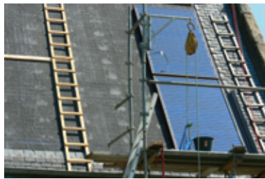
Fig. 7.5 Installation de panneaux solaires
