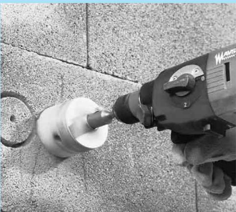
**Figure 228 : Trou de boîtier à la scie cloche**
