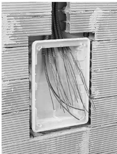
Les tableaux à sceller se composent d'une cuve isolante, d'un châssis avec rail, d'un plastron et d'une porte.
