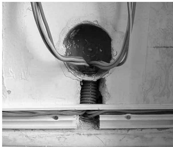
**Figure 176 :** *Exemple de distribution semi encastrée*
