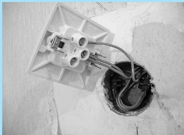
Mise en place des connexions dans le boîtier
