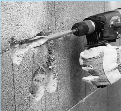
**Figure 227 : Tranchée au perforateur**
