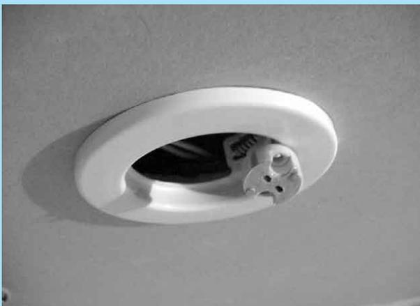
11 - Placez l'ampoule dans la douille.
