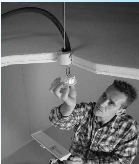
Raccordement d'une boîte DCL en faux plafond
