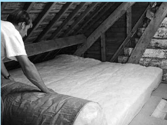
*Isolation avec pose de laine sur plancher*
