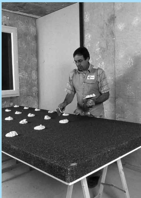
**1** - Posez la plaque sur des tréteaux pour appliquer les plots de mortier adhésif.
