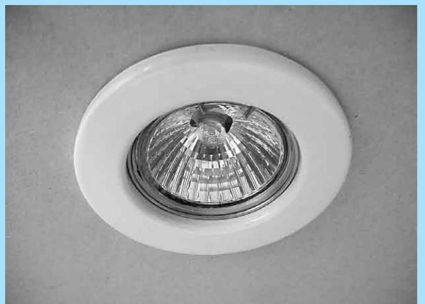
12 - Maintenez l'ampoule avec le circlip fourni.
