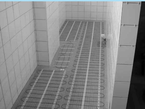
5 - Le câble est réparti sur la surface à chauffer.
