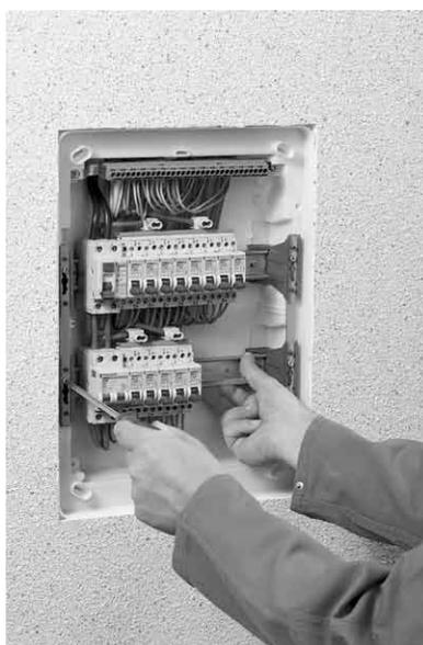
Les appareillages s'installent sur les rails prévus à cet effet. Les fileries seront masquées par le plastron.
