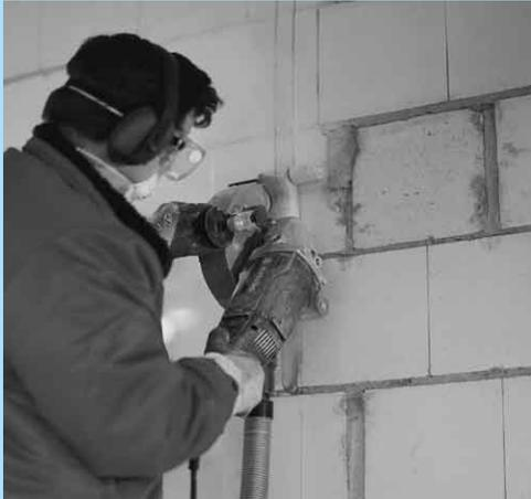
**Figure 226 : Tranchée à la rainureuse**
