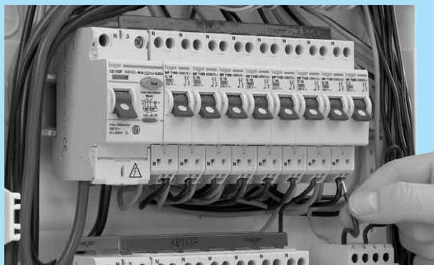
Sur certains modules la connexion des conducteurs se fait par simple clipsage.
