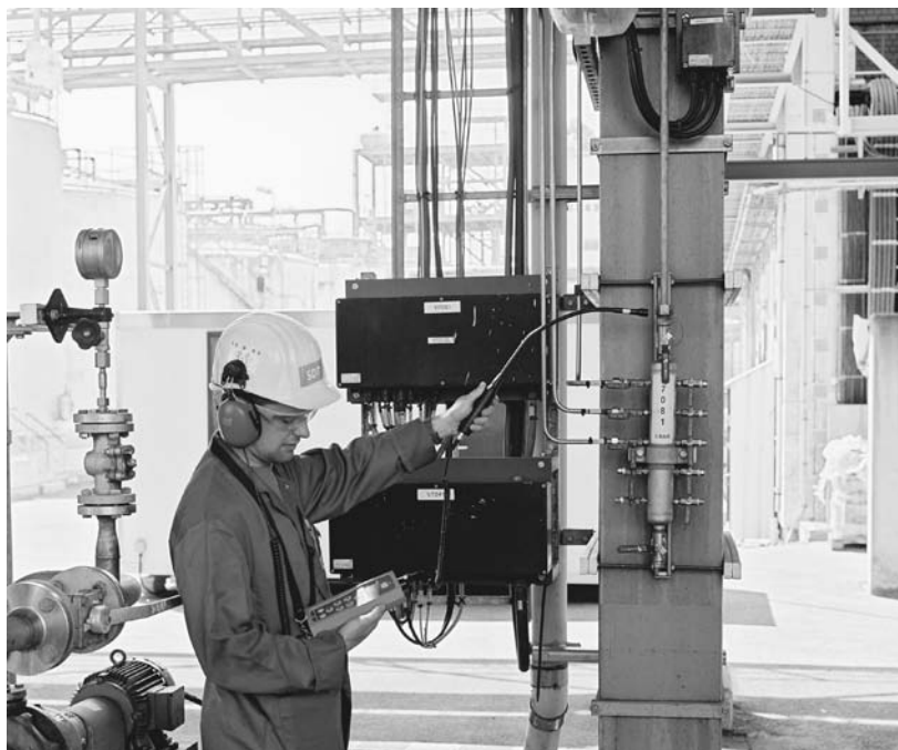
Figure 4 : Contrôle d'étanchéité des réseaux d'air comprimé
