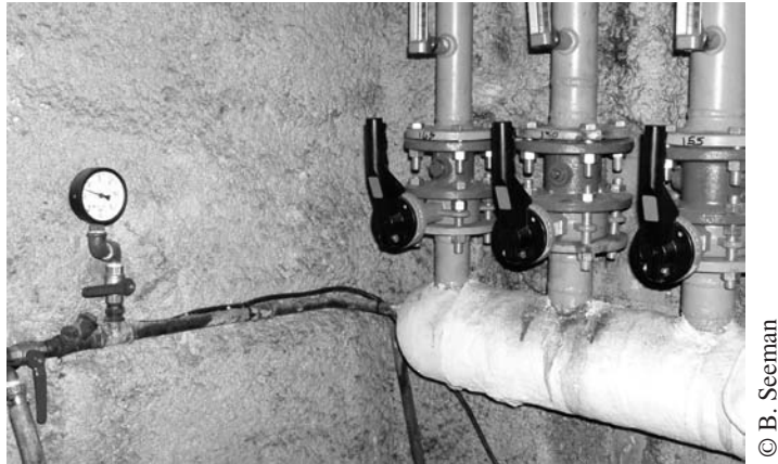
Figures 4 : Contrôle de l'étanchéité d'un réseau rénové dans un bâtiment
