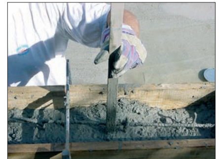
Fig. 4.25 Pénétration du béton avec débullage
