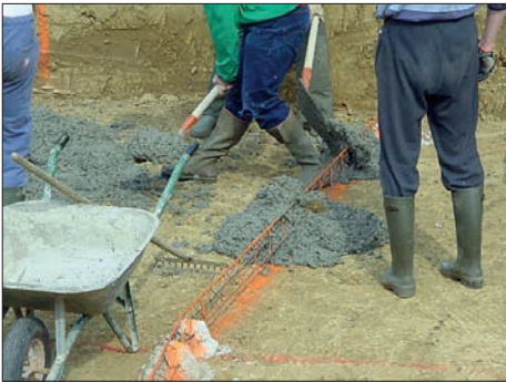
Figure 4.14 Chaînage triangulaire comme guide d'appui pour tirer le radier
