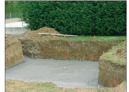
Fig. 4.20 Le radier est coulé et tiré de niveau en 2 heures.
