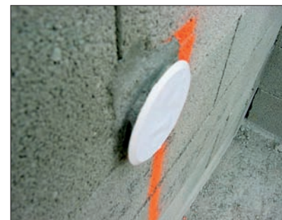
Fig. 4.37 Une des trois buses de refoulement
