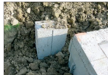
Fig. 4.41 Pilier pour supporter la dalle des plages sans reprise au chaînage de l'arase
