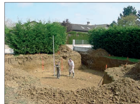
Fig. 4.5 Après le terrassement, il convient de régler le niveau du fond du terrassement et de le mettre à la cote de profondeur
