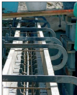
Fig. 4.45 Une personne remplit les stepoc pendant que l'autre les finit.
