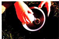
Installation d'un projecteur enterré dans le sol.
