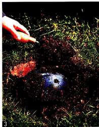
Installation d'un projecteur enterré dans le sol.
