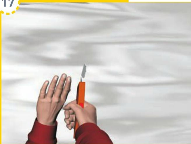
Avec un cutter, incisez l'isolant afin de dégager la suspente.
