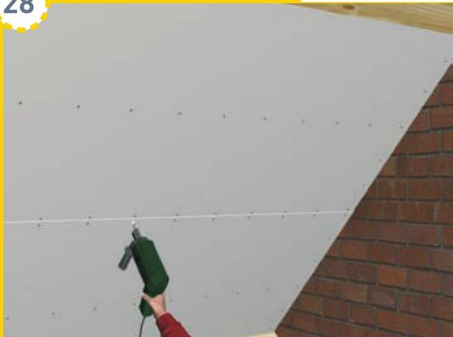
Vissez les plaques de plâtre et réalisez les joints. Pour plus de détails, reportez-vous à l'ouvrage *Plafonds, cloisons et carrelages* paru dans cette même collection.
