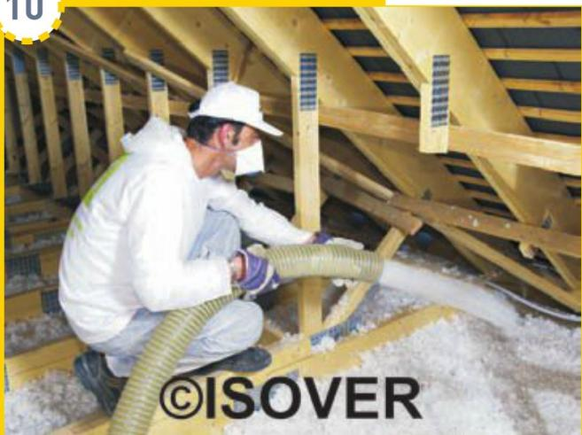
Soufflez la laine en la déposant régulièrement entre les solives. Alignez le niveau supérieur des flocons sur les repères préalablement mis en place.
