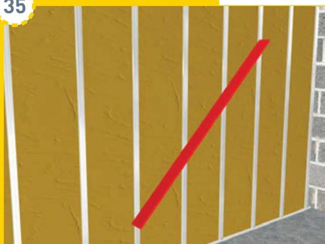
À l'aide d'une règle, contrôlez la planéité de la structure formée par les fourrures. Elle doit être parfaite, car les plaques de plâtre de parement épouseront son profil. La planéité du futur mur dépend donc entièrement de la planéité de cette structure.
