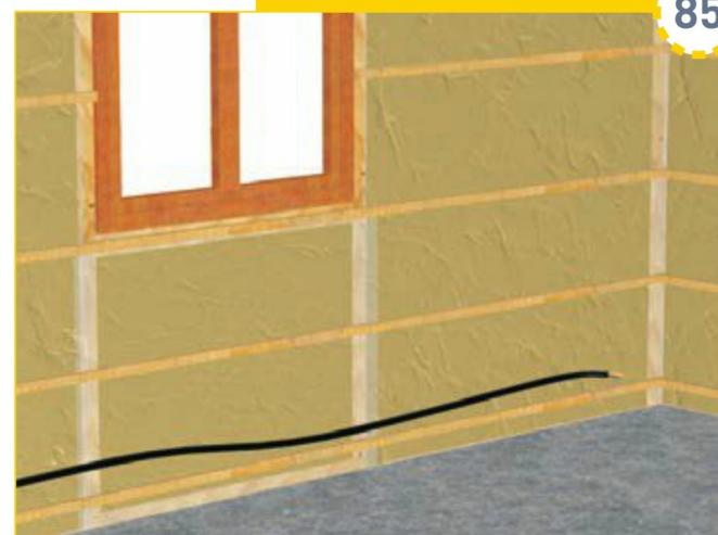
Vissez les plaques de parement sur les tasseaux. Pour les détails de pose des plaques de parement, reportez-vous si besoin à l'ouvrage *Plafonds, cloisons et carrelages* paru dans cette même collection.
