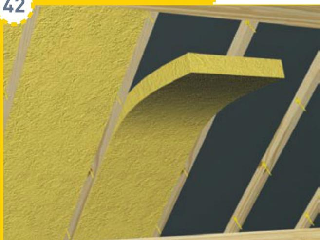
Mettez en place l'isolant, en tenant compte le cas échéant de la réserve nécessaire pour la lame d'air.
