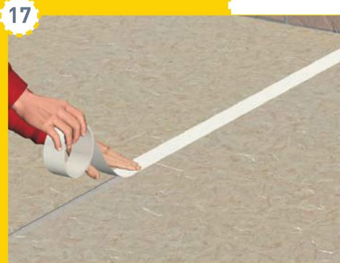
Afin que l'étanchéité à l'air entre les lés soit parfaite, il est indispensable de réaliser un joint. Utilisez pour cela le ruban adhésif recommandé par le fabricant.
