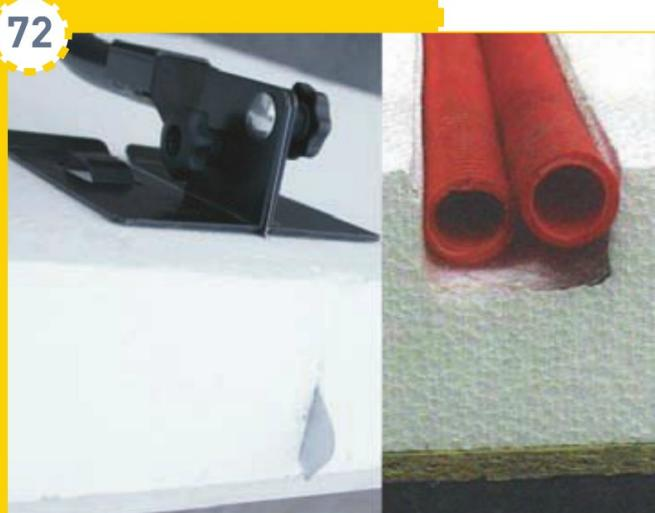
L'outil de découpe spécial isolant peut également être très utile pour encastrez des gaines électriques dans un isolant.
