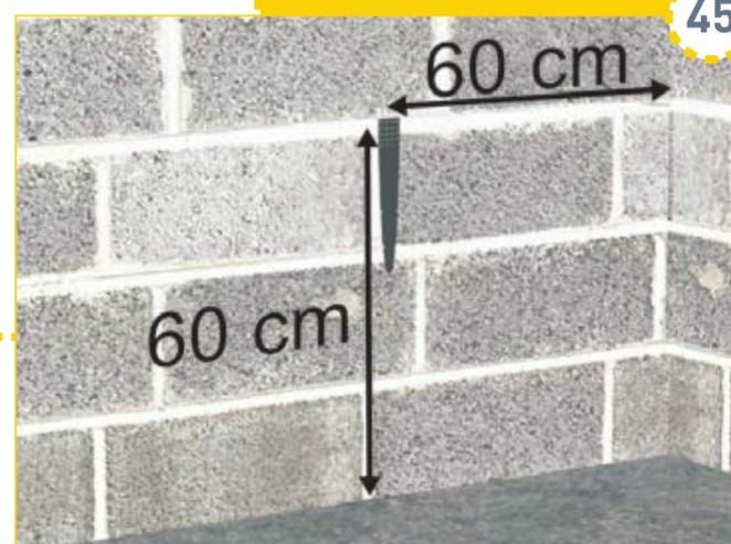
Si vous utilisez de l'isolant en rouleau, prévoyez en moyenne 2 accroches pour 3 m<sup>2</sup> d'isolant.
