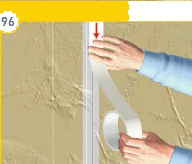
Avec du ruban adhésif, réaliser des joints étanches à la jonction de deux membranes.
