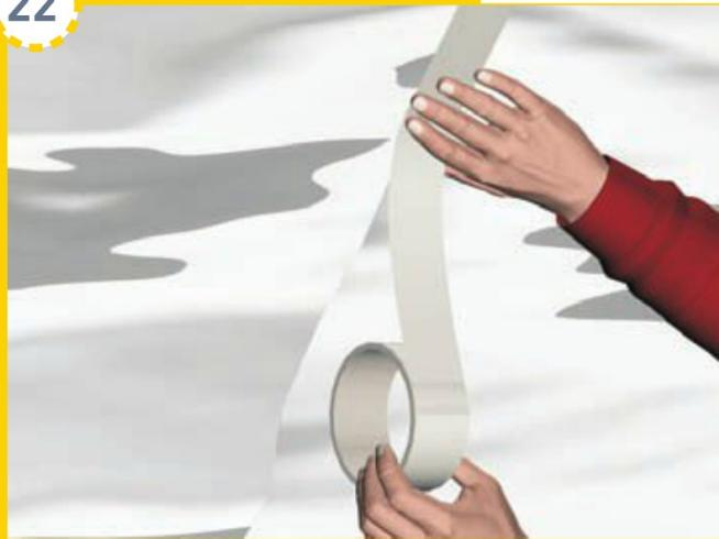
Lorsque l'isolant est posé, recouvrez chaque jonction avec du ruban adhésif spécifique (voir les recommandations du fabricant). Cet adhésif fait office de joint étanche à l'air.
