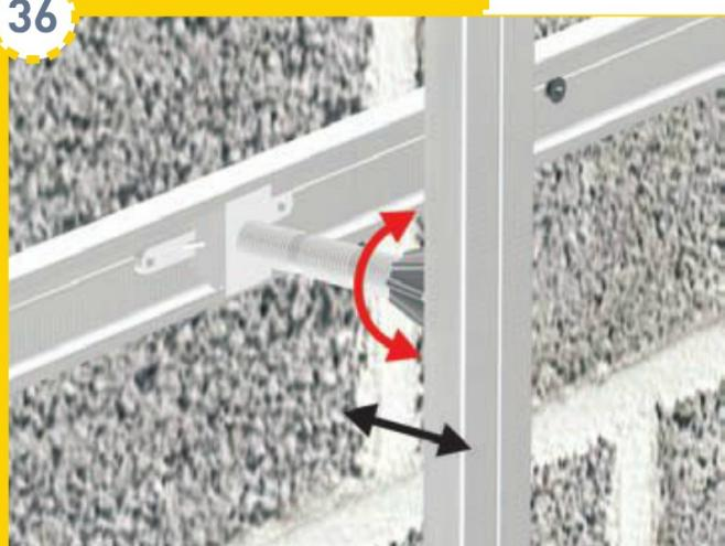
Le modèle de fixation intermédiaire que nous avons choisi (voir image ci-contre) offre un avantage non négligeable : il est réglable. Si besoin, corrigez la planéité de la structure en vissant ou en dévissant la tête des appuis.
