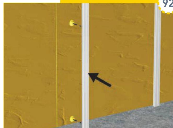
Passez les gaines électriques entre la seconde couche d'isolant et les fourrures verticales.
