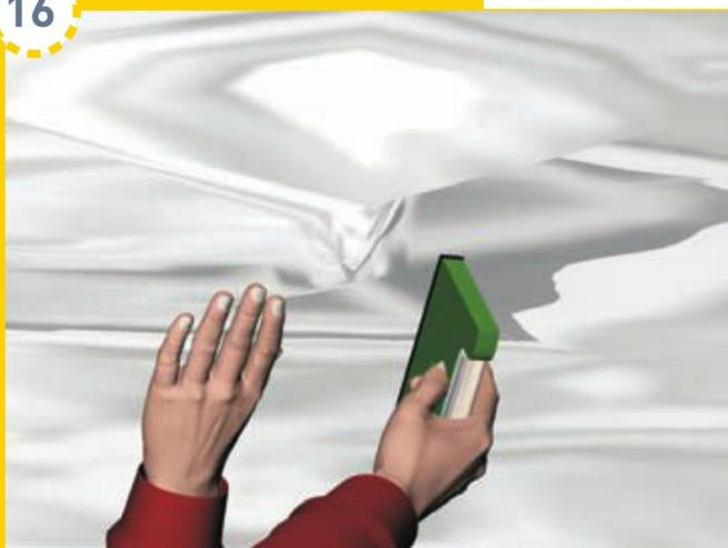
Afin de repérer précisément l'emplacement des suspentes, appuyez fortement sur l'isolant jusqu'à ce que le profil de la suspente se dessine.
