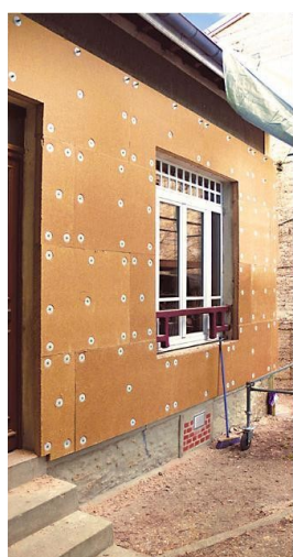
Figure 15 : ITE avec panneaux de fibre de bois calé-chevillé
