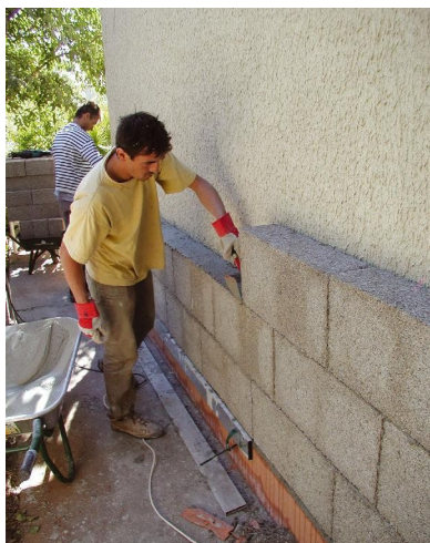
Figure 16 : Mise en oeuvre de bloc de chanvre pour une ITE
