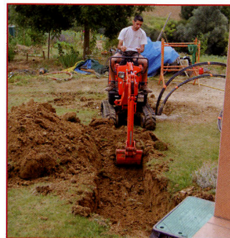
Raccordement des sondes vers un regard : travaux de mise en place...
