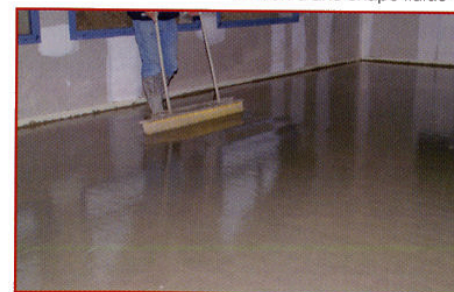
Finition d'une chape fluide ▼
