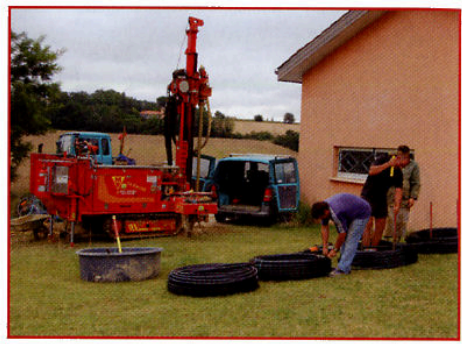
Préparation des sondes géothermiques
