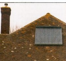
Capteurs solaires montés sur le pan de toiture orienté au sud.
