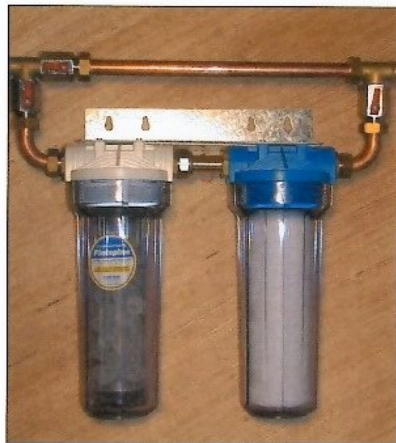
Filtere épurateur en série avec un filtre anti-tartre
