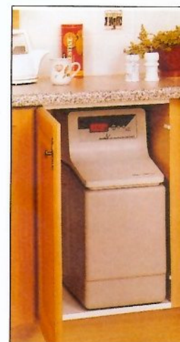
Adoucisseur d'eau Cet appareil, logé ici sous le plan de travail, doit être régénéré par rechargement en sel.
