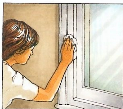
1 Nettoyez et dégraissez le cadre de la vitre.
