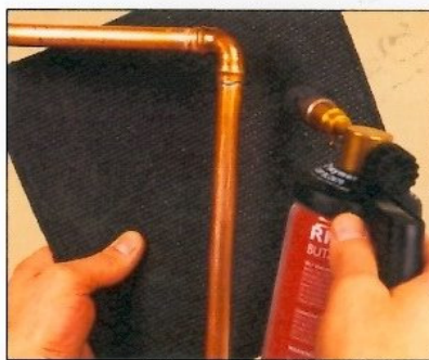
Chauffez l'emboîtement pour liquéfier la brasure.
