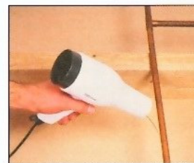
Dégeler une tuyauterie Balayez le tuyau avec le souffle d'un sèche-cheveux, en partant du robinet laissé ouvert.
