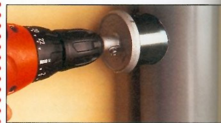
1 Percez le tube de chute avec une scie cloche.
