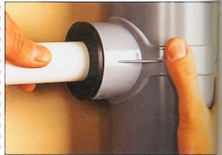
4 Enfoncez le tube d'évacuation dans le soufflet.
