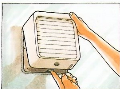
4 Coiffez la platine externe avec le baffle.
