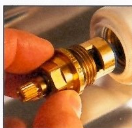
2 Sortez le mécanisme.
