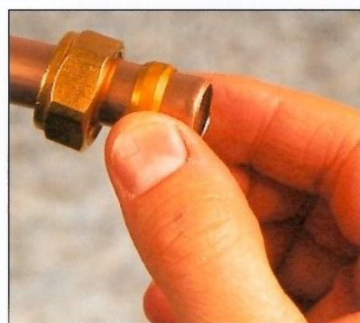
1 Glissez l'olive juste après la bague écrou.
