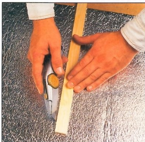
1 Entaillez des fentes au niveau des supports muraux.
