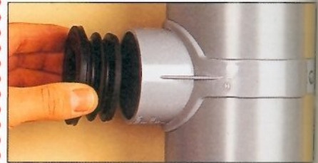
3 Insérez le soufflet d'étanchéité en caoutchouc.
