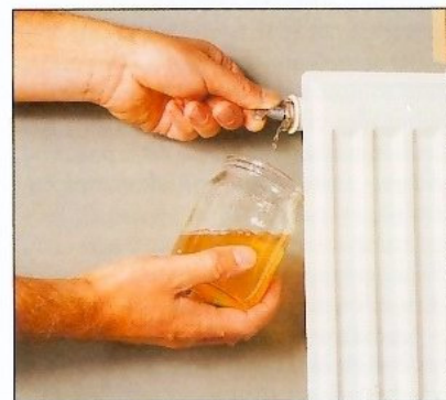
Purgez l'air présent dans un radiateur.
