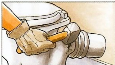
1 Cassez la sortie de la cuvette au marteau.
