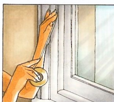
2 Encadrez avec une bande d'adhésif double face.
