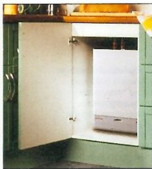
Implantation d'une chaudière à gaz Un appareil moderne peut se monter à l'intérieur d'un meuble de cuisine.
