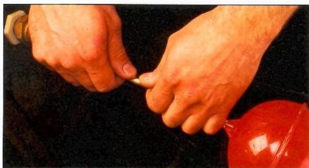
1 Courbez ou redressez le bras du flotteur.
