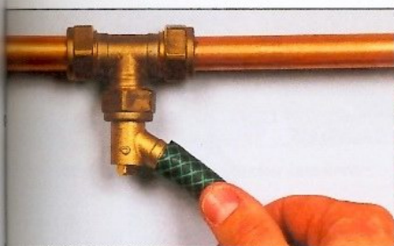
Capotez un tuyau d'arrosage sur le drain de vidange.
