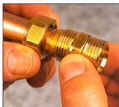
2 Insérez l'extrémité du tube au fond de l'union.
