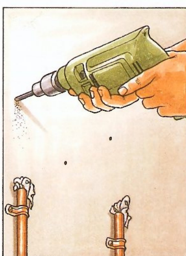
4 Percez sur les marques pour insérer des chevilles.
