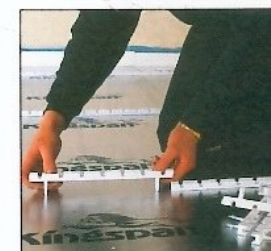
1 Piquez les barrettes de clips dans l'isolant.
