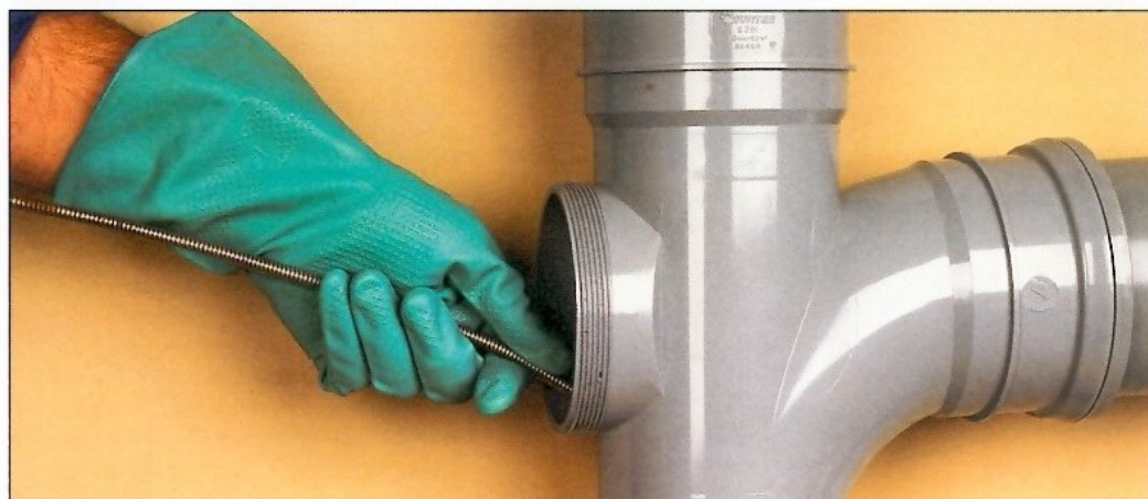
Louez un furet pour nettoyer une conduite enterrée.
