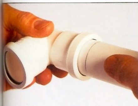
2 Retirez le tube d'environ 1 cm.
