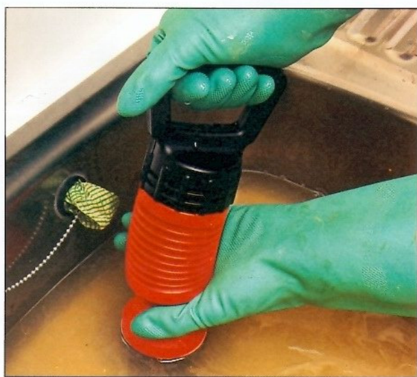
Forcez le bouchon en pressant la ventouse.
