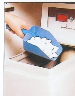
Adoucisseur d'eau Cet appareil, logé ici sous le plan de travail, doit être régénéré par rechargement en sel.
