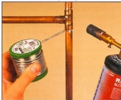
Faites fluer la brasure sous la lèvre du raccord.
