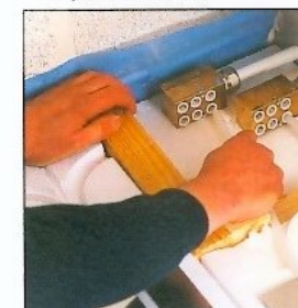
2 Raccordez les tubes dans les boîtiers.
