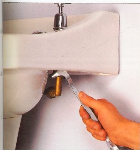
Débloquent le raccord sous la vasque La clé coudée permet d'accéder plus aisément à la bague écrou du raccord de la tuyauterie.
