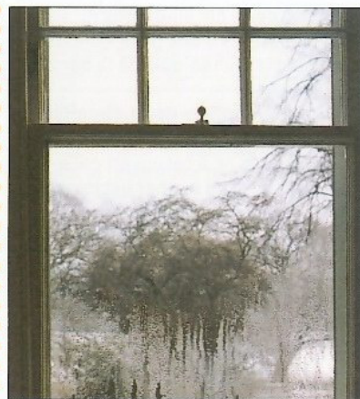
La condensation apparaît d'abord sur les vitres.
