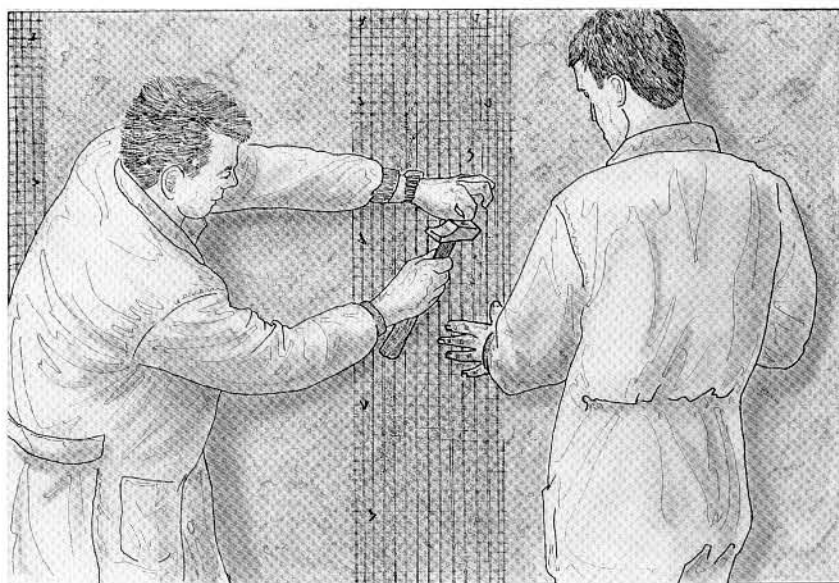
6. Fixation du grillage métallique.
