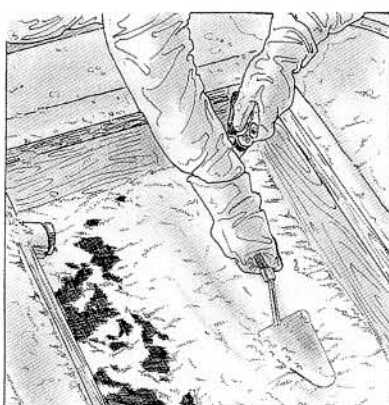
12. Avec la truelle catalane, on presse le mélange contre la grille du tamis.
