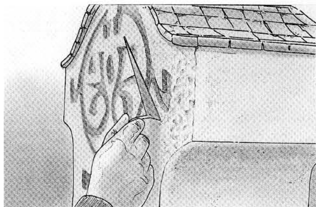
7. Smillage avec la pointe de la lisseuse.
