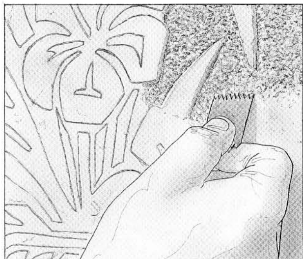
2. Évidement à la lame de scie jusqu'à ce qu'émerge l'enduit de base.
