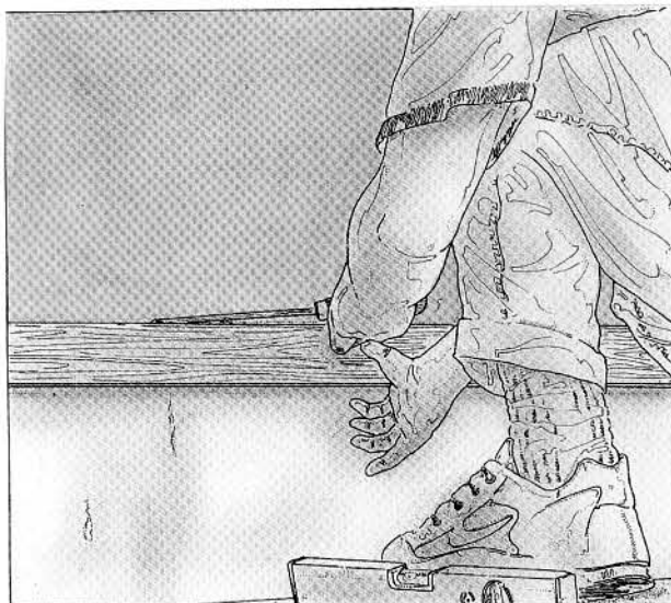
38. Tracé du joint avec un poinçon.
