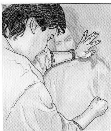
48. Décalque du dessin sur l'enduit.
