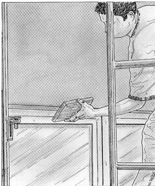
29. Finition des arêtes à la taloche.
