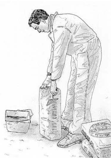
2. Ouverture des sacs d'hydrate de chaux.
