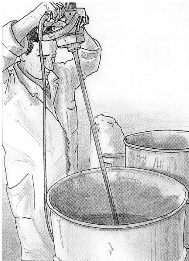
Malaxage de la chaux teinte et du granulat avec un malaxeur électrique.
