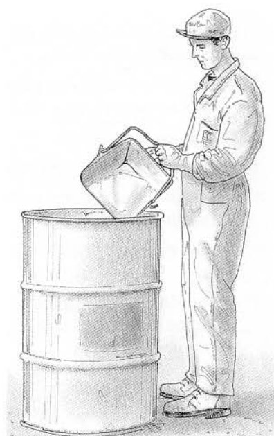
2. La chaux en pâte est versée dans un bidon.
