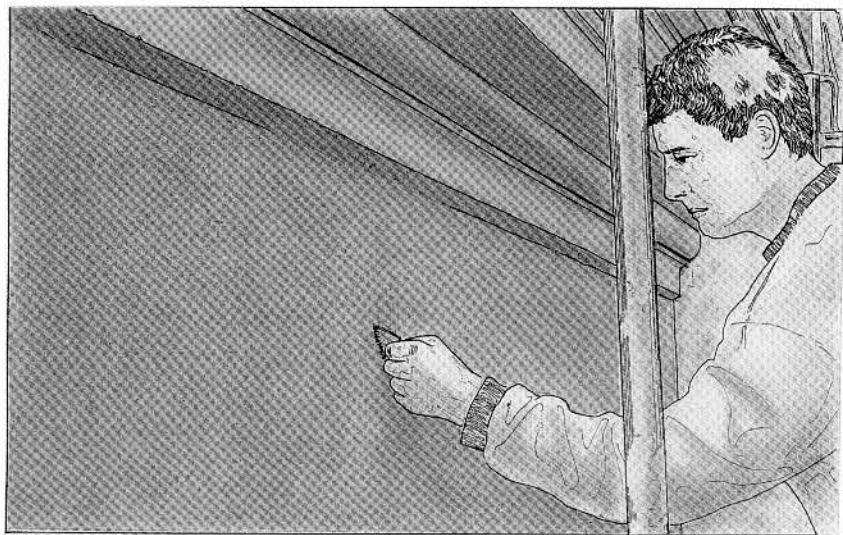
17. Premier grattage vertical (vue détaillée) ; le second grattage sera horizontal.
