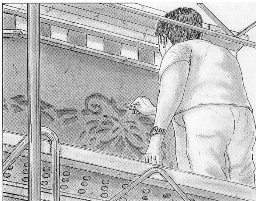
8. Nettoyage des fonds après le grattage de la surface.
