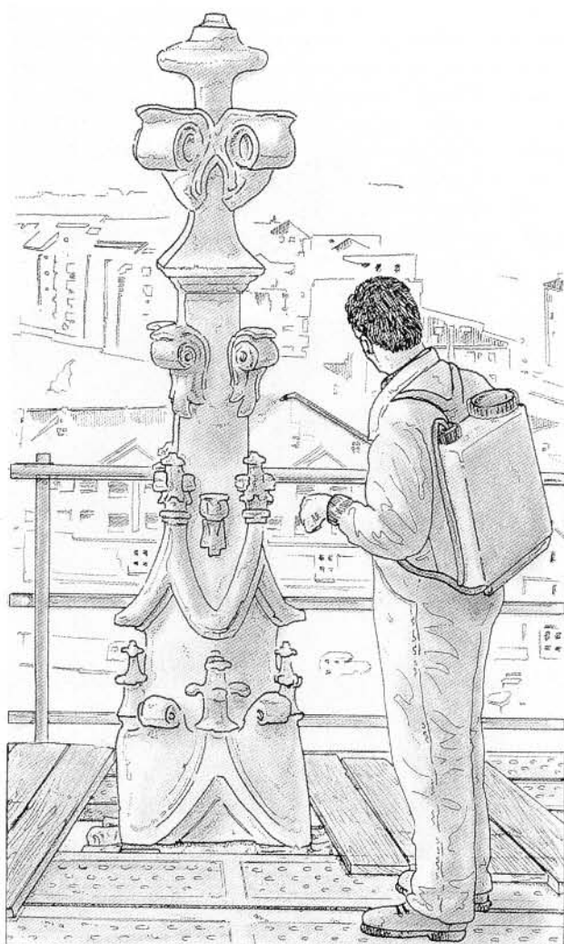
Traitement, à l'eau de chaux, d'un pinacle de la cathédrale de León.
