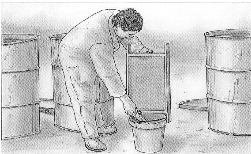
15. Mouillage du tamis avec de l'eau pour que la chaux teinte ne s'incruste pas.
