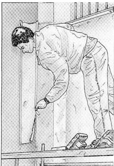
1. Protection, avec un papier kraft, du mur stuqué les jours précédents.
