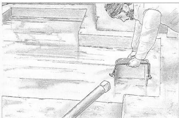
Extraction de l'eau de chaux qui se trouve à la surface de la fosse de repos.
