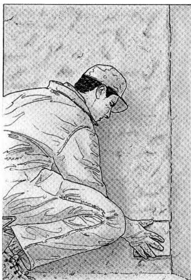
9 et 10. Pose des repères avec des carreaux de céramique.
