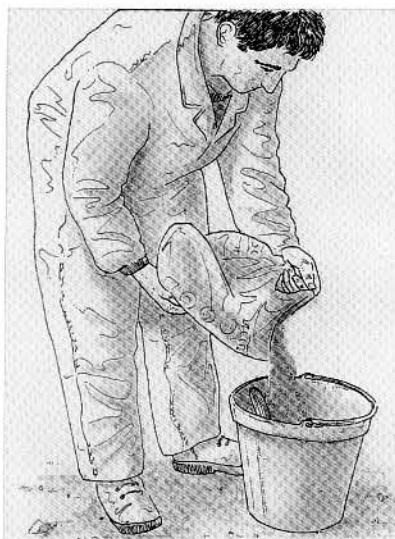
4. Versement des pigments dans un demi-seau d'eau.
