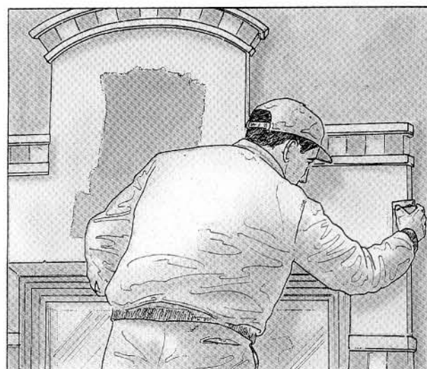
8. Talochage des arêtes.
