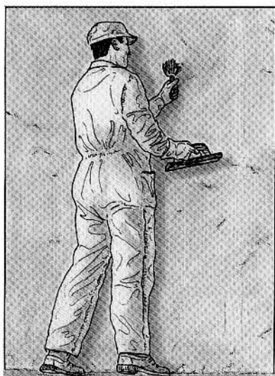
21. Humidification du mur.
