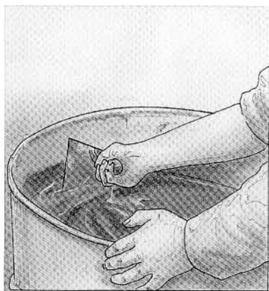
12 et 13. Nettoyage du bord intérieur du bidon avec une truelle et un pinceau trempé dans de l'eau.
