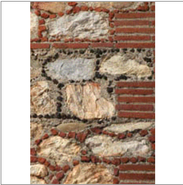
41 - Joints cloutés de tesselles noires et rouges. Grosses pierres entre lits de cayroux
