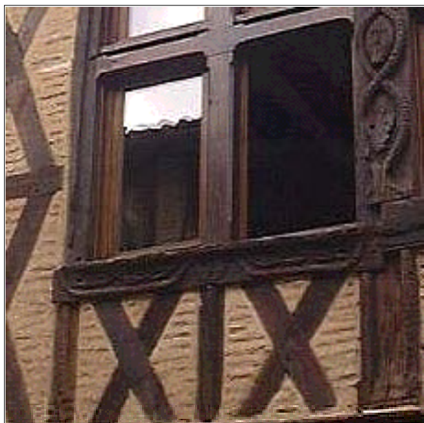
20 - Les bois sculptés restent évidemment apparents mais les bois fonctionnels en croix de Saint André peuvent selon leur état recevoir un enduit protecteur ou rester apparents, comme ici.
