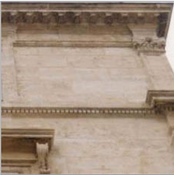
29 - Sur les façade en pierres de taille les joints sont discrets.
