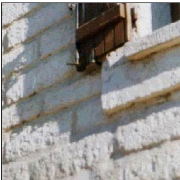
32 - Moins protecteurs que des joints pleins, les joints en creux soulignent les irrégularités de l'appareillage au lieu de les gommer.
