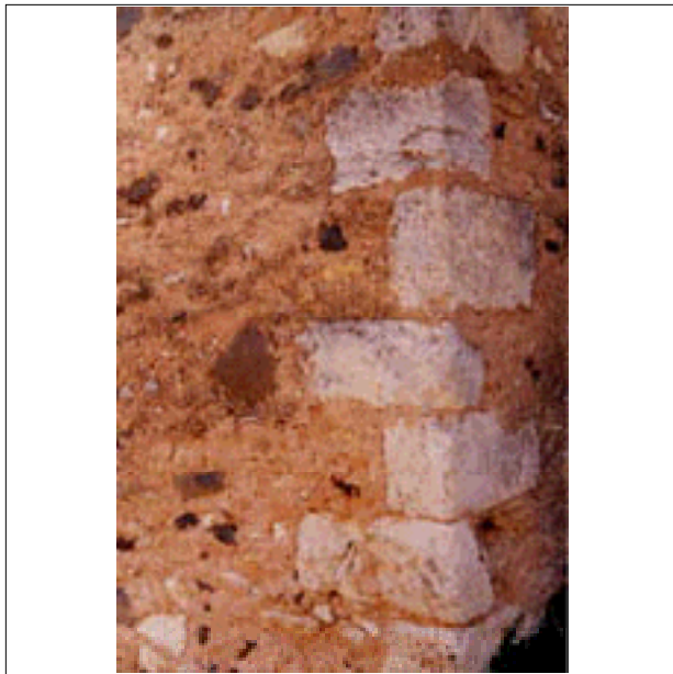
37- La chaîne d'angle harpée affleure le mortier des joints.
