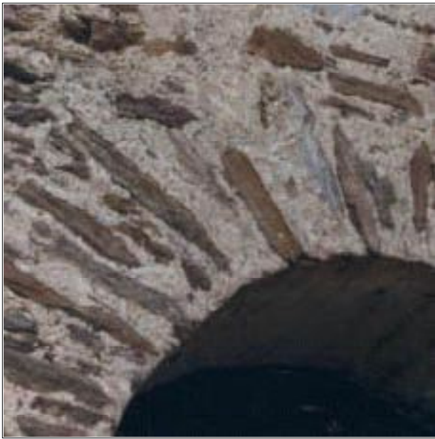
33 - Bon exemple de joints pleins adaptés à cet arc soigné de pierres plates sur du bâti rural.
