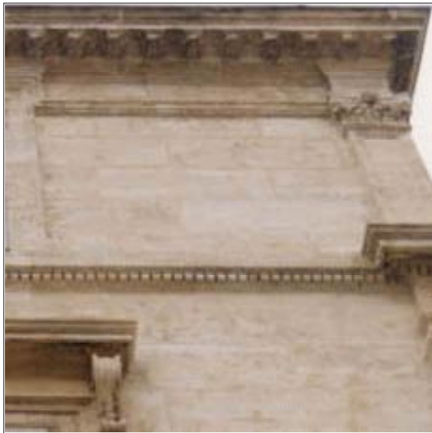
2 - Pierre de taille en calcaire tendre. Le ravalement ne devra pas épaufrer les joints.
