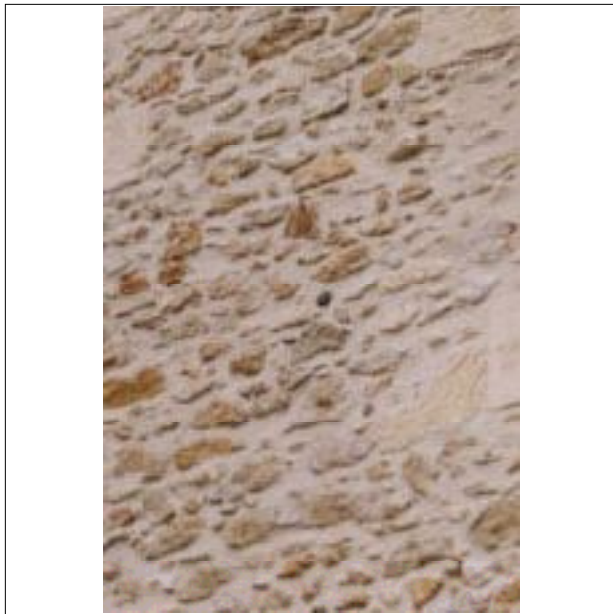
11 - Larges et irréguliers, les joints des pierres de tout-venant s'exposent à l'eau.
