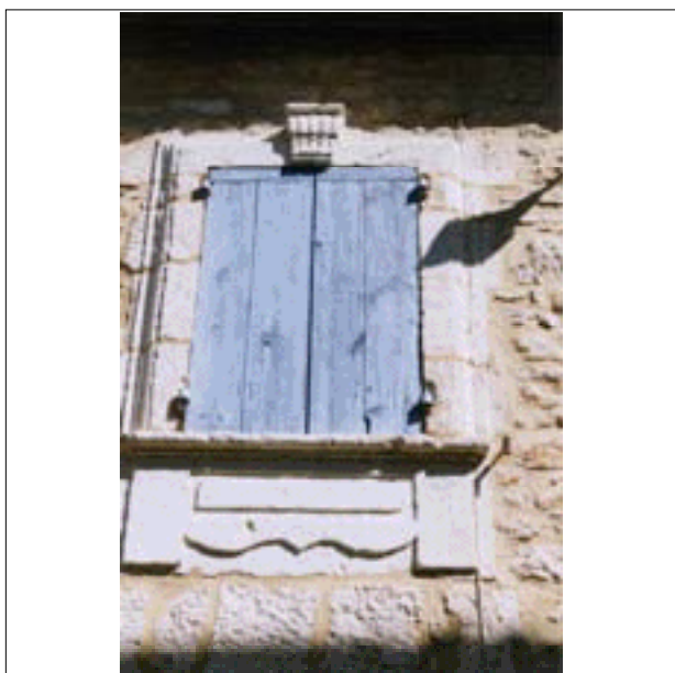
27 - Un enduit taloché devrait mettre en valeur les pierres moulurées.
