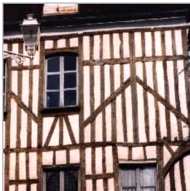
21 - Les remplissages moins soignés sont enduits pour limiter l'apport d'eau par les joints.
