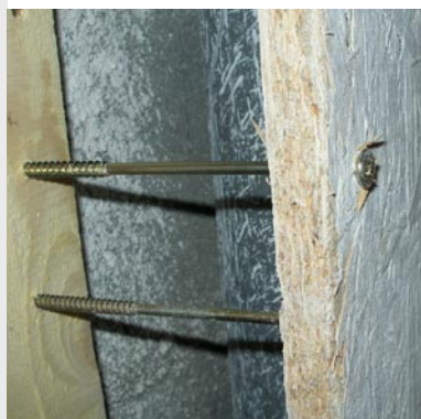
La vis de butée détermine l'épaisseur du doublage. La vis de serrage maintient le coffrage.
