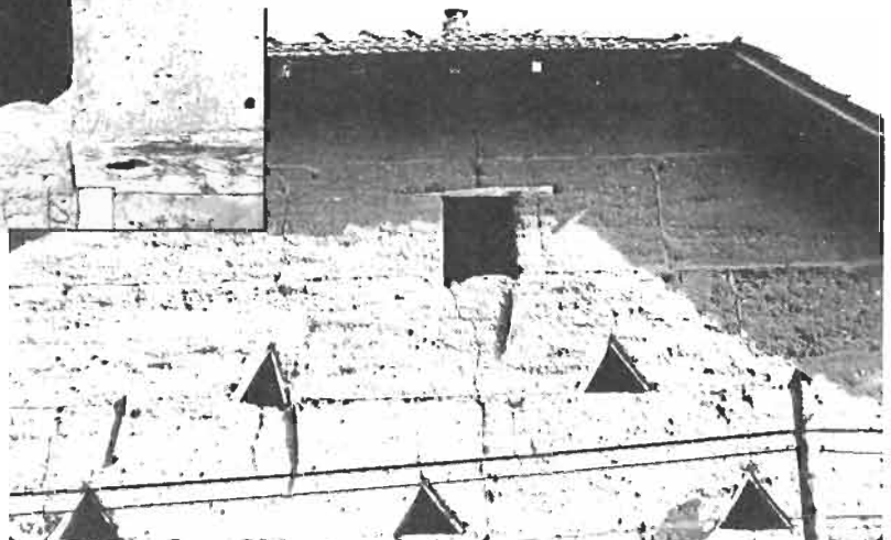
FIGURE 36 : L'OUVERTURE DES FENÊLES EST SOUVENT TAILLÉE DIRECTEMENT DANS LE MUR SANS LINTEAUX NI MONTANTS.
