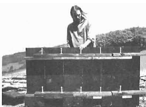
FIGURE 97 : BANCHE ARTICULEE PERMETTANT DES MURS COURBES AINSI QUE DES POTEAUX - POSITION RECTILIGNE (LE PIN, 1975)
