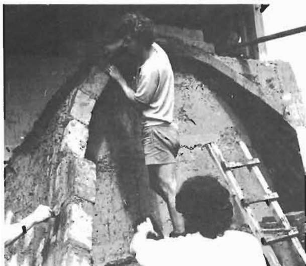
FIGURE 313 : LES BRIQUES DU SOMMET SONT LES PLUS DELICATES A POSER
