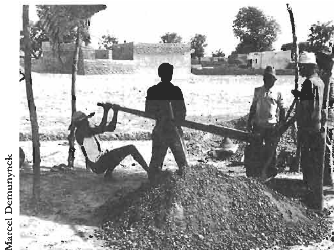
FIGURE 223 : FABRICATION DE BRIQUES AVEC UNE PRESSE TEK BLOC (HAUTE-VOLTA)
