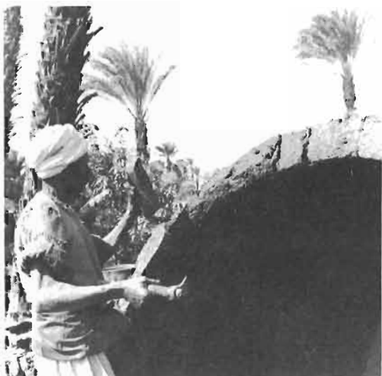
FIGURE 310 : LE MAÇON NUBIEN S'APPRETE A « COLLER » LA BRIQUE SUR LA COUCHE DE MORTIER. ON DISTINGUE SUR UNE FACE DE LA BRIQUE LES SILLONS, CREUSES AU MOULAGE, ET QUI AMELIORENT L'ADHERENCE DE LA BRIQUE AU MORTIER
