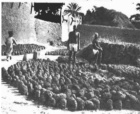
FIGURE 148 : BRIQUES EN FORME DE POIRE (NIGÉRIA)
