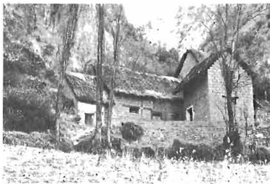
FIGURE 161 : LE TOIT EST EN CHAUME D'ICHU SERVANT ÉGALEMENT À FABRIQUER L'ADOBE (PÉROU)
