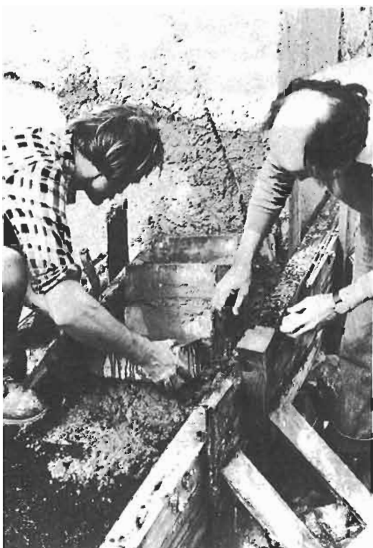
FIGURE 311 : POSE DES PREMIERES BRIQUES SUR LE SOUBASSEMENT
