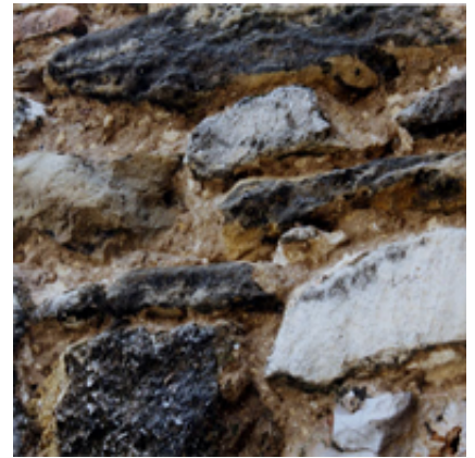
6 - On mouille le mur
