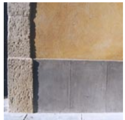
24 - Soubassement gris à la chaux hydraulique.
