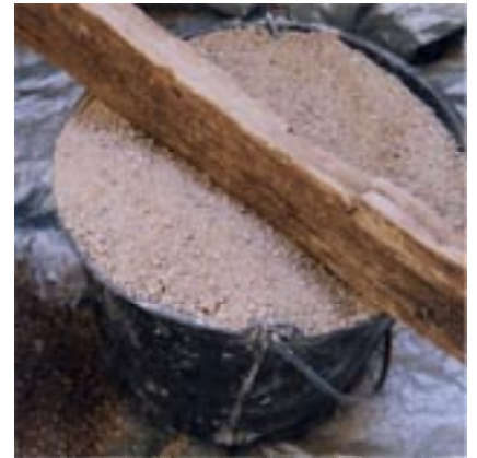
20 - Mesure en seaux arrasés
