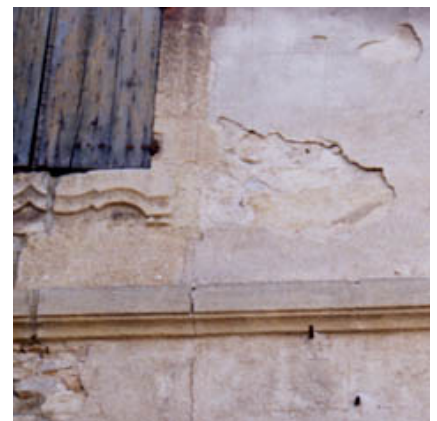
12 - Enduit à la chaux altéré
