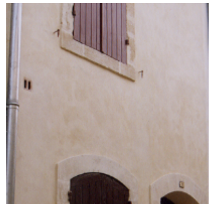
26 - Enduit teinté par le sable
