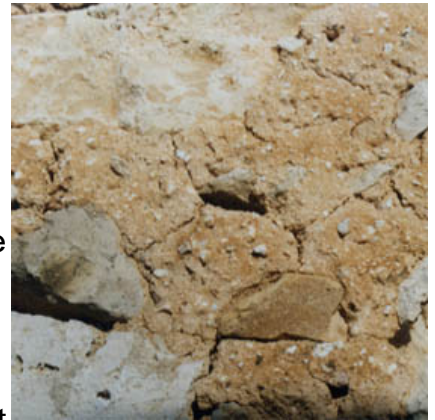
5 - Joints sensibles à l'humidité
