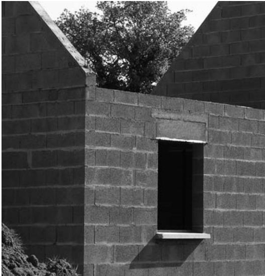
Fig. 2 : montage de la maçonnerie (joints verticaux alternés)
