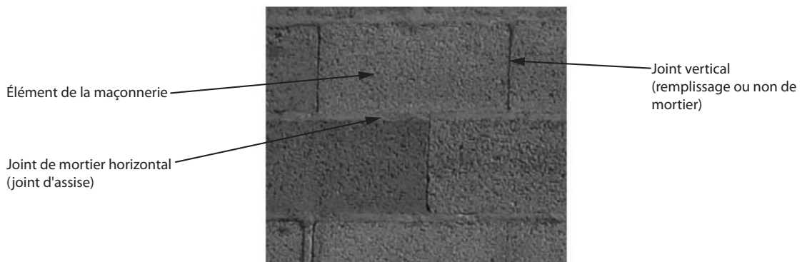
Fig.1 : les constituants principaux d'une maçonnerie
