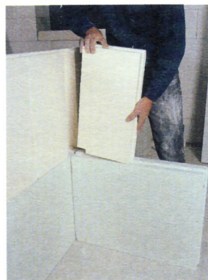
23. et 24. Une rangée sur deux, le carreau traverse à mi-épaisseur la cloison perpendiculaire. Encollez largement toutes les parties en contact.
