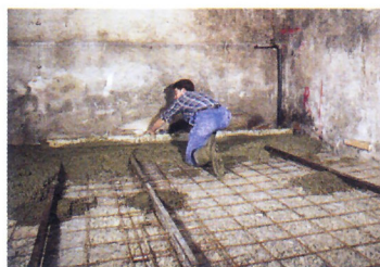
2. Pour une dalle de grande surface, répandez le béton sur une largeur d'environ 1 m. « Tirez-le » avec la règle de maçon en sciant (la règle prenant appui sur les guides). Procédez ainsi par passes successives.
