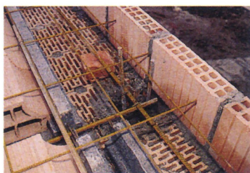
Ferrailles des piliers antisismiques.
