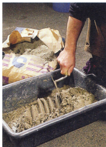
Mélangez correctement à sec, sable et liant.
