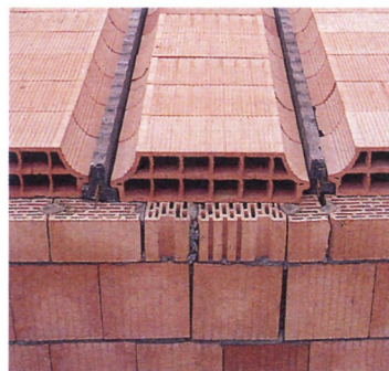
Les poutrelles prennent appui sur les murs à chaque extrémité.
