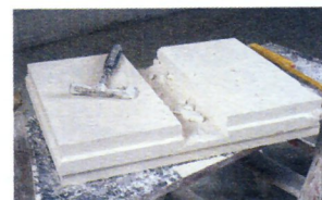
Liaison d'une cloison perpendiculaire assemblée à mi-carreau (voir aussi page 30)
