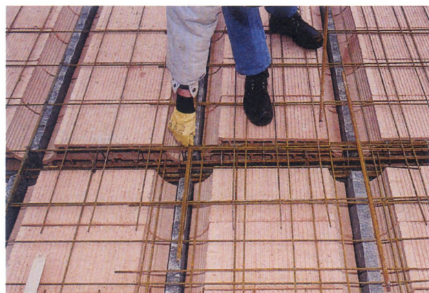
Pour une dalle, le ferrailage est constitué par des fers croisés à 90°, assemblés par des ligatures.
