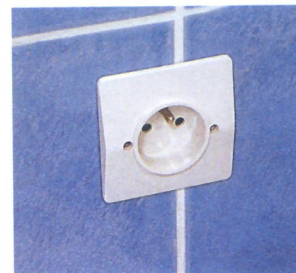
La prise en place, son socle masque les éventuelles imprécisions de découpes dues à la lame (escaliers).
