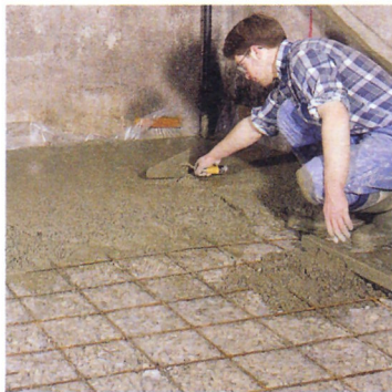
→ 4. Comblez les vides avec du béton.
