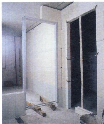
16. Le départ de cloison réalisé, positionnez l'huissier sur des cales correspondant à la future hauteur de chape (moins 2 cm environ), en vérifiant sa verticalité et son horizontalité.
