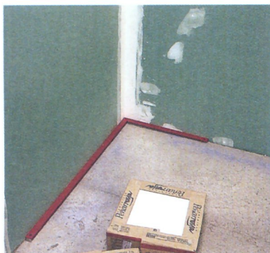
Vérifiez l'équerrage des murs.
