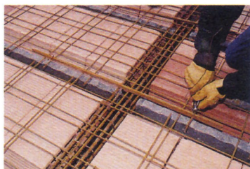
Les ligatures sont très importantes puisqu'elles vont maintenir les ferrailles lors du coulage.
