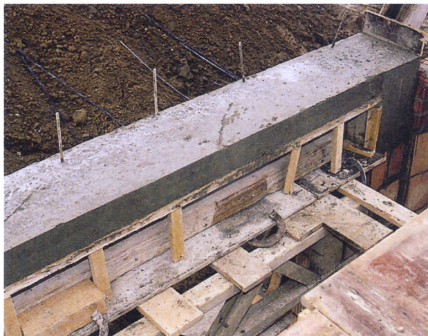
Laissez au moins 4 à 6 jours encore les étais inférieurs de soutien du linteau (en fonction de la température et de l'hygrométrie extérieures).
