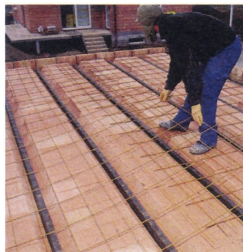
Pose d'un treillis soudé sur toute la surface.
