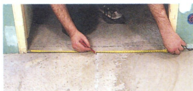
Mesurez le centre du seuil de porte, il sera le point de départ d'un des axes de pose.
