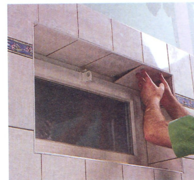
Encollez, positionnez les carreaux.
