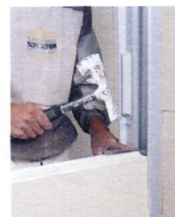
20. et 21. Disposez à chaque rangée de carreaux une patte de scellement.
