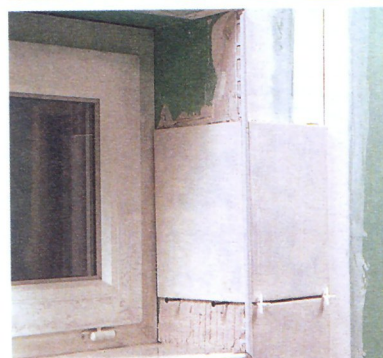
Coupez et posez les carreaux dans l'ébrasement.
