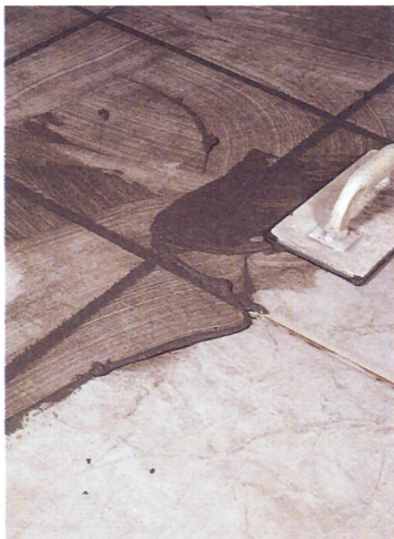
Dépose de la barbotine en jointoiement de carrelage.
