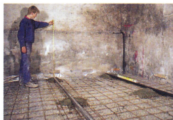
1. Les guides sont posés au niveau 0, de manière parfaitement horizontale. L'horizontalité de ces guides sera obtenue à l'aide d'un niveau à bulle. Pour faciliter leur réglage en hauteur, ils seront disposés sur des plots en béton.
