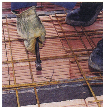
Pose d'un treillis soudé sur toute la surface.
