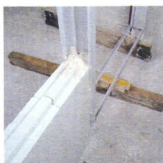
15. Dressez et encollez successivement les éléments de carreaux constituant le départ de cloison perpendiculaire. Entaillez et dégagez les bords de rainures ainsi que le tenon pour permettre la pénétration de l'élément traversant.
