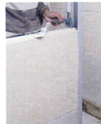
20. et 21. Disposez à chaque rangée de carreaux une patte de scellement.
