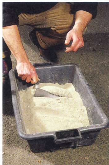
Mélangez correctement à sec, sable et liant.
