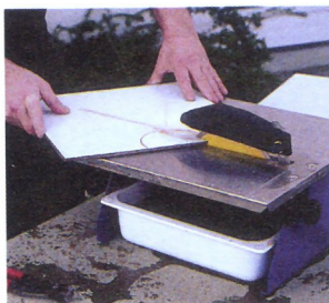
Débutez le sciage dans un angle en visant le milieu du demi-cercle. Avancez jusqu'au traçage de l'arc de cercle, reculez délicatement le carreau.
