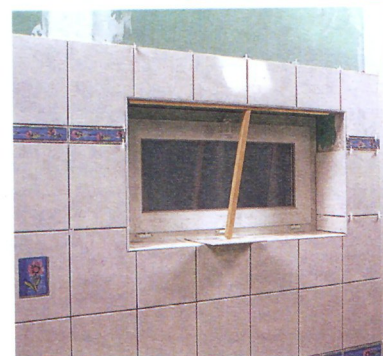
Collez la baguette d'angle haute, maintenez-la par un tasseau.
