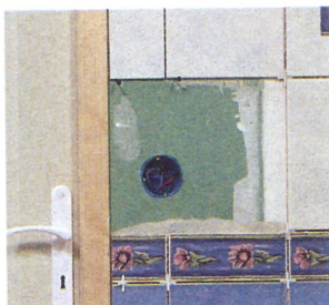
Découpe à réaliser : passage d'un interrupteur ou d'une prise de courant.
