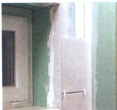
Posez les baguettes de finition latérales.
