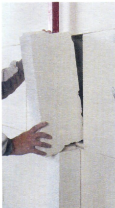
15. Dressez et encollez successivement les éléments de carreaux constituant le départ de cloison perpendiculaire. Entaillez et dégagez les bords de rainures ainsi que le tenon pour permettre la pénétration de l'élément traversant.
