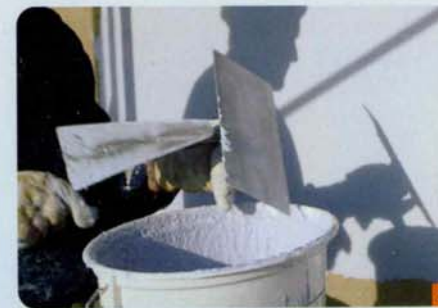
2 La dépose et le lissage d'un enduit décoratif de façade se font à la taloche en une couche de 4 à 5 mm d'épaisseur.
