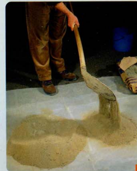
1 Pour un dosage relativement précis du sable et du liant, l'utilisation d'un seau est une bonne méthode.
