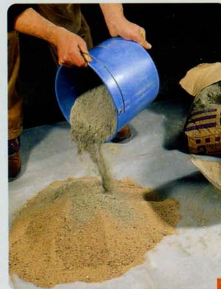
1 Pour un dosage relativement précis du sable et du liant, l'utilisation d'un seau est une bonne méthode.
