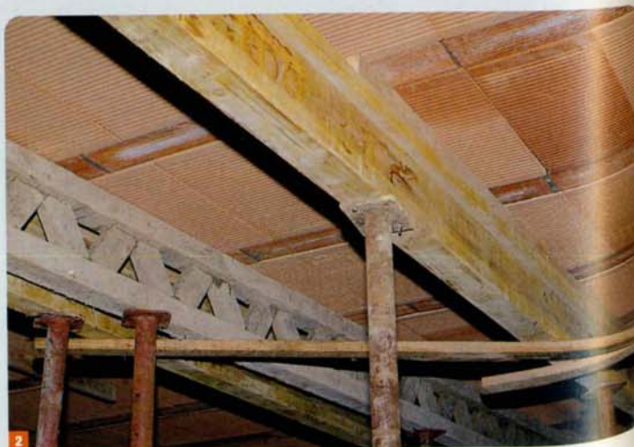
2 L'étagage sous poutrelles est indispensable, il doit être réalisé avec beaucoup de soin.
