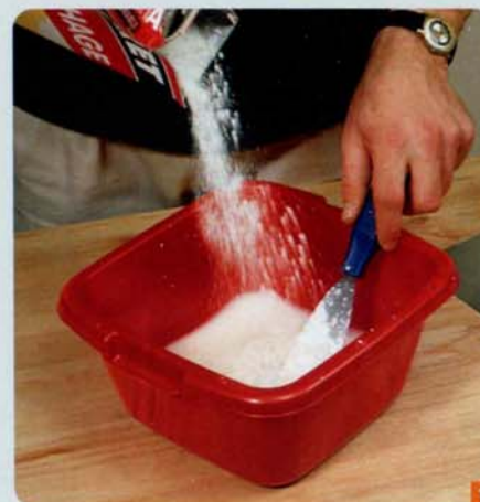
1 Saupoudrez l'enduit dans l'eau, tout en agitant avec la spatule. Toujours bien respecter le mode d'emploi et les proportions de dilution du fabricant.
