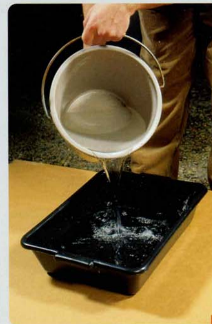
1 Versez dans une auge la quantité d'eau nécessaire.
