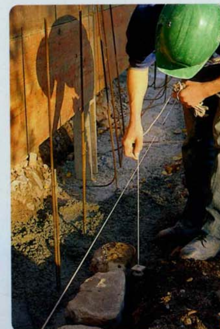
1 Exemple de fondation, notez l'important ferrailage.
