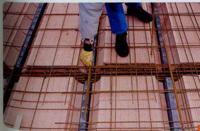
2 Pour une dalle, le ferrailage est constitué par des fers croisés à 90°, assemblés par des ligatures.
