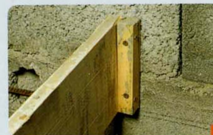
4 Pour le maintien du coffrage, vous utiliserez soit des clous acier, soit vous percerez, chevillerez et visserez à même le béton.
