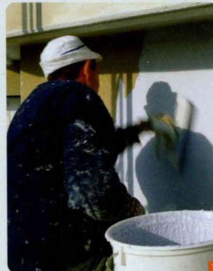
1 Talochage d'un mortier décoratif préparé en usine. Généralement conditionné en seau, il est teinté dans la masse. Un grand nombre de coloris et de nuances sont disponibles sur le marché.
