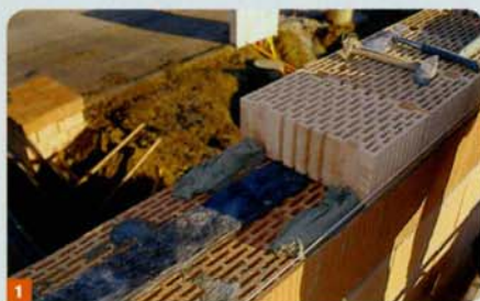
1 Disposez deux cordons de mortier de part et d'autre de la bande isolante.
