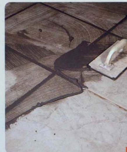
2 Dépose de la barbotine en jointoiement de carrelage.
