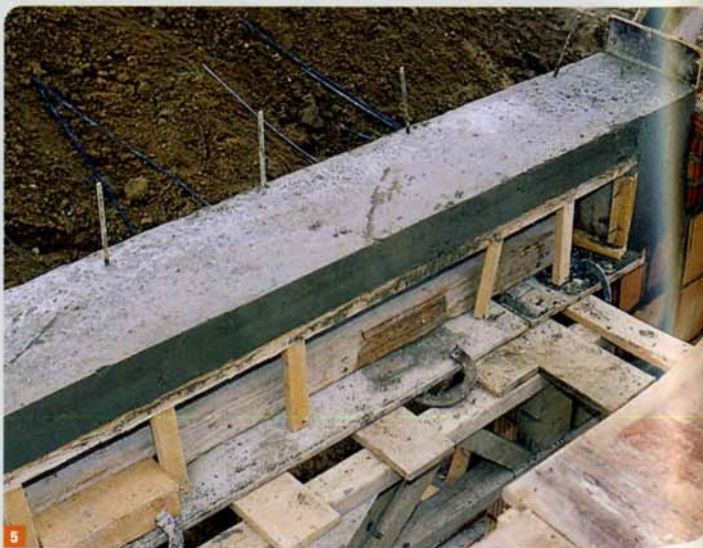
5 Laissez au moins 4 à 6 jours encore les étais inférieurs de soutien du linteau (en fonction de la température et de l'hygrométrie extérieures).
