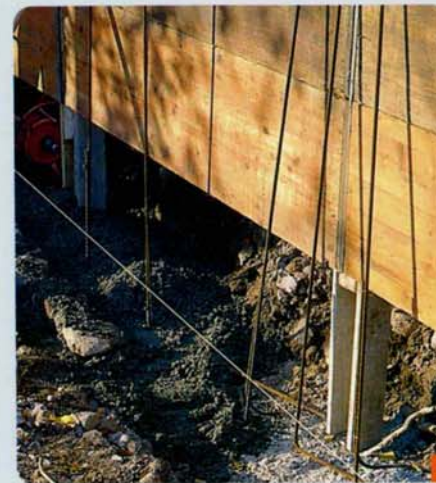
1 Exemple de fondation, notez l'important ferrailage.
