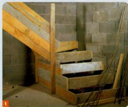
1 Vue d'ensemble d'un coffrage d'escalier.
