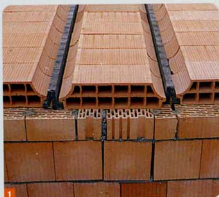
1 Les poutrelles prennent appui sur les murs à chaque extrémité.
