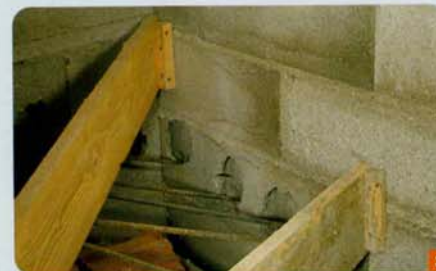
3 Le ferrailage doit être pris dans le mur.
