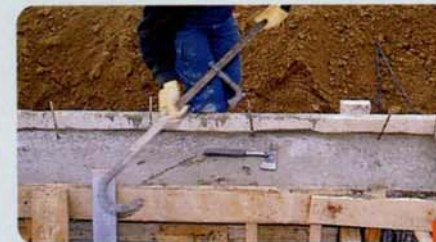
Exemple de décoffrage d'un linteau de porte de garage
