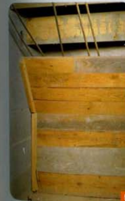
4 Pour le maintien du coffrage, vous utiliserez soit des clous acier, soit vous percerez, chevillerez et visserez à même le béton.
