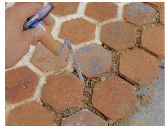
Donnez un mouvement de va-et-vient à votre fer à joints afin de cisailer le mortier et en chasser l'air, tout en répandant le mélange uniformément.
