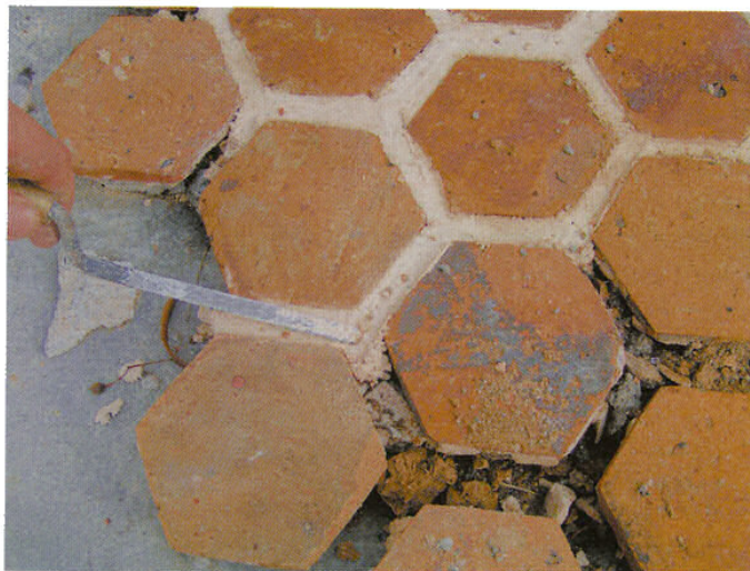
En appuyant plus fort avec le fer à joints, vous creusez le jointoiement et faites ressortir le dallage.
