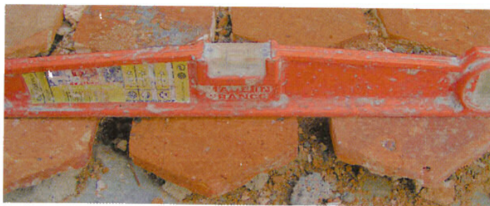
Posez la dalle sur un lit de mortier de 3 à 4 centimètres d'épaisseur puis assurez-vous que cette dernière est bien de niveau.
