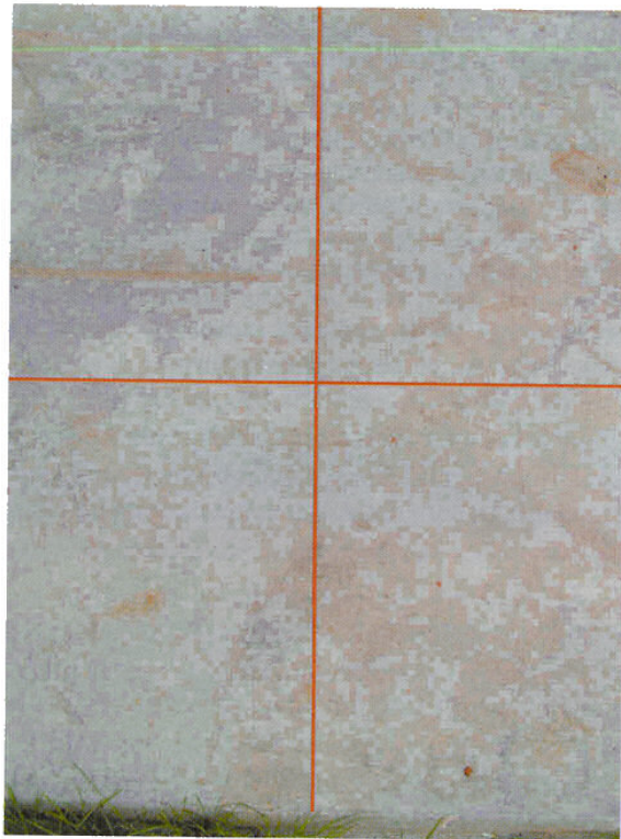
Tracez sur la surface à carreler deux axes qui vous serviront à positionner les premières dalles.
