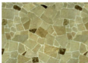
Mur en opus incertum (disposition aléatoire, sans assises réglées) avant la réfection des joints
