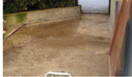
Décaissement de 12 cm pour la réserve de béton
