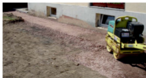
Compactage par couches de 20 cm environ
