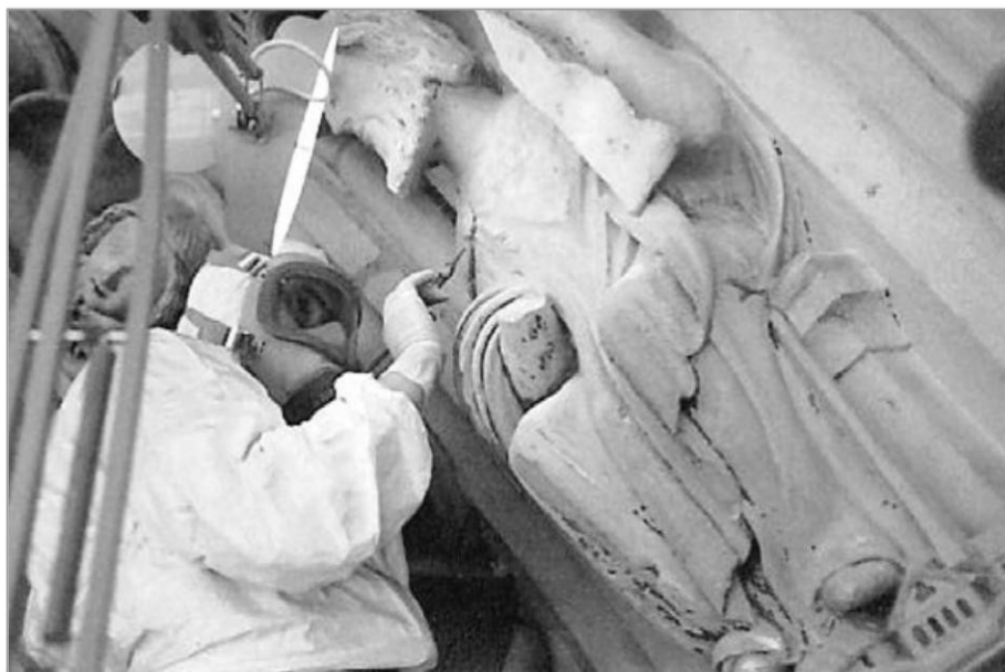
| Microsablage en cours sur les détails d'une sculpture.
