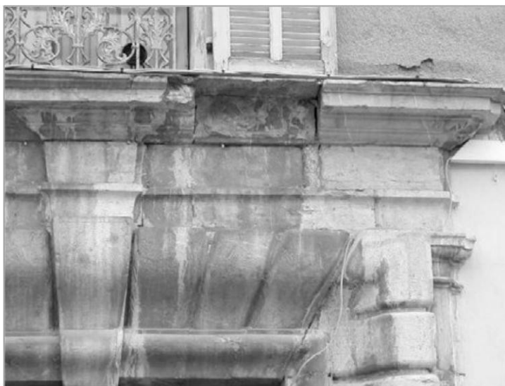
Exemple de salissures rouges.
