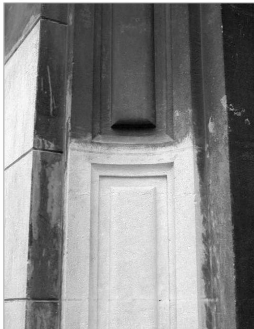
Traitement chimique sur encroûtements noirs.
