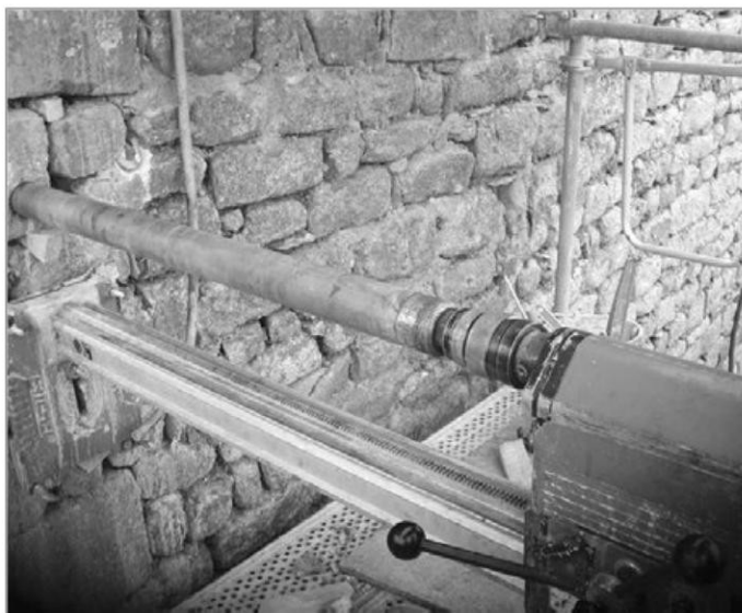
Forage au diamant pour mise en place de tirants.
