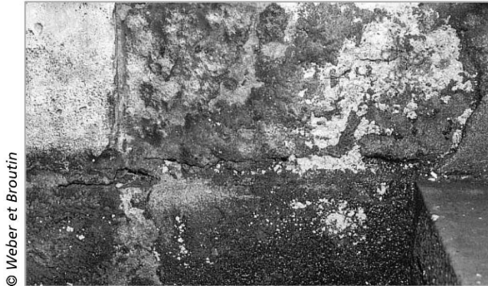
Exemple de salissures vertes.
