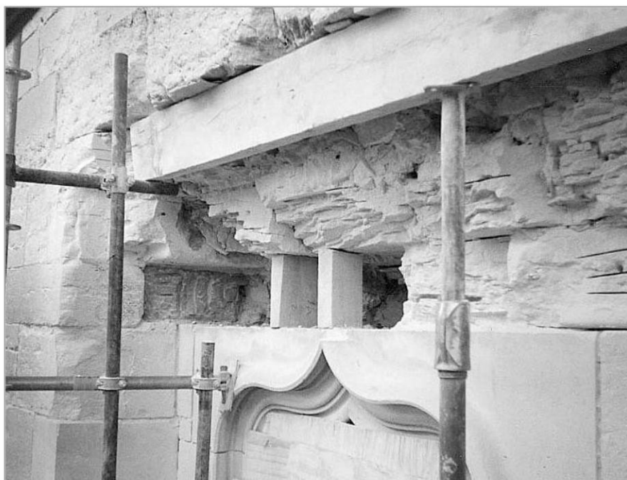
Pierre de linteau neuve positionnée, en attente des éléments supérieurs.
