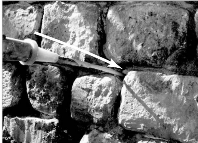
Exemple d'injection de coulis au travers d'un joint d'une maçonnerie de moellons.
