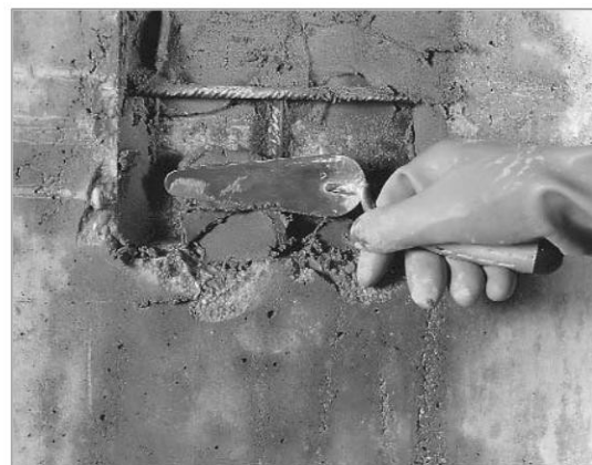
| Serrage du mortier à la truelle.
