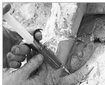
Injection à l'aide d'une seringue hypodermique.
