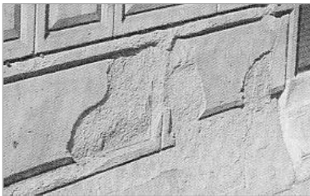
Exemple de désagrégation sableuse.
