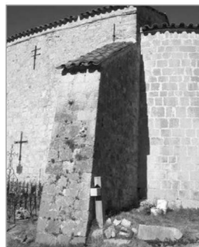
Têtes de tirants acier sur mur extérieur.
