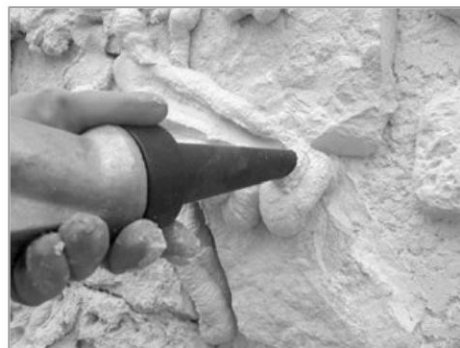
| Application du mortier à la machine.
