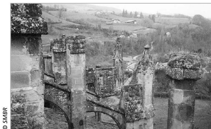
Salissures vertes et desquamation de la pierre dans une zone de gel et de brouillard fréquents (Abbaye de Saint-Antoine – Isère).
