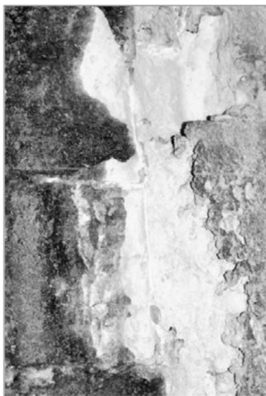
Exemple d'attaque par les sels induite par des remontées capillaires.
