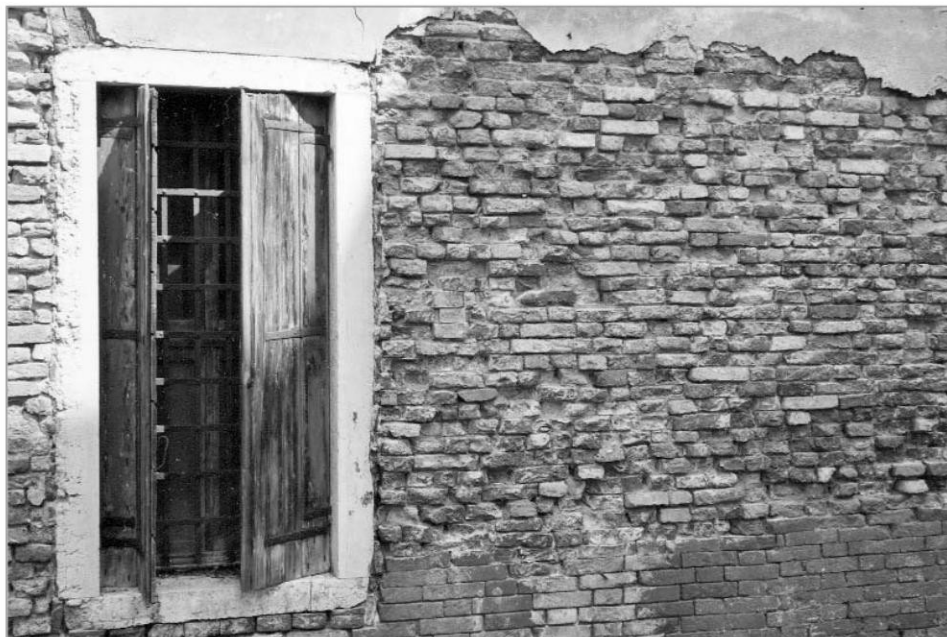
Mur de brique dont les joints ont disparu.
