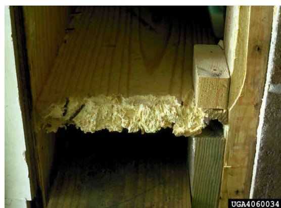
Dégât provoqué par des termites (Source : Arnold T. Drooz, USDA Forest Service, Bugwood.org)
