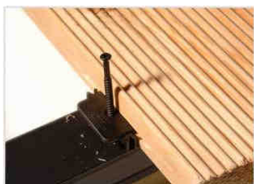
Pose de la lame suivante et vissage
