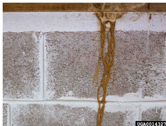
Tunnels fabriqués par les termites pour se protéger de la lumière (Source : USDA Forest Service Archive, USDA Forest Service, Bugwood.org)
