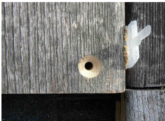
La cuvette pour la tête de vis
