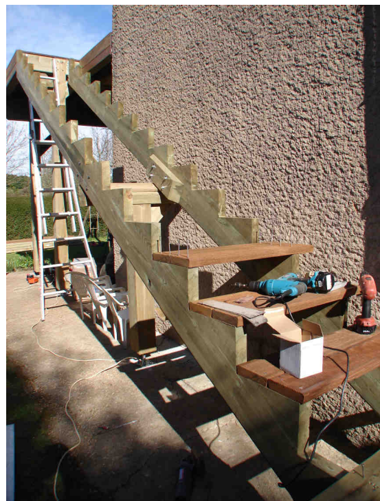
Escalier à limons en crémaillères en cours de construction (Source : Architecture du Bois, www.architecturedubois.fr )
