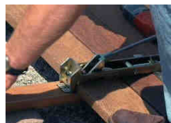
Insertion en puissance de la griffe dans une lame déjà en place
