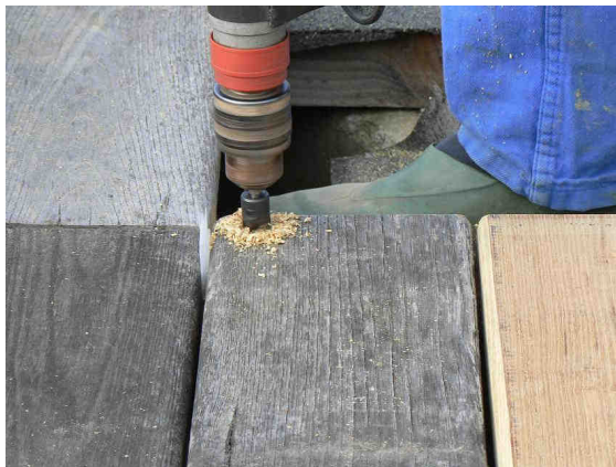
Utilisation d'une mèche à double étage
