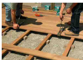
Insertion en force d'une lame contre les griffes préalablement fixées. Deux outils sont nécessaires
