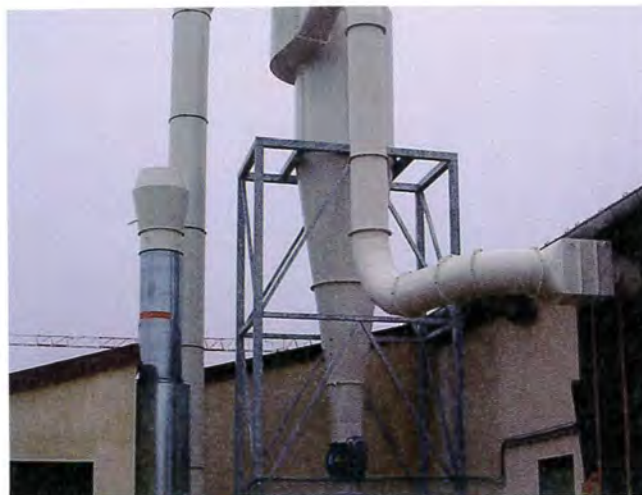
Système de dépoussiérage et d'aspiration centralisée haute dépression conforme aux directives ATEX.
