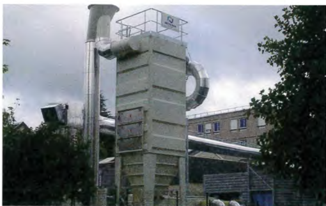
Remarquez, sur le côté de cette centrale de dépoussiérage, les trois événements (volets) destinés à éviter la propagation d'une explosion.
