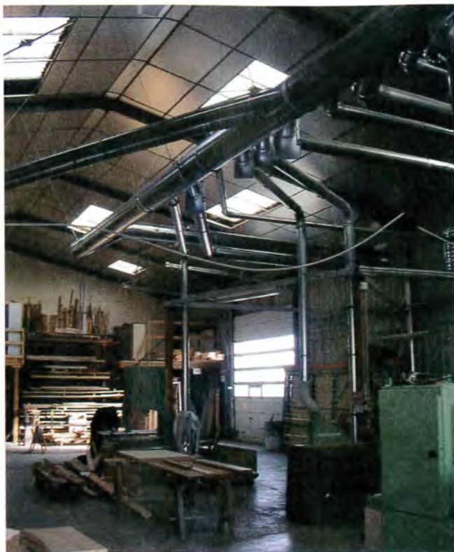
Installation classique de tuyauterie métallique en arborescence au plafond, dans un atelier de menuiserie.
