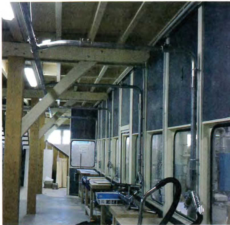
Dans cette salle de montage, l'installation « haute dépression » a été étudiée pour le branchement d'outils portatifs.
