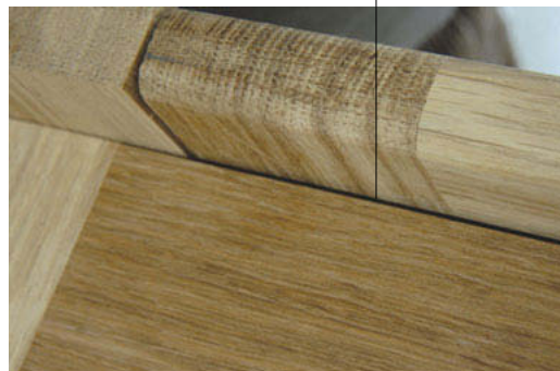
espace entre le dessus et le chant de la traverse.
