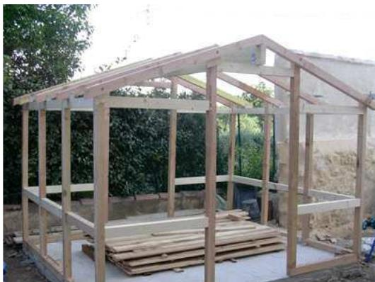
L'ossature est terminée ; enfin presque car il manque les contreventements : 2 à l'avant et à l'arrière ; 1 au milieu sur chaque largeur
