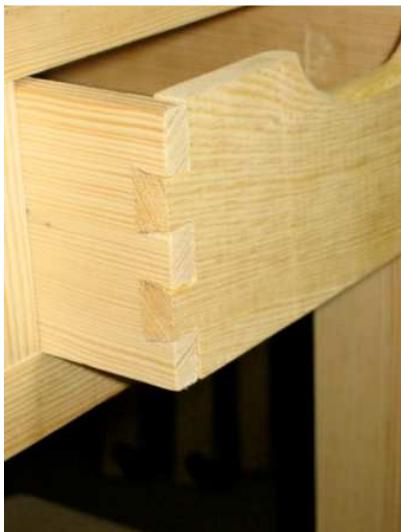
Les queues d'arondes ont été réalisées avec une défonceuse équipée d'une fraise à queue d'aronde. J'ai utilisé le gabarit que j'ai réalisé sur la base du plan fourni par Jean Marie du Berry sur son site. Merci !
