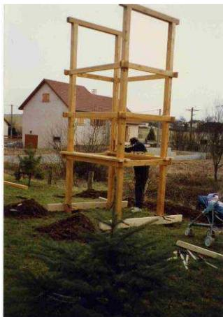
Tout est monté à plat, puis on bascule l'ensemble dans les trous réalisés dans le sol. On règle avec soin les niveaux puis on rebouche les trous.
