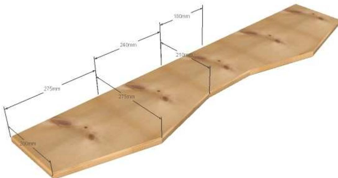
Faire les traçages nécessaires et découper soigneusement à la scie sauteuse.
