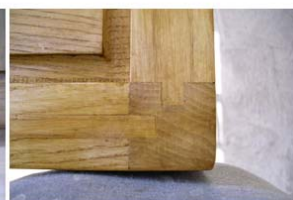
Détail assemblage du bâti
