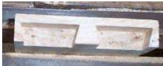
Queue d'aronde "femelle" pour assemblage recouvert
