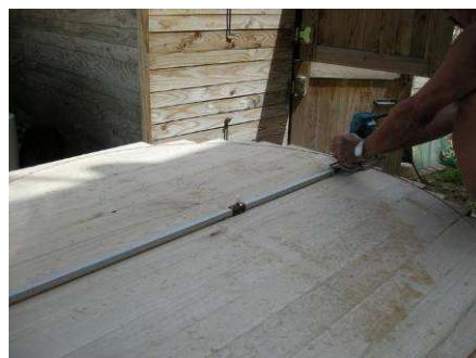
Pour ce plateau de 30 mm en châtaignier, j'ai fait des passes de 3mm. Afin d'éviter le bourrage, évacuer les copeaux de temps en temps.
