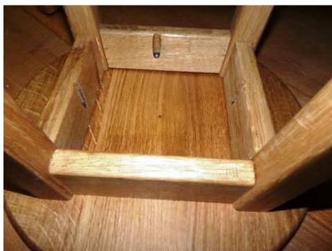
La fixation de l'assise sur le piétement est réalisée avec 4 vis biaises.
