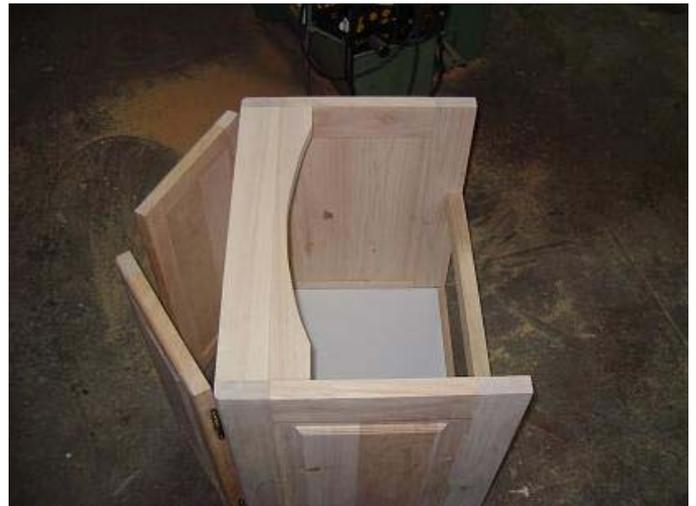
Passer à la fabrication des portes par le même processus que les côtés et finir par un  $\frac{1}{4}$  de rond en périphérie. Poser la quincaillerie en vérifiant l'alignement des portes.
