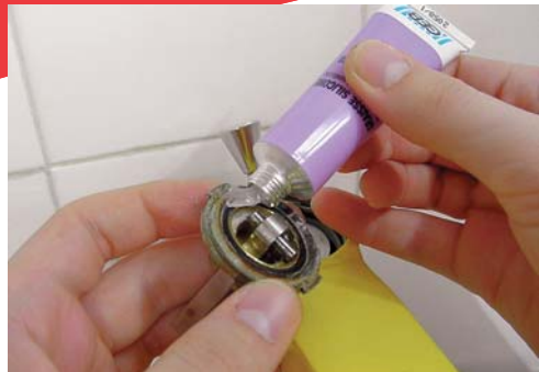
6 - Enduisez les pièces mécaniques de graisse au silicone. N'enduisez pas les disques céramiques !
