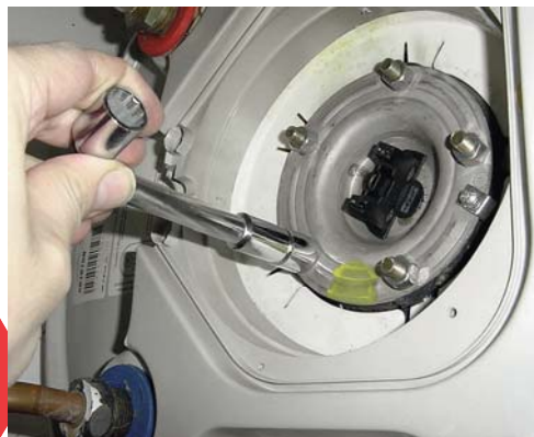
3 - Dévissez la platine électrique.
