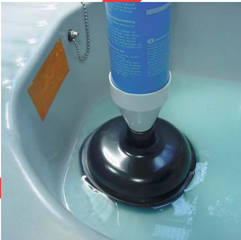
2 - Plaquez la ventouse du déboucheur sur la grille d'évacuation.
