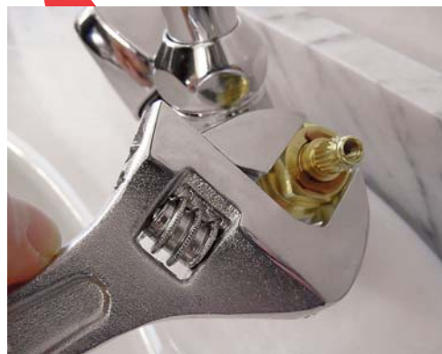
2 - Serrez fermement la tête dans le corps du robinet.
