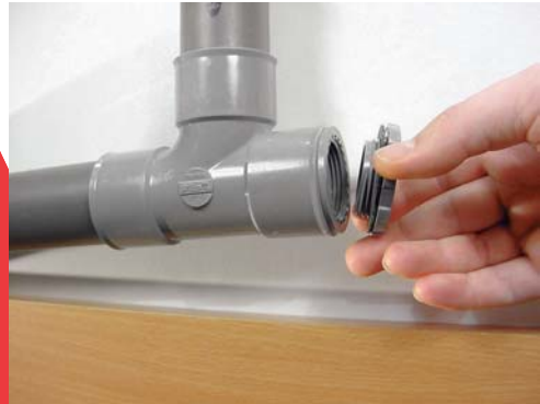
1 - Dévissez le bouchon du tampon de visite.
