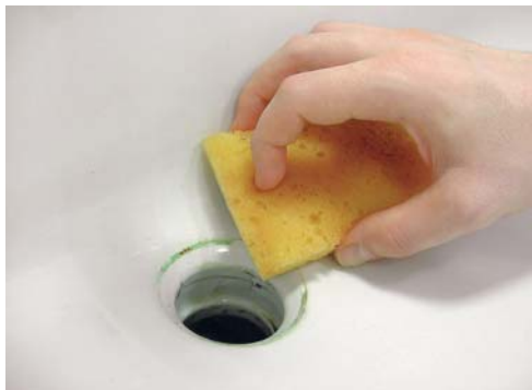
7 - Nettoyez soigneusement les bords du trou de passage de la bonde.
