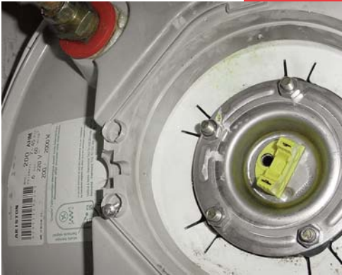
7 - Changez le joint et remontez la platine.
