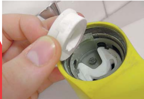
4 - Retirez les disques usagés (comme ici) ou la cartouche à disques céramiques.
