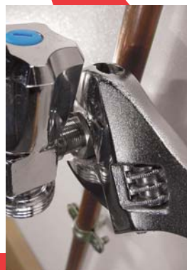
4 - Vissez jusqu'à ce que le tube de cuivre se perce.
