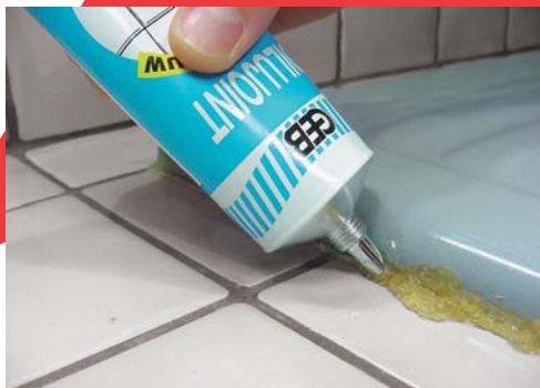
3 - Appliquez généreusement le dissolvant.
