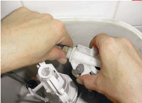
1 - Dévissez le robinet flotteur du réservoir.
