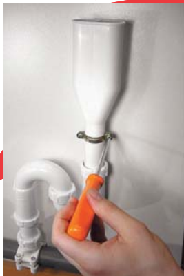
9 - Fixez l'entonnoir du siphon au mur à l'aide du collier fourni dans le kit.
