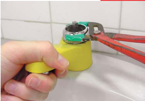
2 - Dévissez la bague de serrage de la tête avec une clé à molette ou une pince multiprise protégée.
