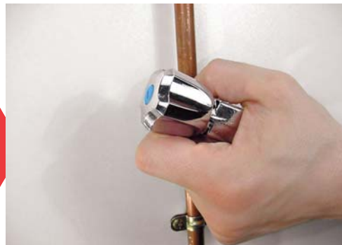
4 - Vissez jusqu'à ce que le tube de cuivre se perce.
