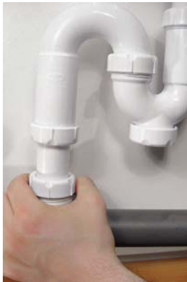
7 - Placez le joint sur le siphon.
