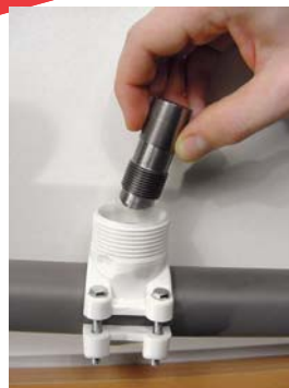
5 - Percez la canalisation avec l'emporte-pièce.
