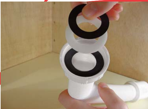
2 - Placez les bagues et les joints d'étanchéité dans l'écrou en plastique.
