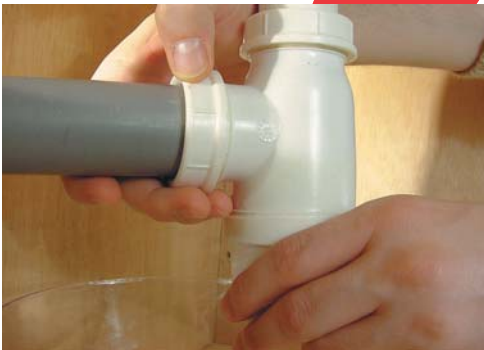
2 - Dévissez l'écrou de raccordement à l'évacuation.
