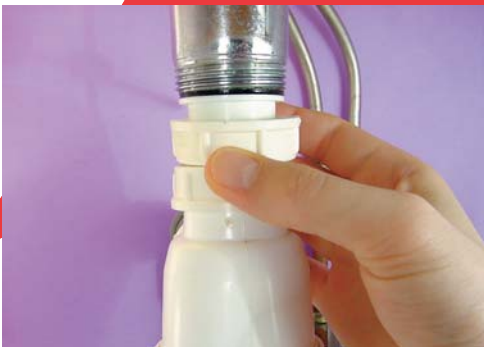
3 - Dévissez l'écrou supérieur du siphon.
