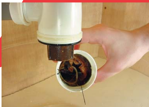
3 - Nettoyez le culot et l'intérieur du siphon.
