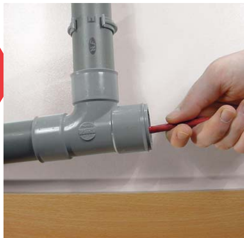
3 - Continuez de pousser le ressort jusqu'à ce qu'il bloque contre le bouchon ou contre un coude.
