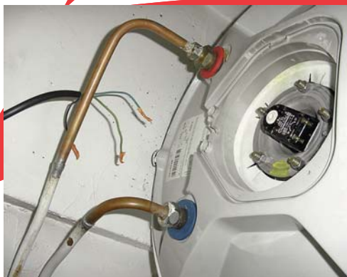
2 - Coupez le courant et débranchez l'appareil.
