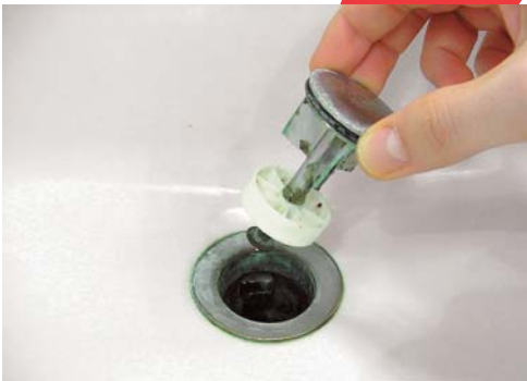
2 - Retirez le clapet de la bonde existante.
