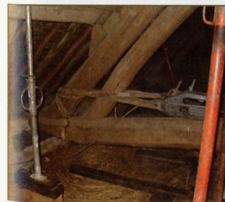
1. Un Tirfor® est utilisé pour «ramener» au plus près les deux éléments de l'entrait rompu.
