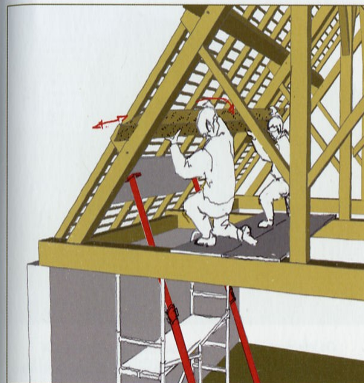
2. Deux personnes peuvent, aisément, dégager la panne en la faisant glisser sur l'arbalétrier.
