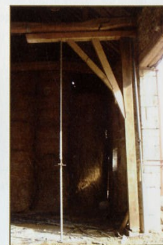
2. L'entrait repose sur une forte pièce de bois fixée à une poutre confortée par des aisseliers. Il va être boulonné à cet ouvrage de soutien ; le Tirfor® pourra ensuite être retiré.
