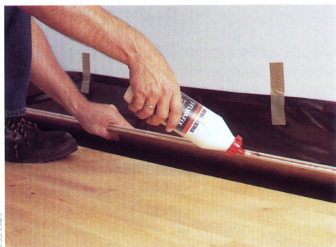
13 - Encollez la rainure de la dernière lame (elle ne peut pas recevoir de clips).
