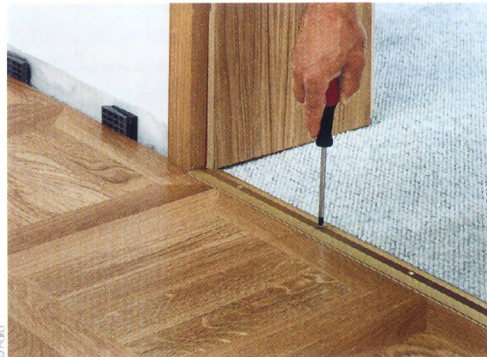
8 - Après la pose des dalles, fixez la partie supérieure de la barre de seuil.
