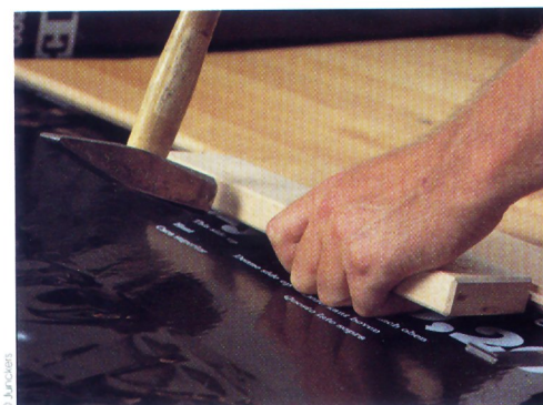
9 - Utilisez toujours une cale de frappe pour ne pas endommager la languette des lames de parquet.
