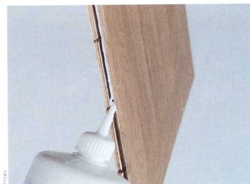
3 - Déposez un cordon continu de colle dans les rainures, côté parement.
