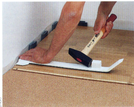
Le tire-lame permet d'enclencher les lames le long d'un mur.
