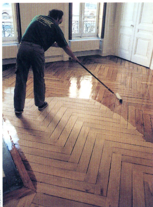
Vitrification au rouleau d'une grande pièce
