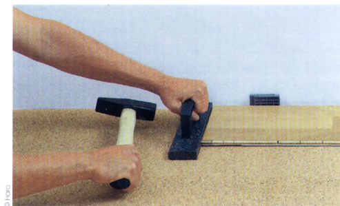
4 - Clipsez les lames de la première rangée à l'aide du marteau et de la cale de frappe.
