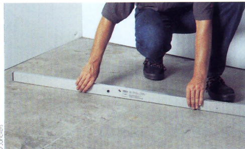
1 - Vérifiez la planéité du support avec une règle et un niveau. Réalisez un ragréage P3 le cas échéant.
