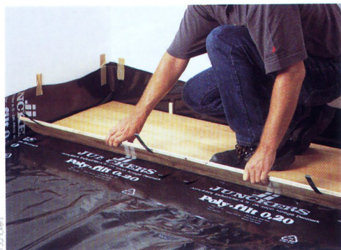
7 - Lorsqu'une rangée complète est prête (clips et collage des bouts), posez-la sur les clips précédents.
