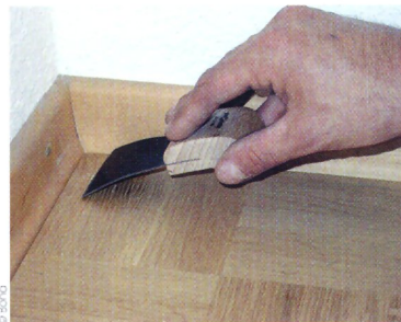
Dans les angles, utilisez un racloir.
