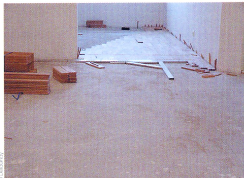
La pose collée s'effectue sur un sol plan, lisse, propre et sec.
