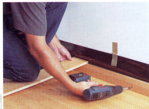
15 - Dès la fin de la pose, retirez les cales, puis fixez les plinthes.
