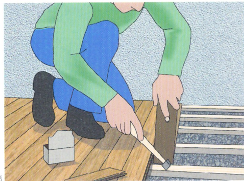
10 - Poursuivez la pose en tapant les lames avec une cale martyr pour bien les emboîter.
