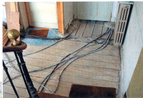
1 - Sur un ancien plancher de coffrage, on a passé des lignes électriques avant les lambourdes.
