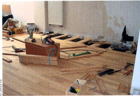
4 - Une isolation thermique et phonique a été réalisée avec des flocons de liège entre les lambourdes.
