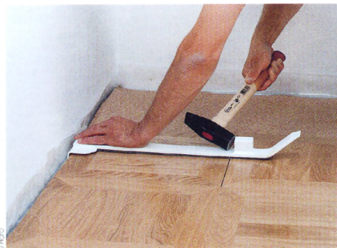
6 - Pour parfaire l'assemblage des dalles de bout, utilisez un tire-lame et un marteau.
