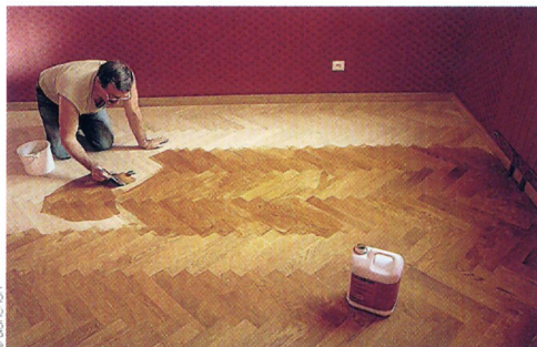
Application d'une teinte de fond pour un aspect "chêne teinté à l'ammoniaque".
