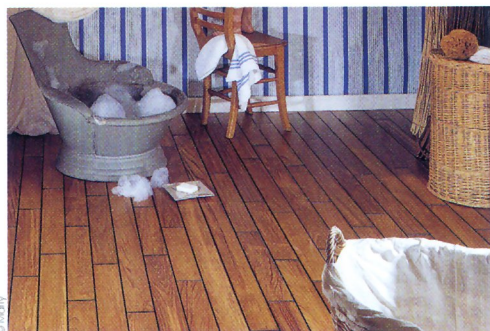
Les parquets en pont de bateau peuvent être réalisés avec des joints sur les quatre côtés des lames.
