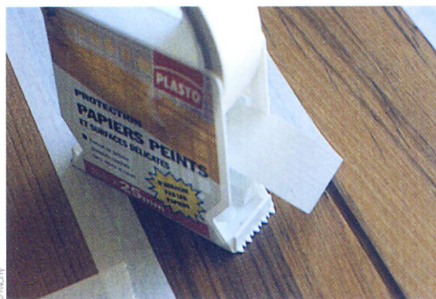
2 - Laissez sécher 72 heures, puis collez du ruban de masquage à cheval sur les joints.
