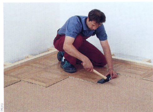
2 - Collez les rangées 1 et 2, puis progressez à partir de l'angle. Tapez les dalles au moyen d'une cale.
