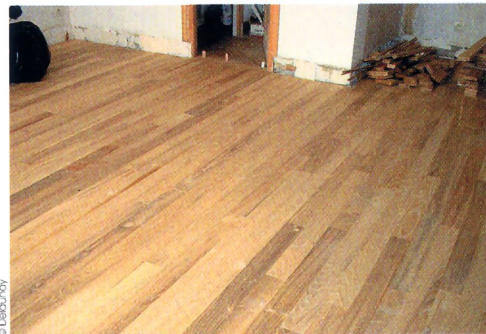
5 - Lors de la pose, des cales ont été placées le long des murs pour respecter le jeu de dilatation.
