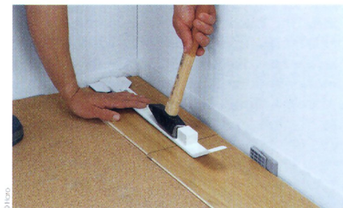
5 - Après découpe à la mesure, assemblez la dernière lame de la rangée au moyen du tire-lame.
