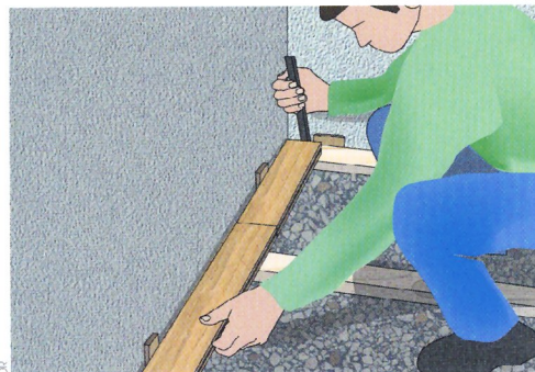
4 - Assemblez à blanc une première rangée de lames. Utilisez un tire-lame près du mur.
