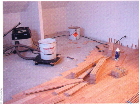
Progressez au fur et à mesure. Lestez les lames fraîchement posées avec des bottes de lames.
