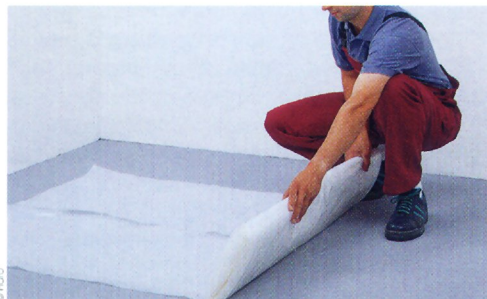
1 - Déroulez une feuille de polyéthylène en chevauchant les raccords (sur 20 cm minimum).
