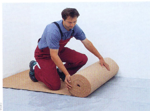
1 - Posez éventuellement un film polyéthylène, puis une sous-couche résiliente.
