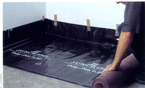
2 - Déroulez la sous-couche préconisée par le fabricant sans oublier les remontées latérales.
