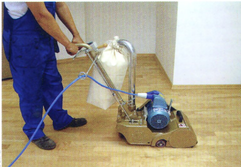
Poncez en faisant des allers-retours dans le sens du parquet, à partir de la gauche de la pièce.
