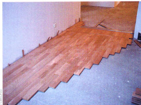
Respectez les jeux de dilatation (cales le long des parois). Débutez perpendiculairement au seuil.
