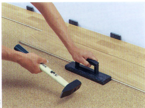
7 - Emboîtez la lame sur sa longueur jusqu'au déclic en tapant doucement sur la cale de frappe.
