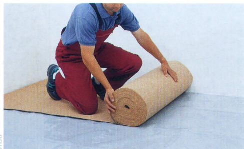
2 - Pour l'isolation phonique et l'égalisation des aspérités, déroulez une sous-couche.
