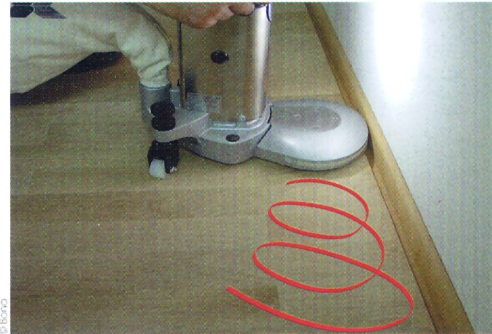
Baissez la machine doucement, puis poncez en effectuant des rotations.
