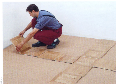
2 - Posez les dalles sans les coller et centrez-les de façon à équilibrer les coupes de chaque côté.
