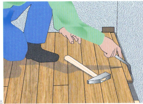
12 - Placez la dernière lame au moyen d'un tire-lame, puis clouez-la par son parement.
