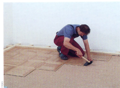
3 - Continuez le collage en suivant l'ordre de pose préconisé (voir ci-contre).
