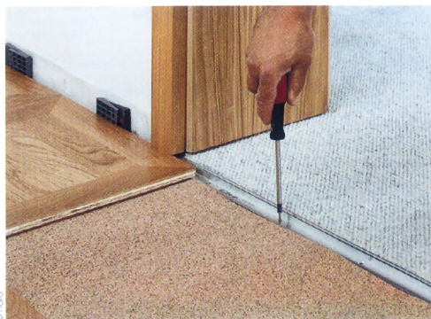
7 - Fixez les socles pour barres de seuil en respectant le jeu de dilatation.
