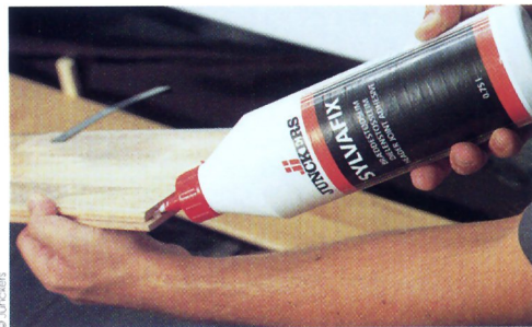
6 - Le bout des lames est collé. Appliquez un filet de colle en haut des rainures, côté parement.
