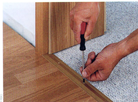
9 - Pour conserver le jeu de dilatation au seuil des portes, installez un profilé spécial (voir page 49).
