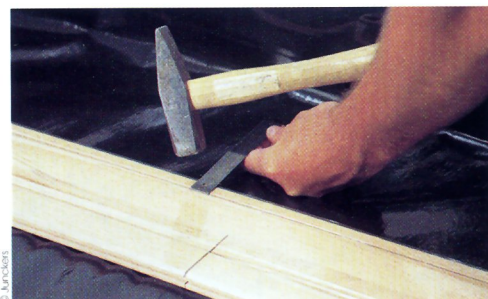
3 - Enclenchez les clips dans la rainure située côté languette sur le contreparement de la lame.
