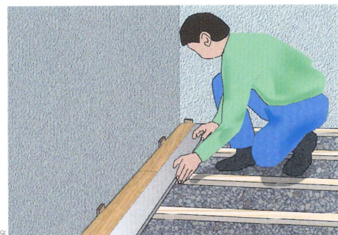
5 - Au moyen d'une règle, vérifiez l'alignement et l'angle des lames par rapport au mur.
