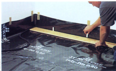
4 - Positionnez la première lame après avoir installé les cales et le joint pour le jeu de dilatation.
