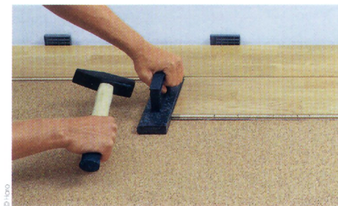
6 - Continuez avec la deuxième rangée. Tapez la lame sur le plus petit côté en premier.
