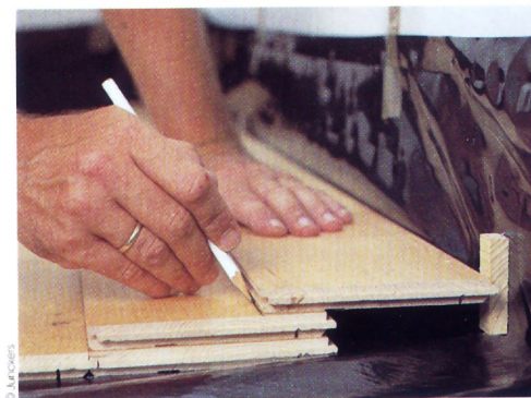
12 - Mesurez et tracez la largeur de la dernière lame, en tenant compte de la cale.
