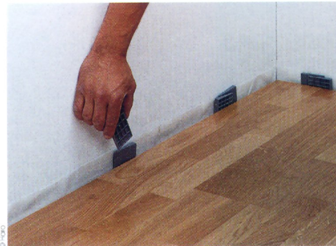
11 - Dès que la pose est terminée, il est impératif d'enlever les cales.
