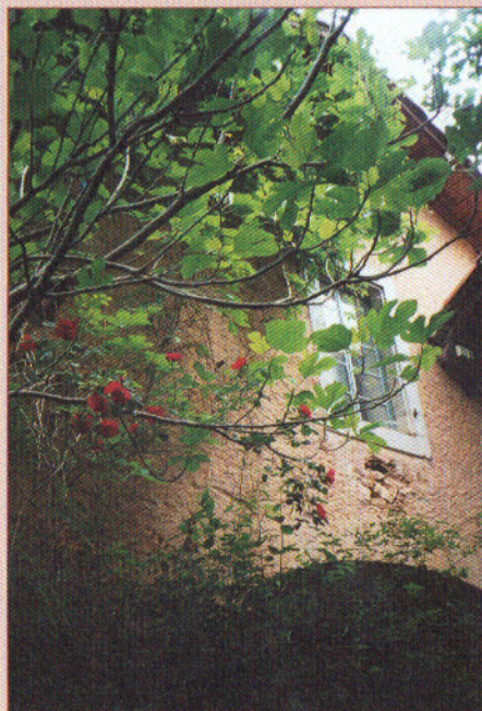
Une simple couche de badigeon a suffit pour colorer cette façade bâtie « à sable et à chaux » il y a plus de 200 ans.
