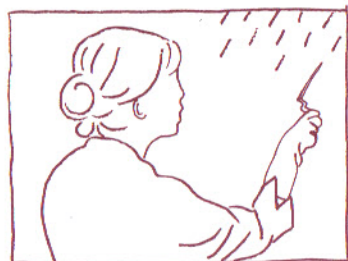
Pour une bonne accroche de la deuxième couche, on hachure l'enduit qui vient d'être posé.
