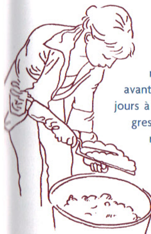
L'enduit est posé sur la taloche à l'aide d'une langue de chat.
