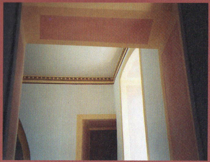
Ensemble décoratif entièrement réalisé avec des badigeons de chaux.
