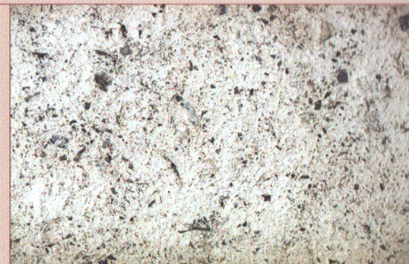
Pour cet enduit réalisé en montagne (à plus de 2 000 m d'altitude), on a ajouté au sable et à la chaux un gravier noir roulé dans le torrent qui coulait près du chantier.
