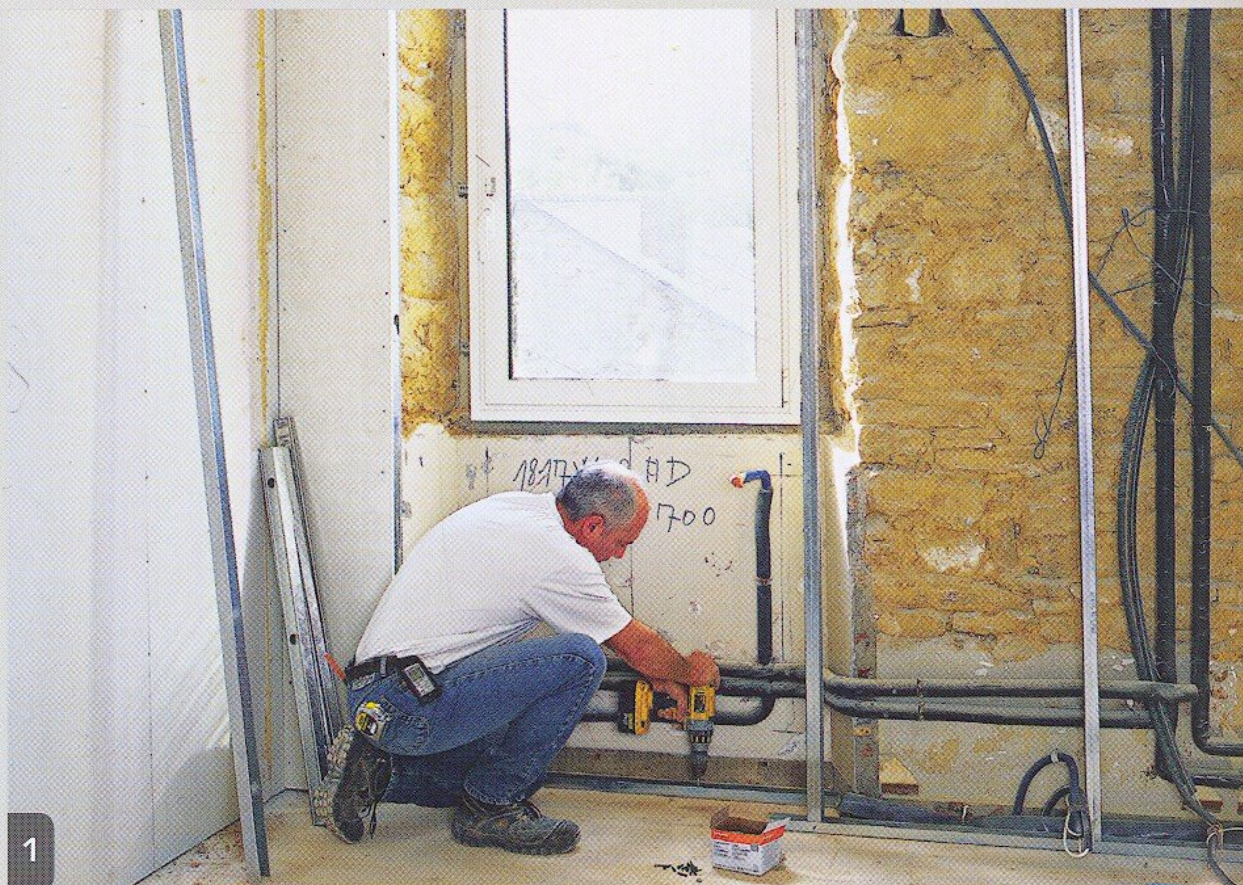
1 Les rails se fixent en vis-à-vis au sol et au plafond à une distance du mur égale à l'épaisseur de l'isolant.
