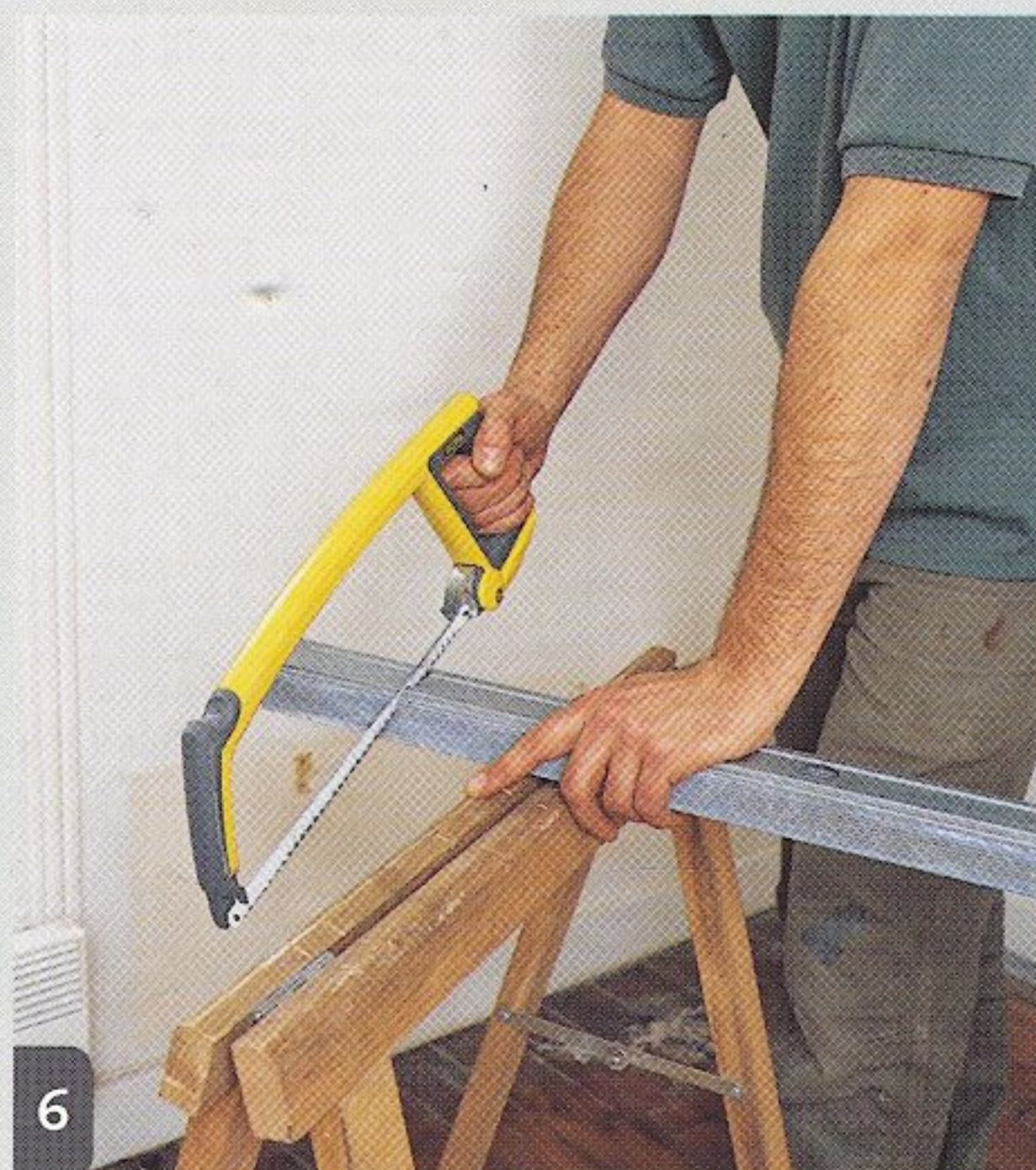
6 Couper les montants 2 par 2, en les encastrant l'un dans l'autre, à la hauteur entre rails moins 5 mm.
