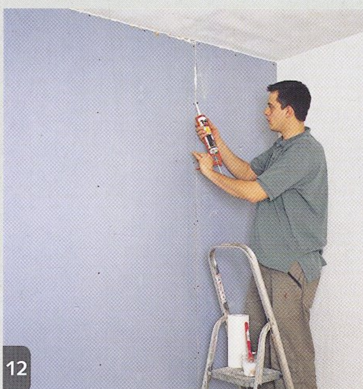
12 Uniquement pour la 1 ère épaisseur, remplir les joints entre les plaques et en périphérie de la cloison avec du mastic acrylique extrudé au pistolet.
