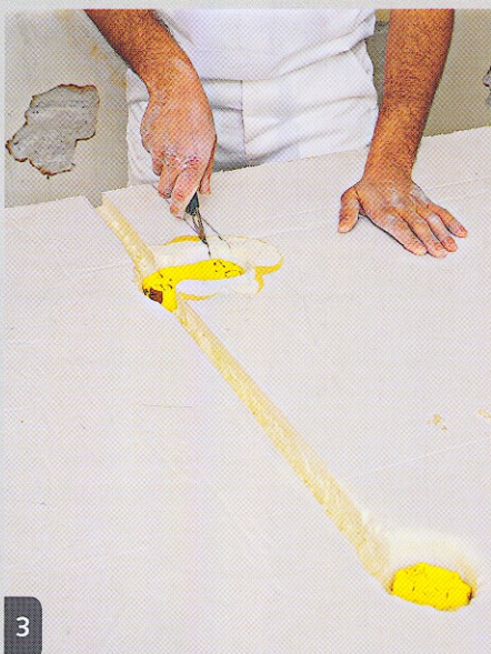
3 L'isolant est entaillé au cutter sur une profondeur minimum pour encastrer les gaines électriques.
