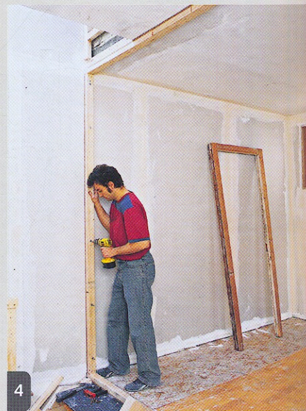
Les tasseaux muraux achèvent le cadre, ils sont intercalés entre ceux du haut et du bas et dissimulent la bande résiliente.
