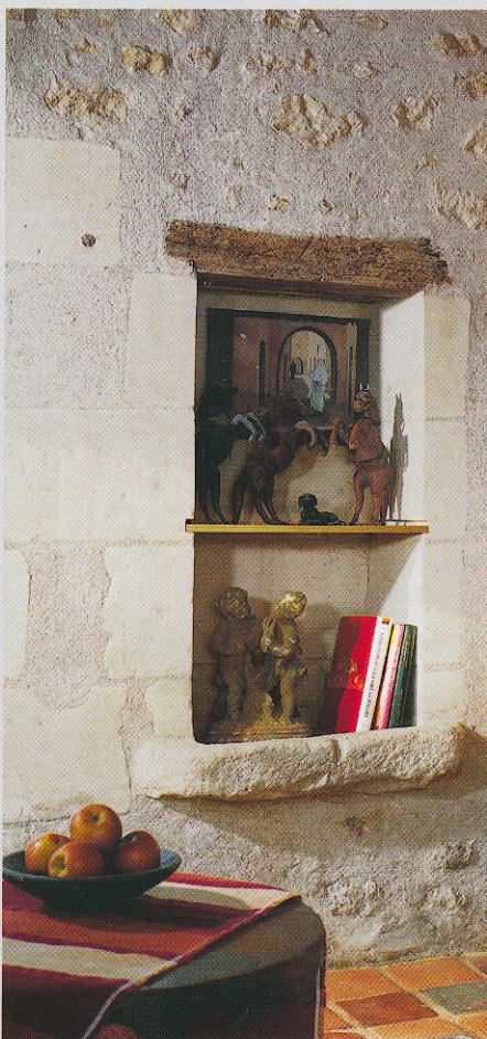
L'enduit à pierres vues laisse les pierres apparentes. Il crée des décors adoucis, moins rustique que si les joints sont creusés.
