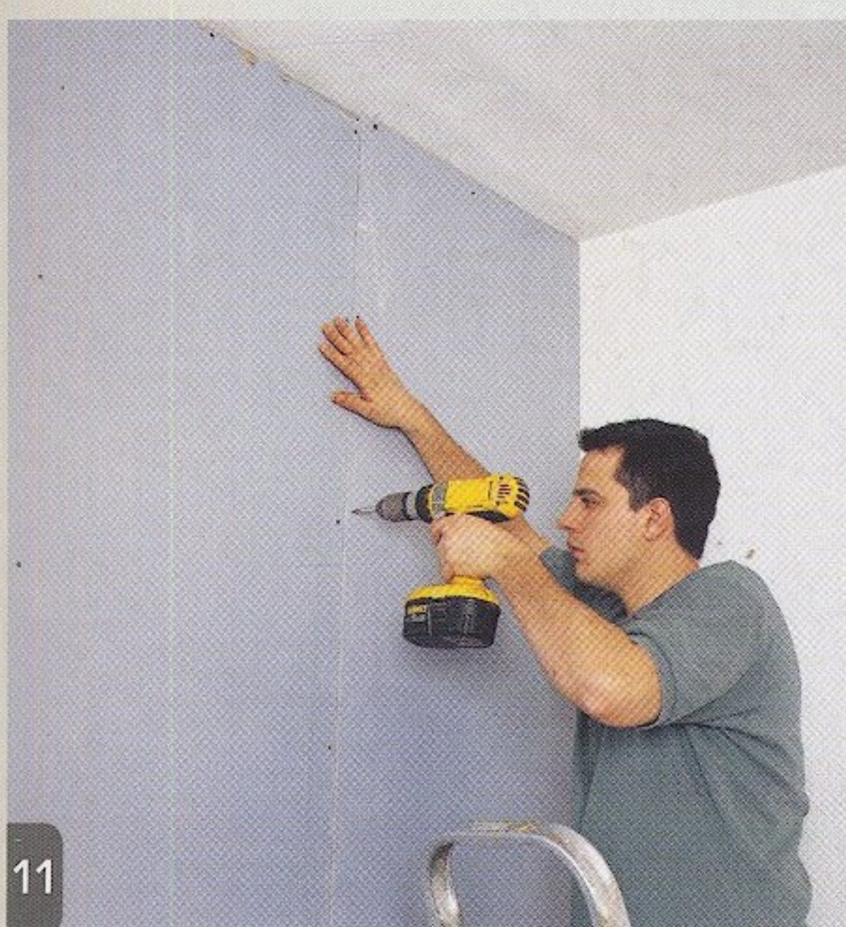
11 On visse les plaques dans chaque montant avec des vis spéciales (vis TTPC25), sans préperçage.
