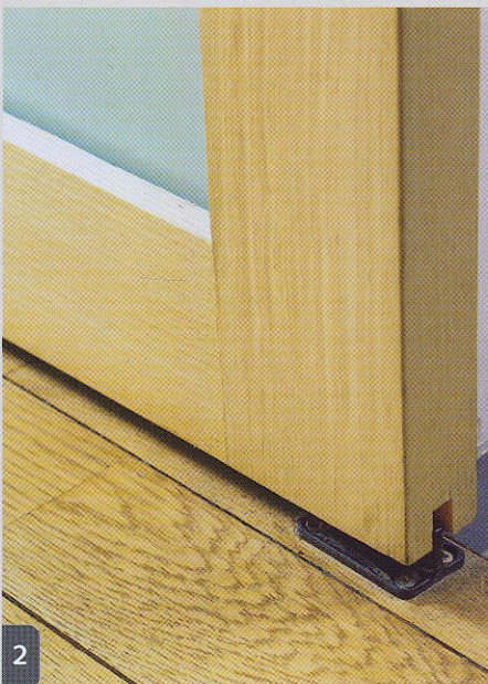
Les cloisons suspendues sont guidées en bas pour éviter le battement. Les guides vissés dans le sol s'encastrent dans une rainure invisible.
