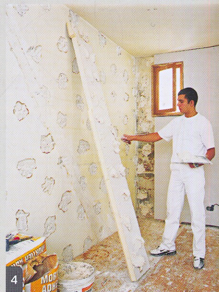
4 Sur les parois régulières, les plots de colle s'appliquent au dos des parements à raison de 9 plots/m 2 . Leur épaisseur est constante.
