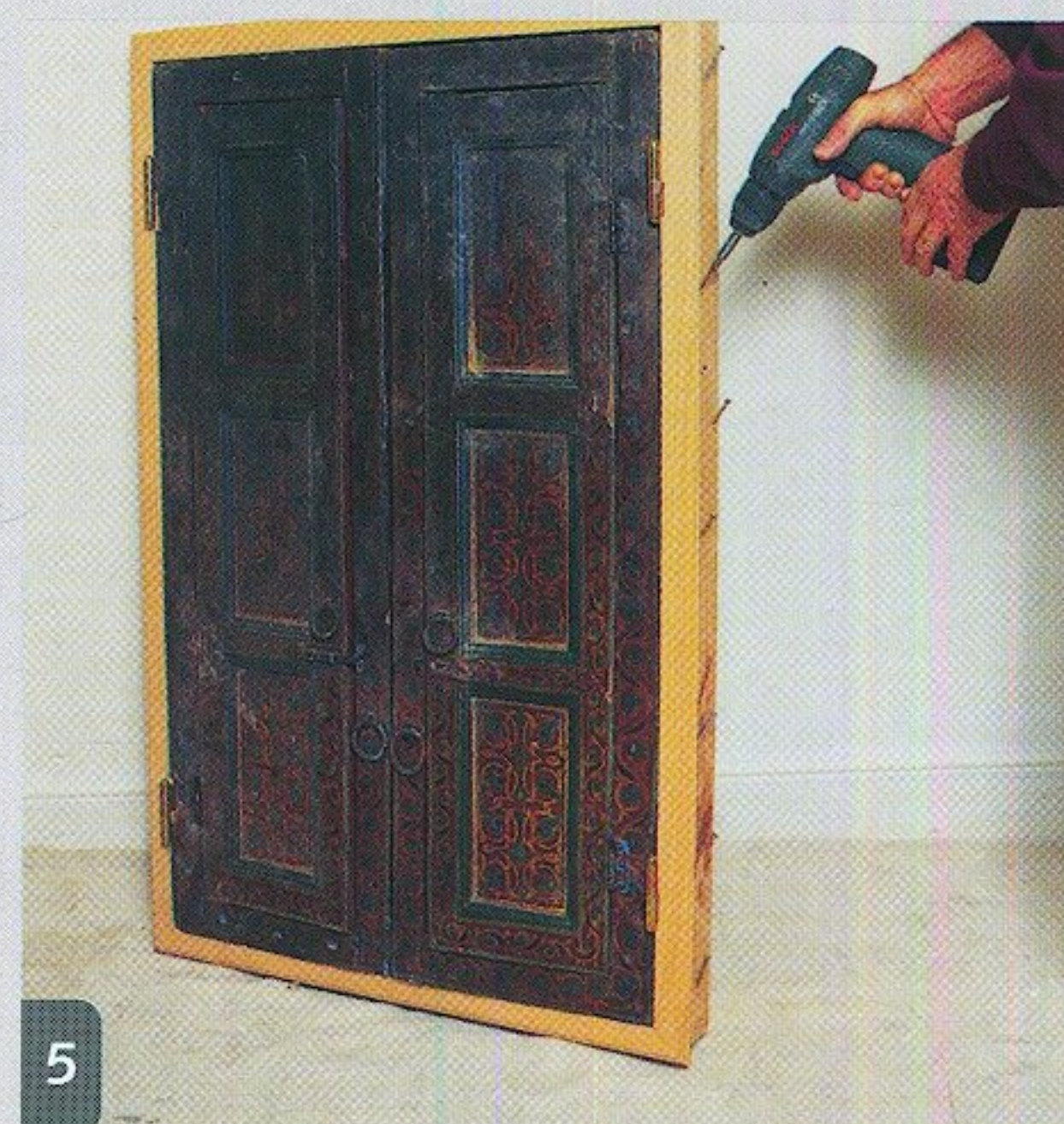
5 La fenêtre est ceinturée d'un châssis dans lequel on enfonce partiellement des vis en biais. Elles renforcent la tenue du plâtre nécessaire au scellement.
