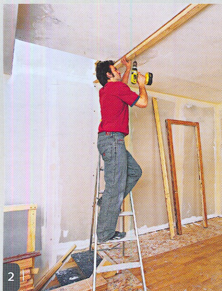
En suivant le tracé, visser le premier tasseau au plafond en intercalant la bande résiliente.
