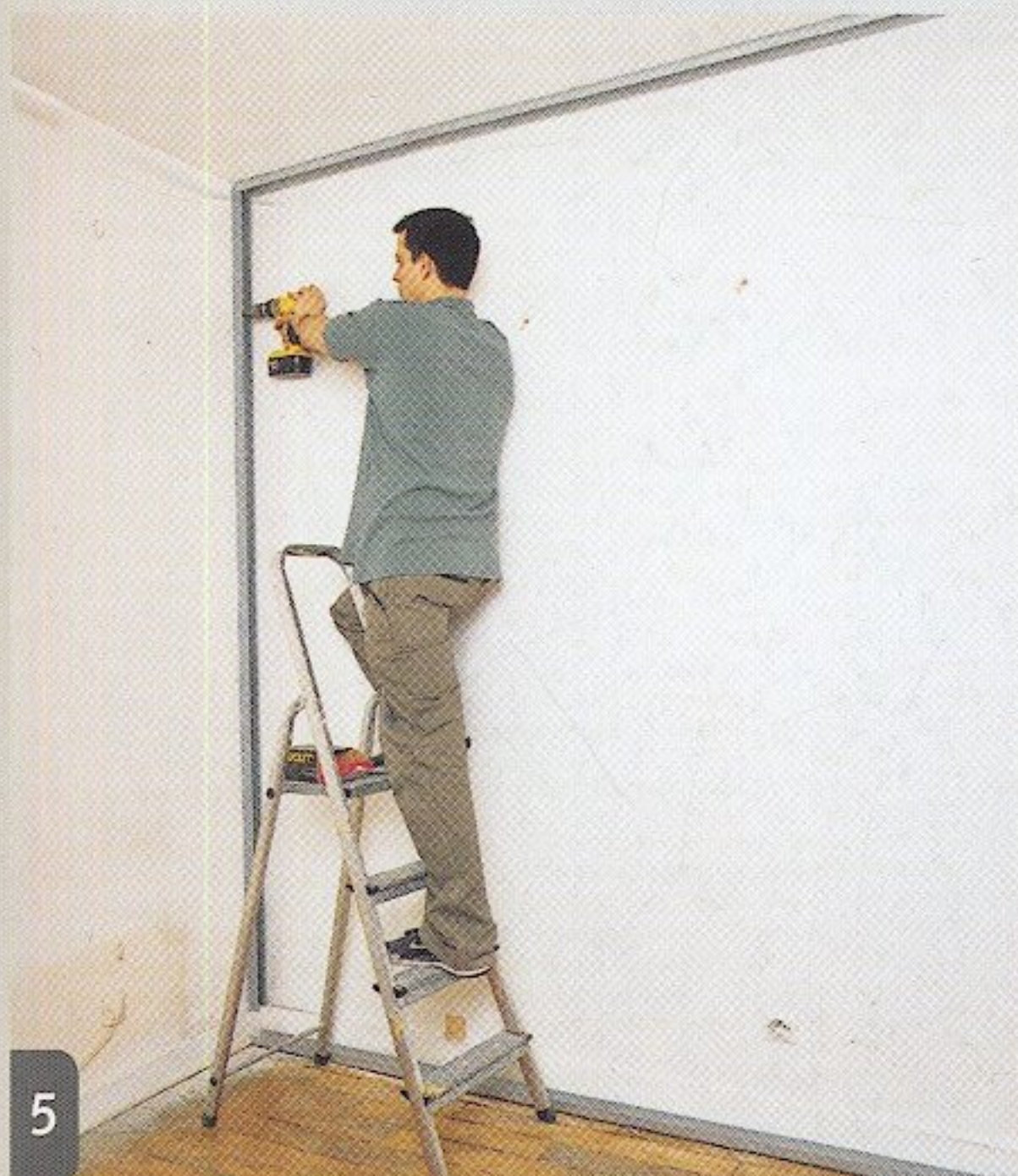
5 Au plafond et sur les parois latérales, les rails sont également munis de bande résiliente.
