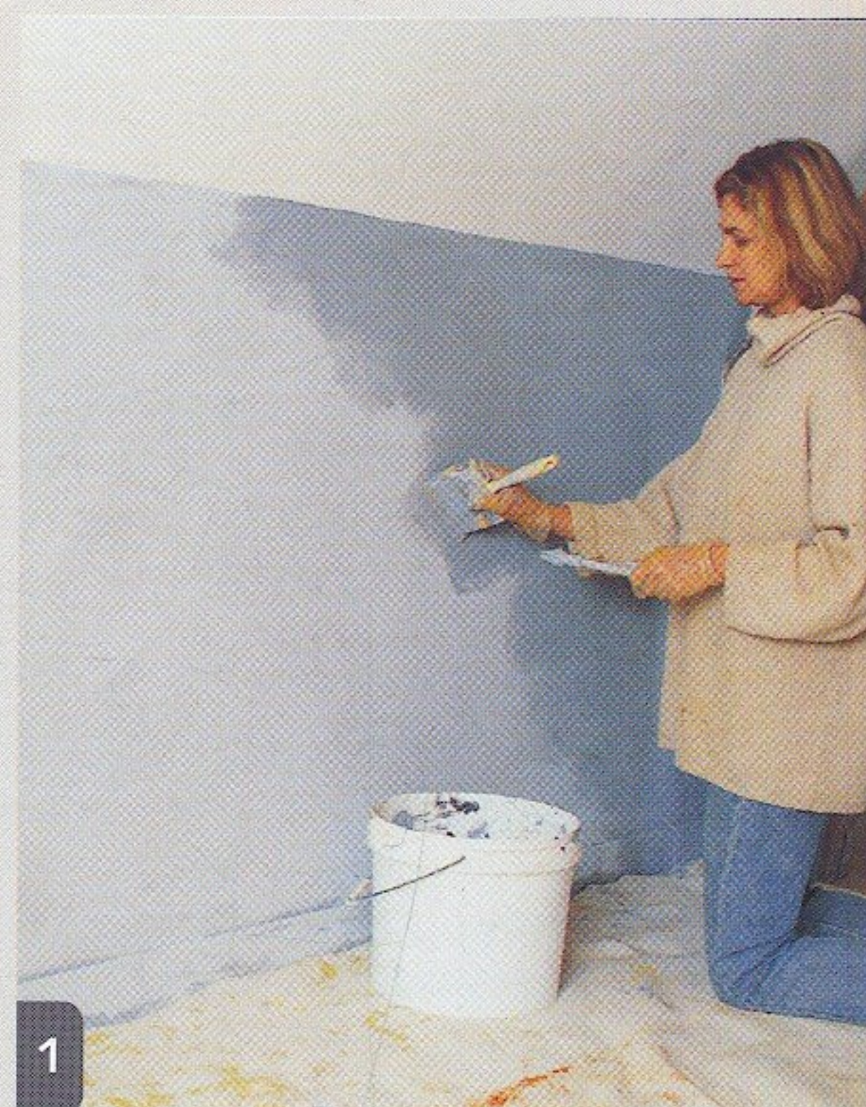
La brosse se tient près des soies pour appliquer le badigeon de haut en bas du mur. On ne doit pas le « tirer », mais le déposer avec des gestes obliques.
