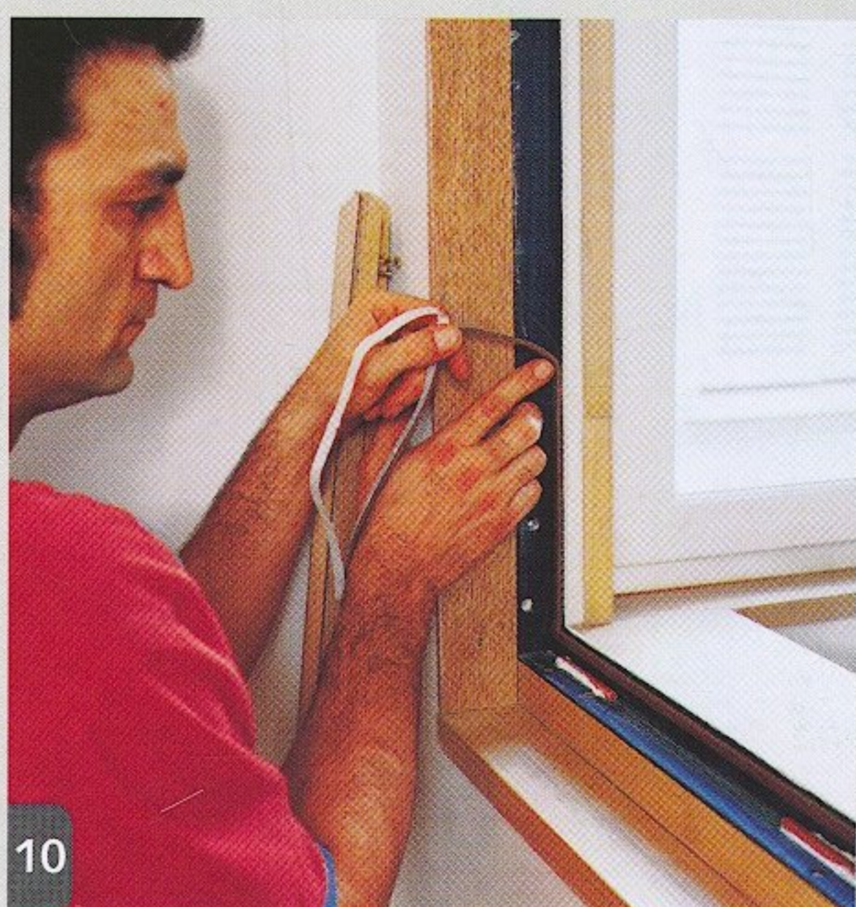
Des cales de vitrage sont placées en assise et en périphérie, puis on pose le joint auto-adhésif tout autour du châssis.
