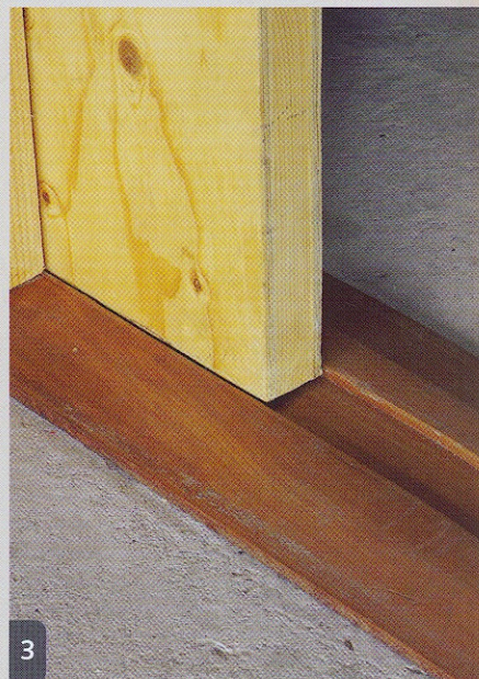
En version roulante, la cloison est dirigée par un rail de sol en saillie ou encastrée dans le plancher.
