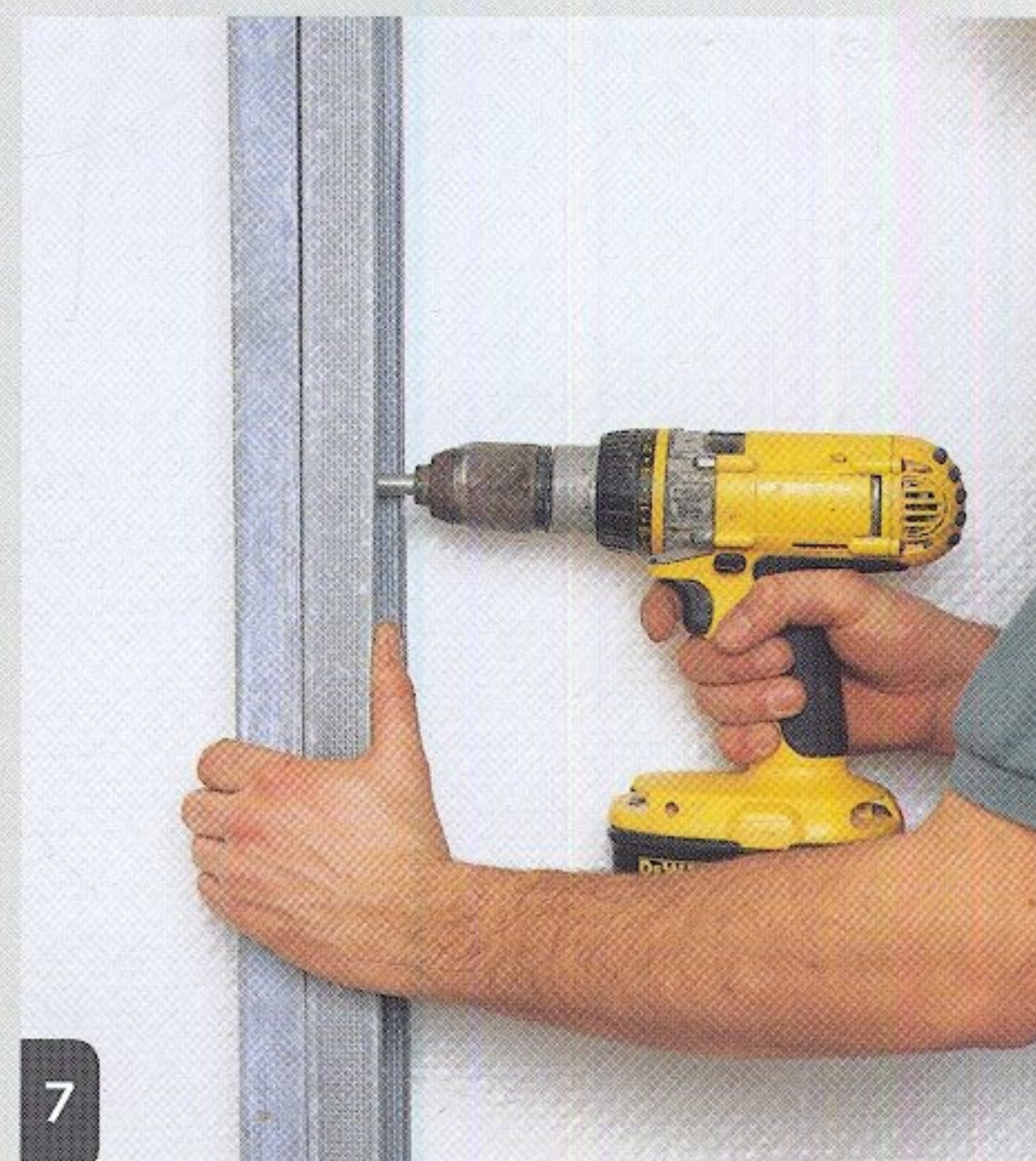
7 Les montants sont doublés et vissés dos-à-dos entre les rails selon une largeur d'entraxe de 60 cm.
