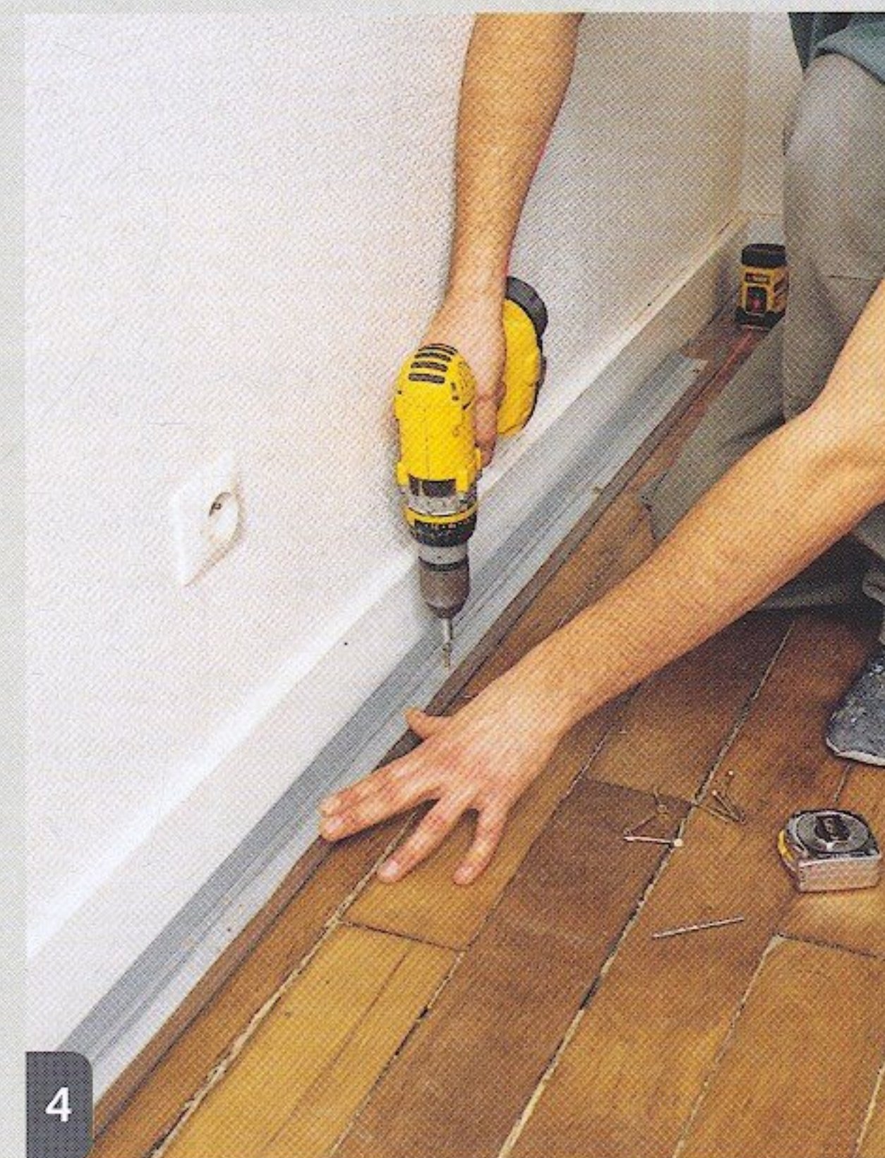
4 À distance de la paroi (ce qui permet de laisser la plinthe), placer le rail de sol muni de sa bande. Le visser dans le plancher.
