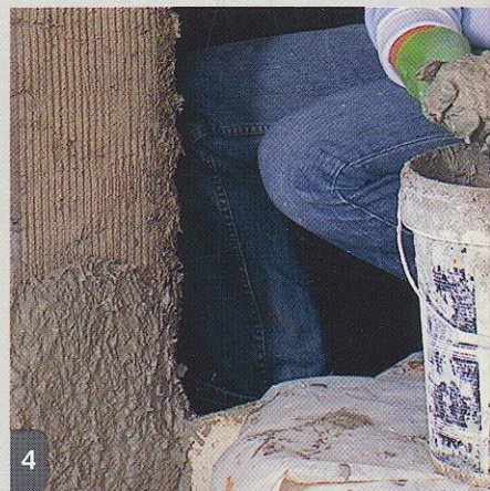
4 L'enduit gâché en bétonnière est prélevé à la main. Une bonne paire de gants est indispensable.
