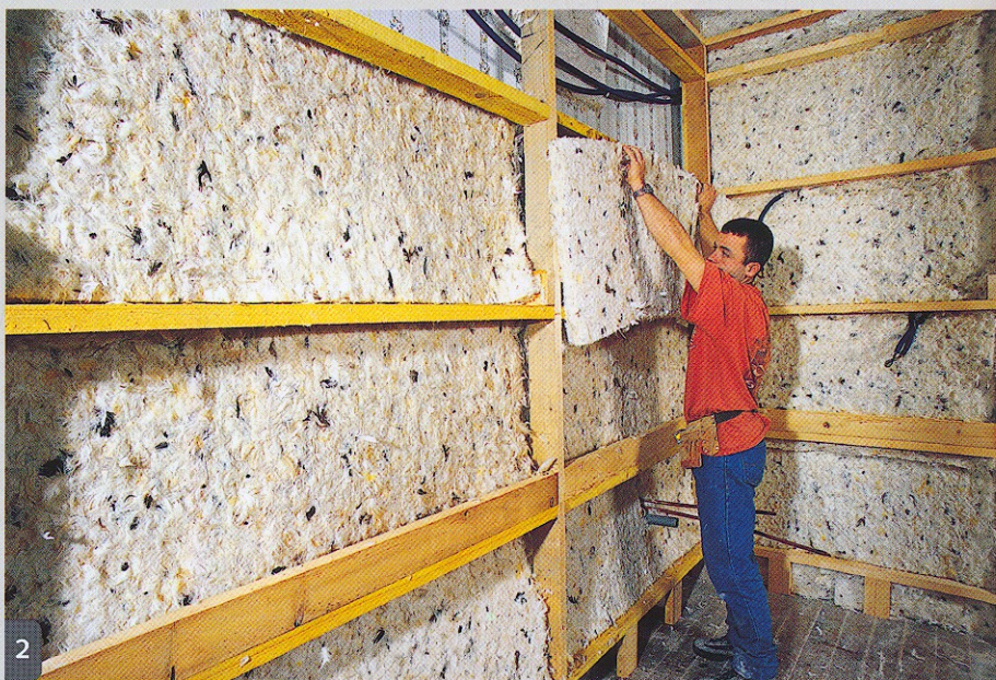
L'isolant est posé en deux couches de 80 mm. La première vient se glisser derrière l'ossature décalée du mur pour que les panneaux soient jointifs.
