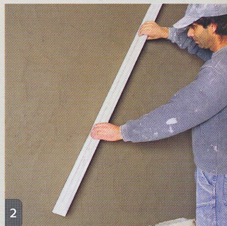
2 Pour l'égaliser, racle le gobetis à la règle. Celle-ci permet de contrôler la planéité de la surface.
