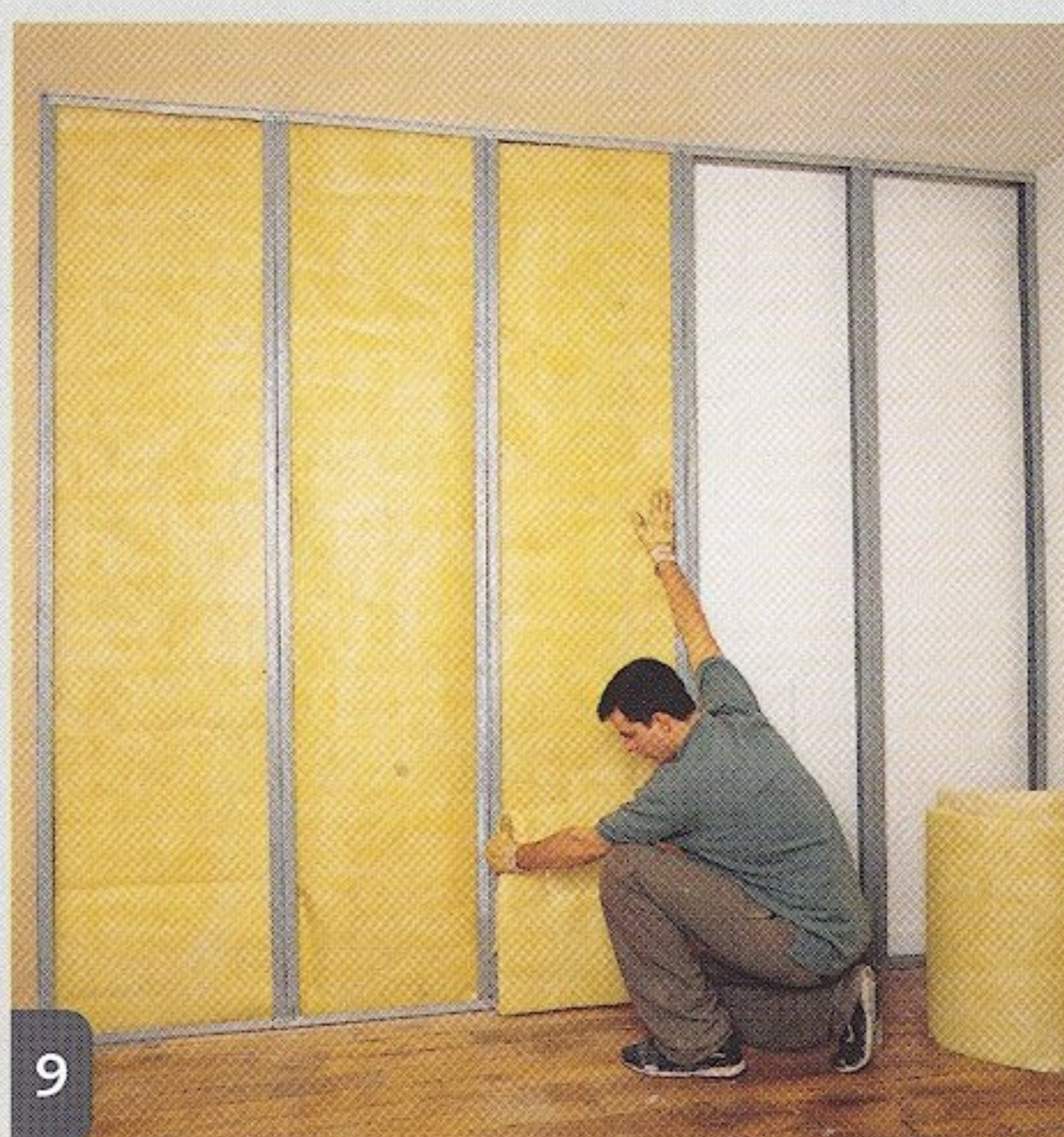
9 La 1 ère couche est derrière les montants, la 2 de est encastrée entre eux et tient par compression.
