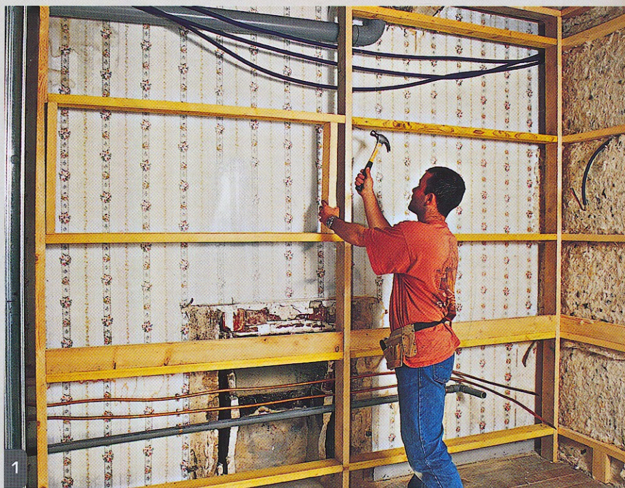
Une ossature en bois convient idéalement aux isolants naturels tels que la plume de canard « Batiplum », pour poser ensuite un parement en lambris. Son épaisseur est adaptée à celle de l'isolant qui doit remplir intégralement la lame d'air.
