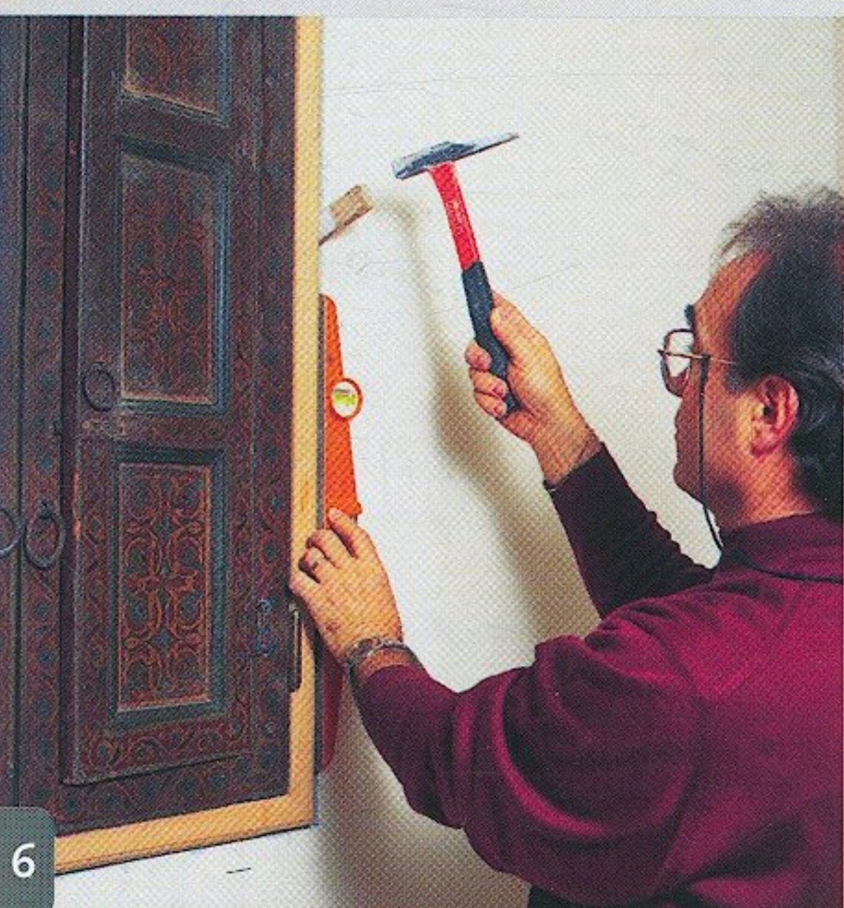
6 Pour caler le châssis d'aplomb dans l'ouverture, on le bloque au moyen de cales en bois biseautées réparties régulièrement en périphérie.
