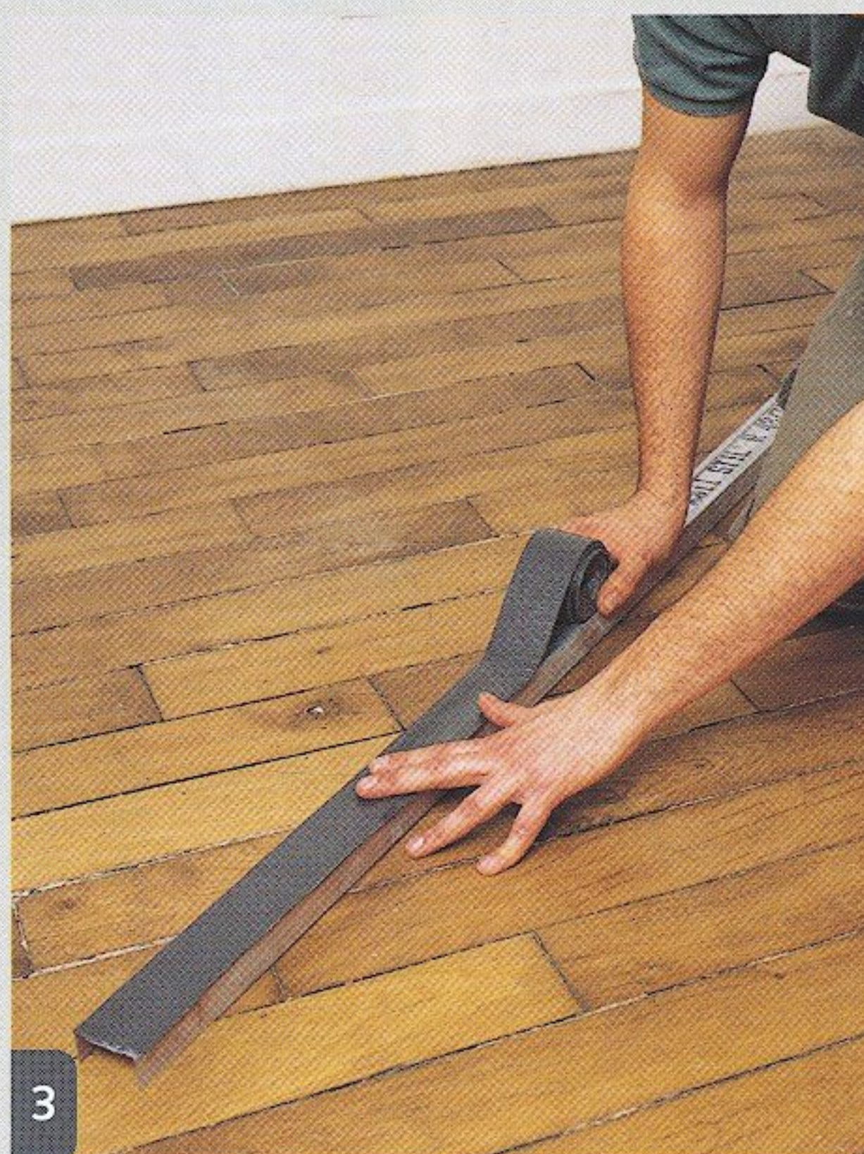
3 Au dos des rails, poser la bande résiliente autocollante de 3 mm d'épaisseur.
