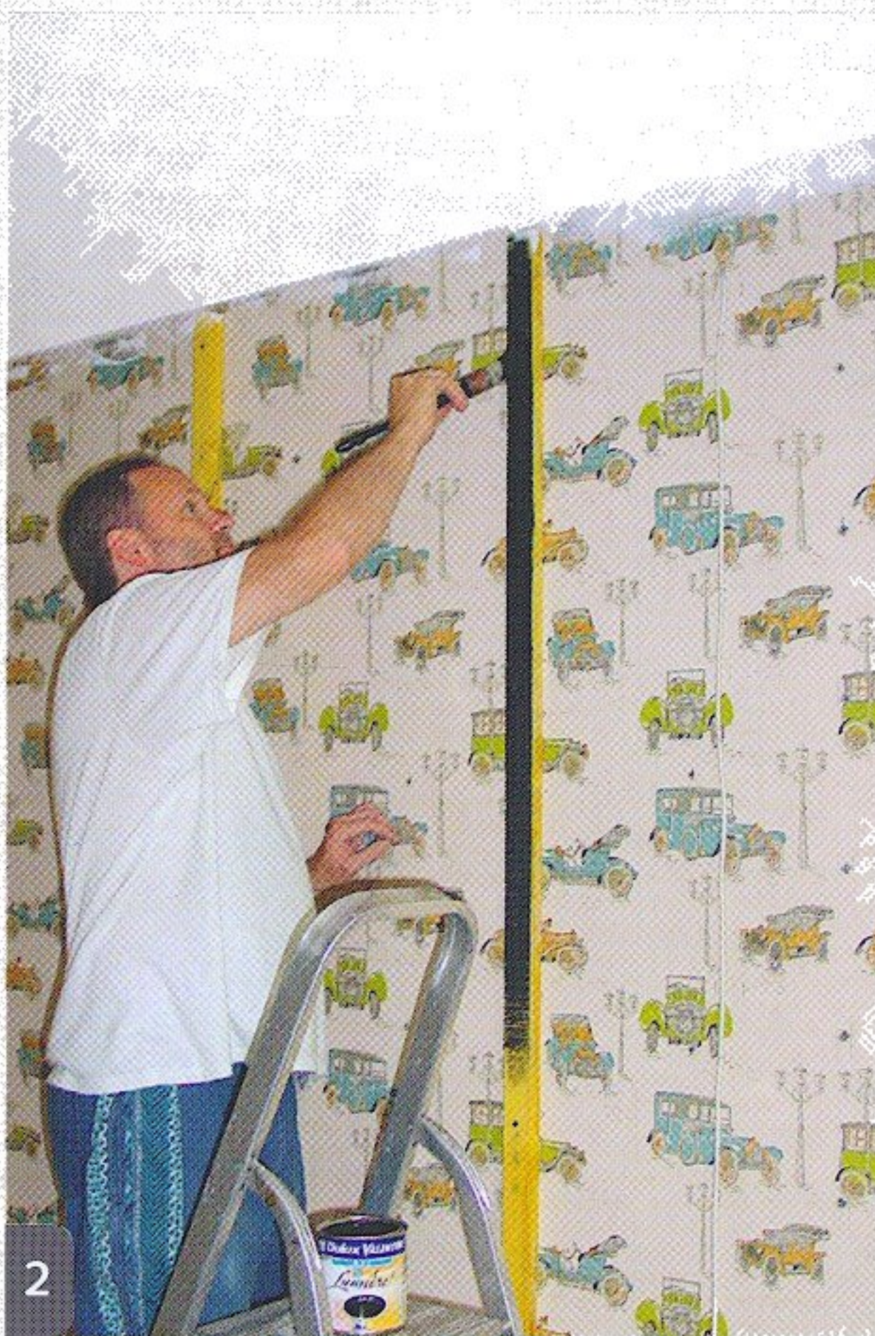
Une bande résiliente est intercalée entre les murs et les tasseaux. Après le vissage, on les peint en noir.
