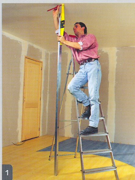
1 Sur le plafond, reporter le centre du cercle qui est tracé sur le sol en maintenant verticalement un montant destiné à l'ossature.
