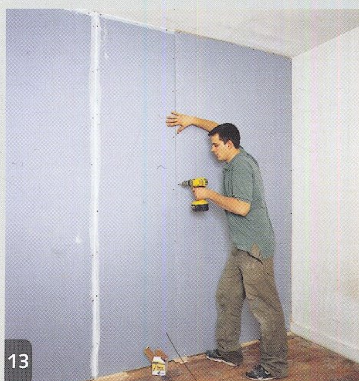
13 Pour la 2 e épaisseur, on commence par une demi-plaque afin de décaler les joints. Le vissage s'effectue avec des vis plus longues (vis TTPC35).
