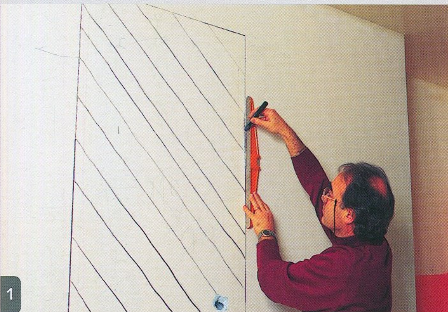
1 On dessine l'ouverture sur la cloison en suivant les indications d'un niveau pour effectuer des tracés d'équerre.
