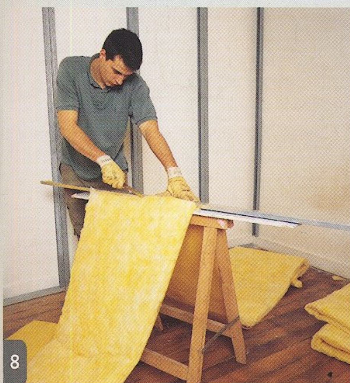
8 L'isolant se coupe avec un couteau denté. Les lés mesurent en longueur 1 cm de plus que la distance entre rails.
