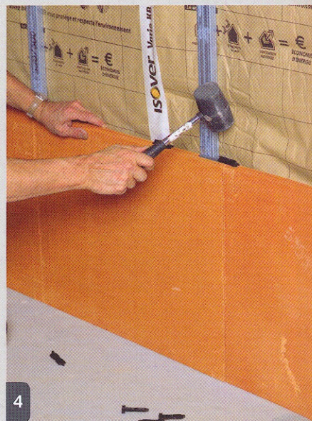
4 Des clavettes introduites dans la rainure des plaques assurent leur maintien et les solidarisent à joint constant.
