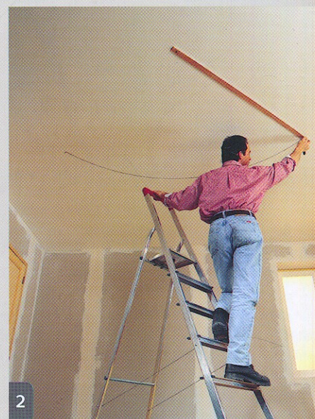
2 Pointer le clou du compas improvisé, fabriqué avec une cordelette ou une baguette, sur le repère et dessiner l'arc de cercle au plafond.
