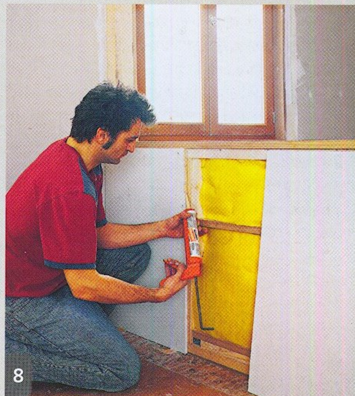
Les plaques Fermacell sont vissées des deux côtés de l'ossature qui intègre une laine minérale. Les joints sont collés.
