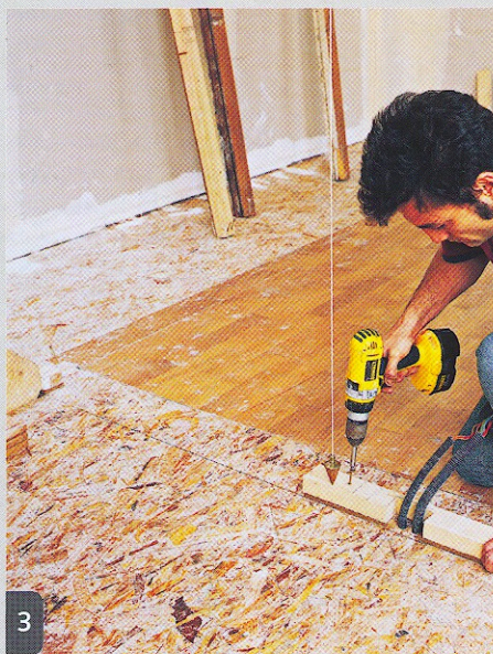
Sur le sol, les deux tasseaux placés de part et d'autre du passage intermédiaire sont vissés dans les mêmes conditions. Le fil à plomb détermine précisément le vis-à-vis.
