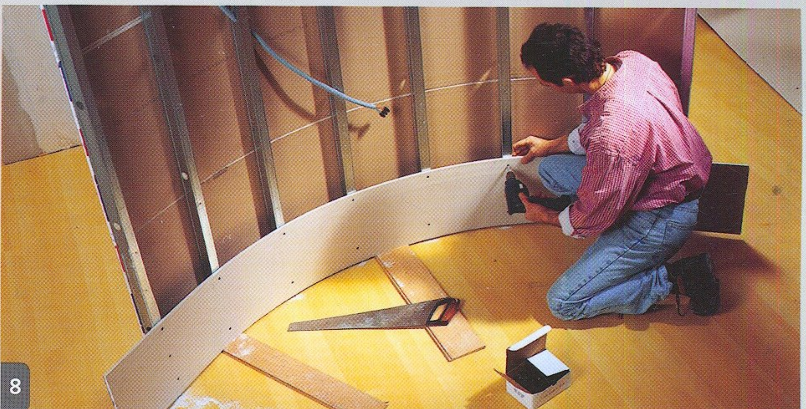
Si le sol n'est pas plan, la rangée inférieure est posée sur des cales. Le jour sera par la suite masqué par une plinthe ou bouché à l'enduit.
