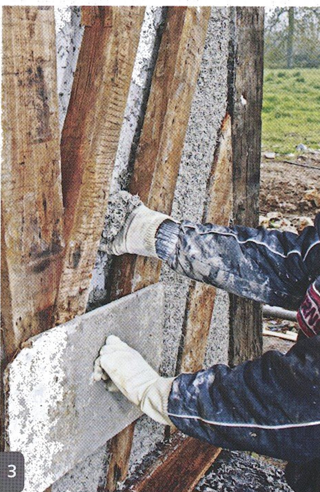
En plaquant une taloche en applique sur les bois, le béton est calé au nu de la structure.
