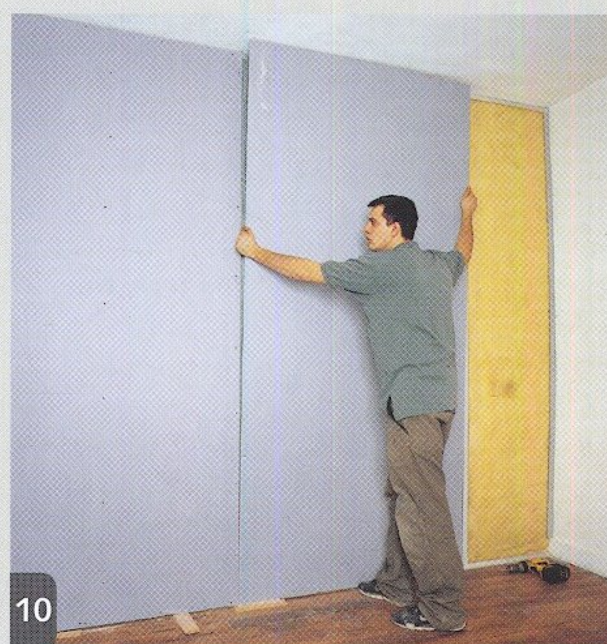
10 Les plaques reposent sur des cales et butent contre le plafond. Elles sont ajustées bord à bord.
